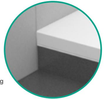
Auch für den teileingelassenen Einbau kommt unser Wannenabdichtband Aquaproof zum Einsatz, wenn die Unterkante des Wannenrandes bündig mit der Oberkante des Estrichs abschließt. Das Aquaproof wird hier von unten gegen den Wannenrand geklebt. Da das Wannenabdichtband aus Butyl besteht, können aufeinander treffende Überstände überlappt und miteinander verklebt werden. So wird ein dichter Übergang zwischen den Abdichtbandstreifen hergestellt. Ein zusätzliches Abdichtungsprodukt wird nicht benötigt.
