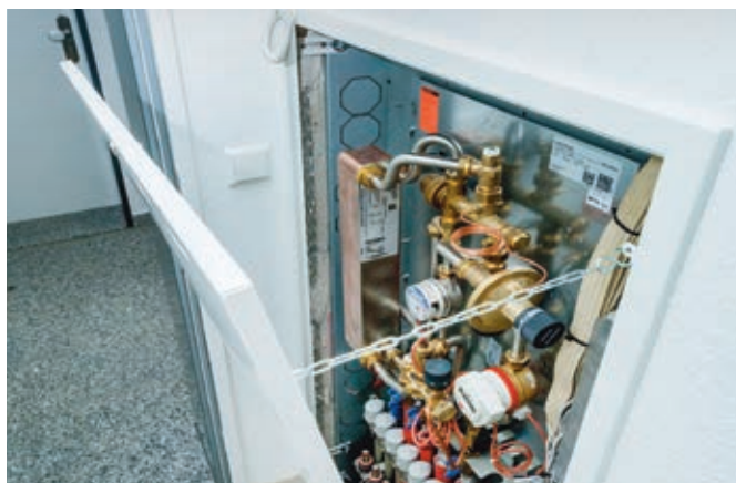
Frishwasserstationen in jeder Wohnung garantieren eine besonders hygienische Versorgung mit Trinkwasser.
