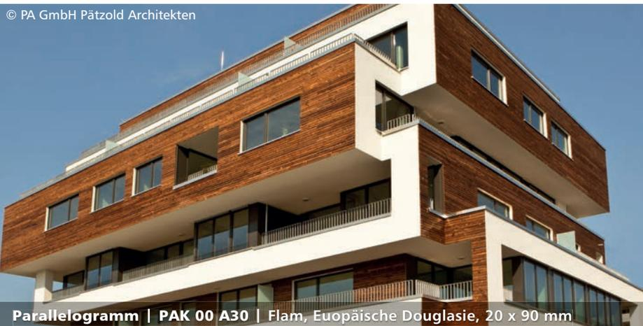
**Parallelogramm | PAK 00 A30 | Flam, Europäische Douglasie, 20 x 90 mm**
