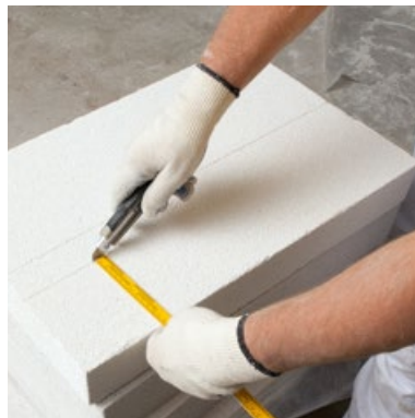
Platte ausklinken bei vorhandenen Leitungen
