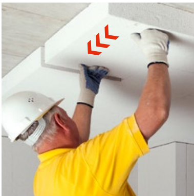
Multipor Mineralfüllplatte mit Leichtmörtel sofort im Abstand von ca. 2 cm zur vorherigen Platte an die Decke ansetzen und knirsch schieben (Fugen nicht mit verkleben!)
