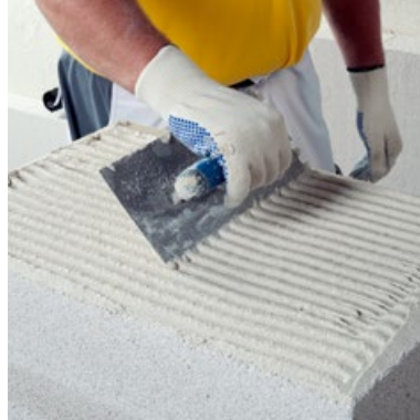
Mit mind. 12 mm Zahntraufel vollflächig auftragen und durchkämmen
