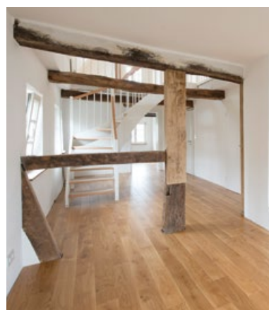
Hochwertiges Oberflächenfinish mit Multipor Lehmfarbe
