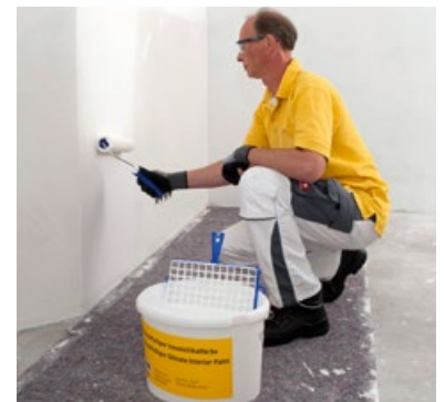
Auftragen der Multipor Innensilikatfarbe
