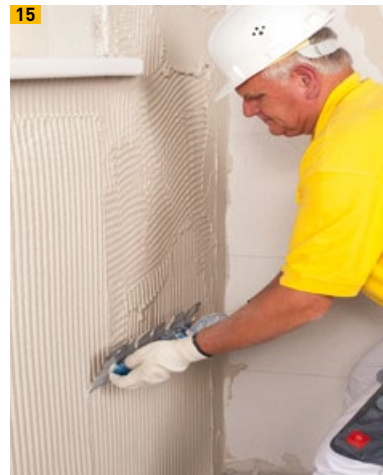
15 Armierungsschicht aufziehen
