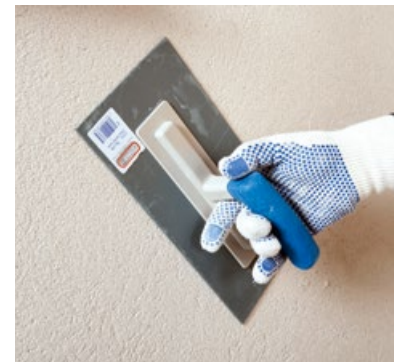
Strukturieren mittels Traufel
