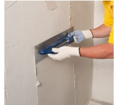
Aufziehen des Oberputzes
