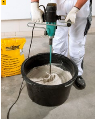
1 Multipor Leichtmörtel anmischen
