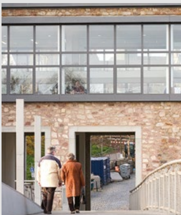
Vorhandene Portale neu integriert
