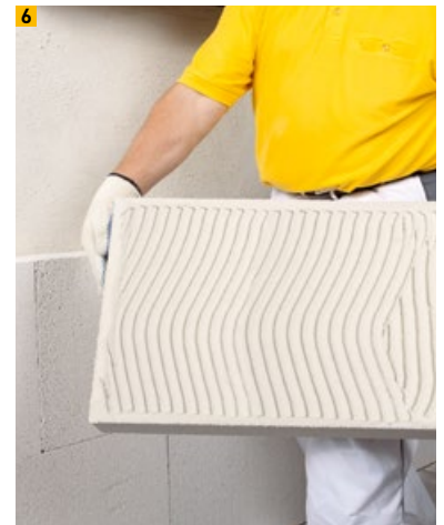
6 Mörtel vollflächig auf Mineraldämmplatte
