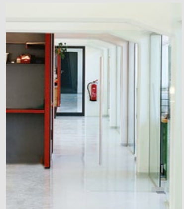
Neue Bauteile konnten integriert werden
