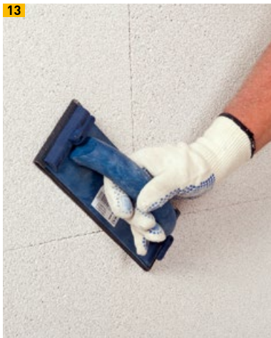
13 Unebenheiten beischiefen, Schleifstaub abfegen und eventuell grundieren
