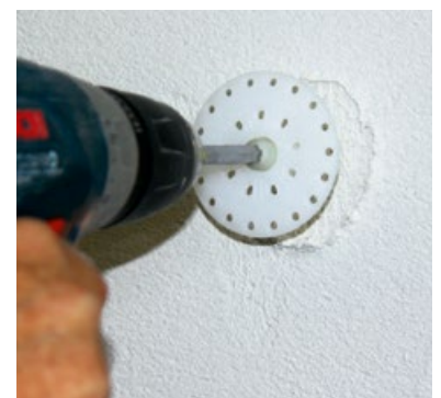
Setzen des Dübels durch das Gewebe
