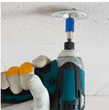
Gegebenenfalls verdübeln mit Multipor Deckenbefestigung für Decken MIT und OHNE Brandschutzanforderungen
