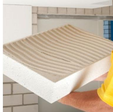
Steghöhe des Leichtmörtels ca. 10 mm. Unebenheiten im Untergrund bis 3 mm können so ausgeglichen werden.
