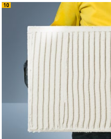
10 Stege aus Multipor Leichtmörtel
