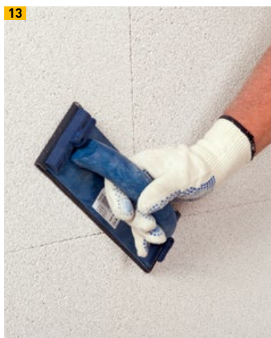
13 Unebenheiten beis Schleifen, Schleifstaub abfegen und eventuell grundieren
