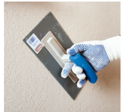
Strukturieren mittels Traufel
