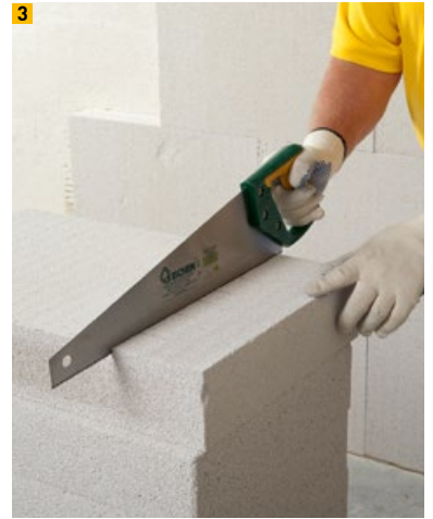
3 Multipor Mineraldämmplatte schneiden
