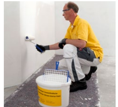
Auftragen der Multipor Innensilikatfarbe
