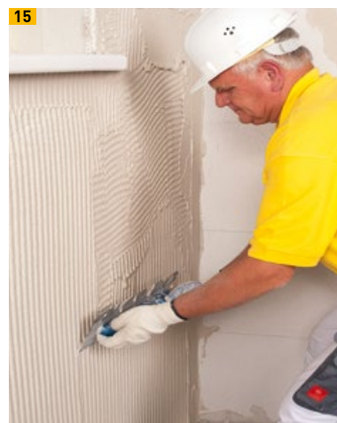
15 Armierungsschicht aufziehen
