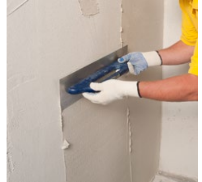
Aufziehen des Oberputzes
