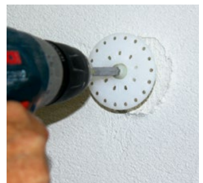
Setzen des Dübels durch das Gewebe
