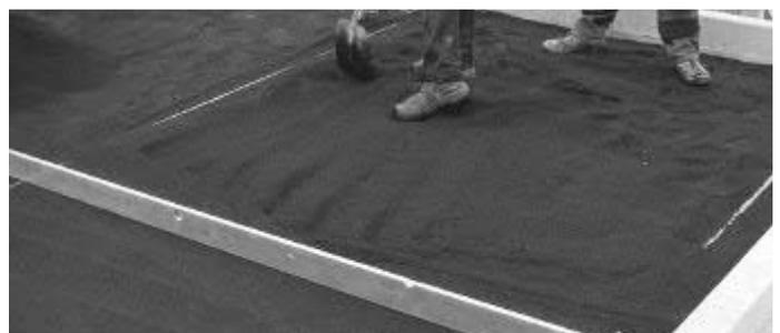
Körnung 0/5 mm sind zu bevorzugen. Entscheidend ist, dass die Fläche gleichmäßig abgezogen wird. Dazu eignet sich eine Richtlatte, die über zwei Kanthölzer oder Stangen als Schienen geführt wird. Nach dem Abziehen der Fläche darf die Bettung nicht mehr befahren oder betreten werden.
