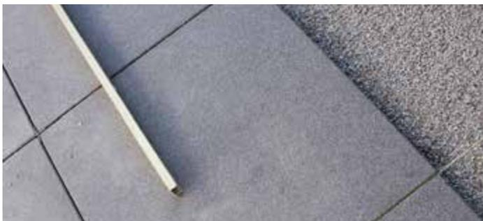
dass die Schicht wasserdurchlässig als Drainbeton aufgebaut ist. Bei allen Ausführungsarten auf einer festen, wasserundurchlässigen Unterkonstruktion ist unter allen Umständen zu vermeiden, dass sich Staunässe unter den Betonplatten bildet. Ist dies nicht ausgeschlossen, kann es an der Oberfläche der Platten zu feuchtigkeitsbedingten Verfärbungen und Ausblühungen kommen.
