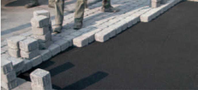
Unerwünschte Farbkonzentrationen sollten durch Mischen der Steine aus mehreren Paketen vermieden werden. Eine homogene Farbverteilung erzielt man, indem die Steine beim Verlegen aus mehreren Paketen gleichzeitig entnommen werden. Dies gilt insbesondere bei changierenden Farbtönen, ist aber auch bei einfarbigen oder grauen Pflastersteinen hilfreich, um ein harmonisches Gesamtbild zu erzielen.
