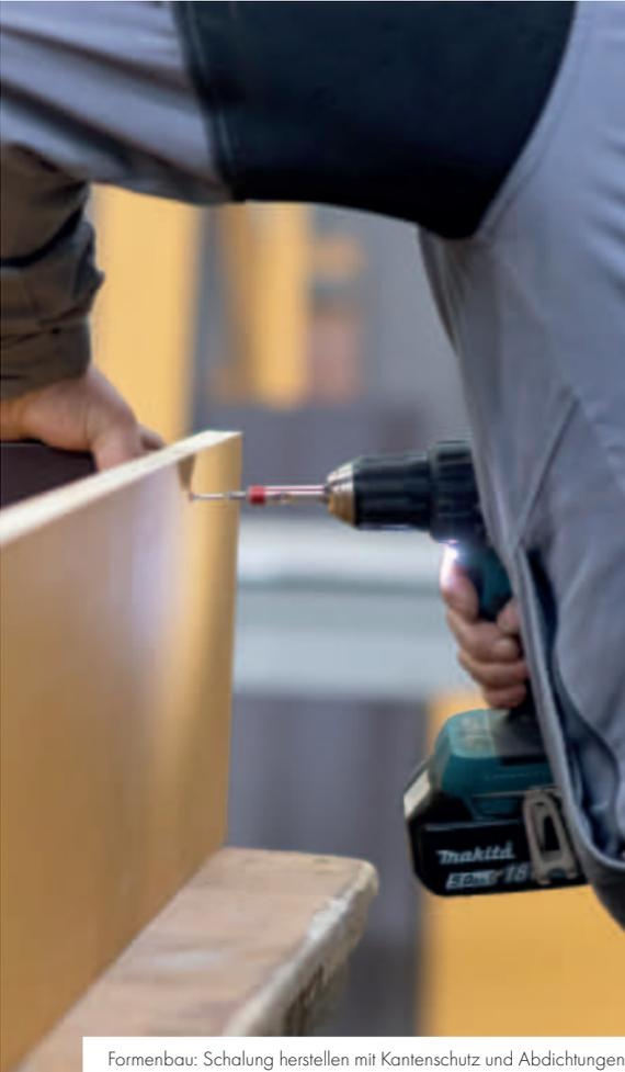
Formenbau: Schalung herstellen mit Kantenschutz und Abdichtungen.
