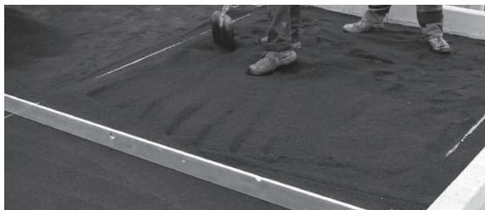
mische der Körnung 0/5 mm sind zu bevorzugen. Entscheidend ist, dass die Fläche gleichmäßig abgezogen wird. Dazu eignet sich eine Richtlatte, die über zwei Kanthölzer oder Stangen als Schienen geführt wird. Nach dem Abziehen der Fläche darf die Bettung nicht mehr befahren oder betreten werden.
