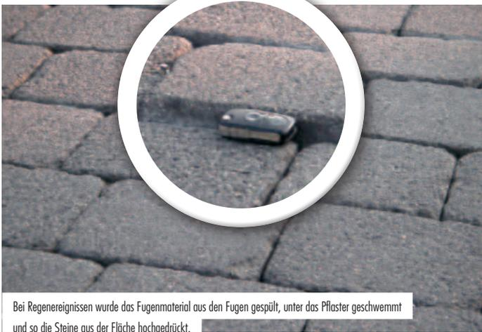
Bei Regenereignissen wurde das Fugenmaterial aus den Fugen gespült, unter das Pflaster geschwemmt und so die Steine aus der Fläche hochgedrückt.
