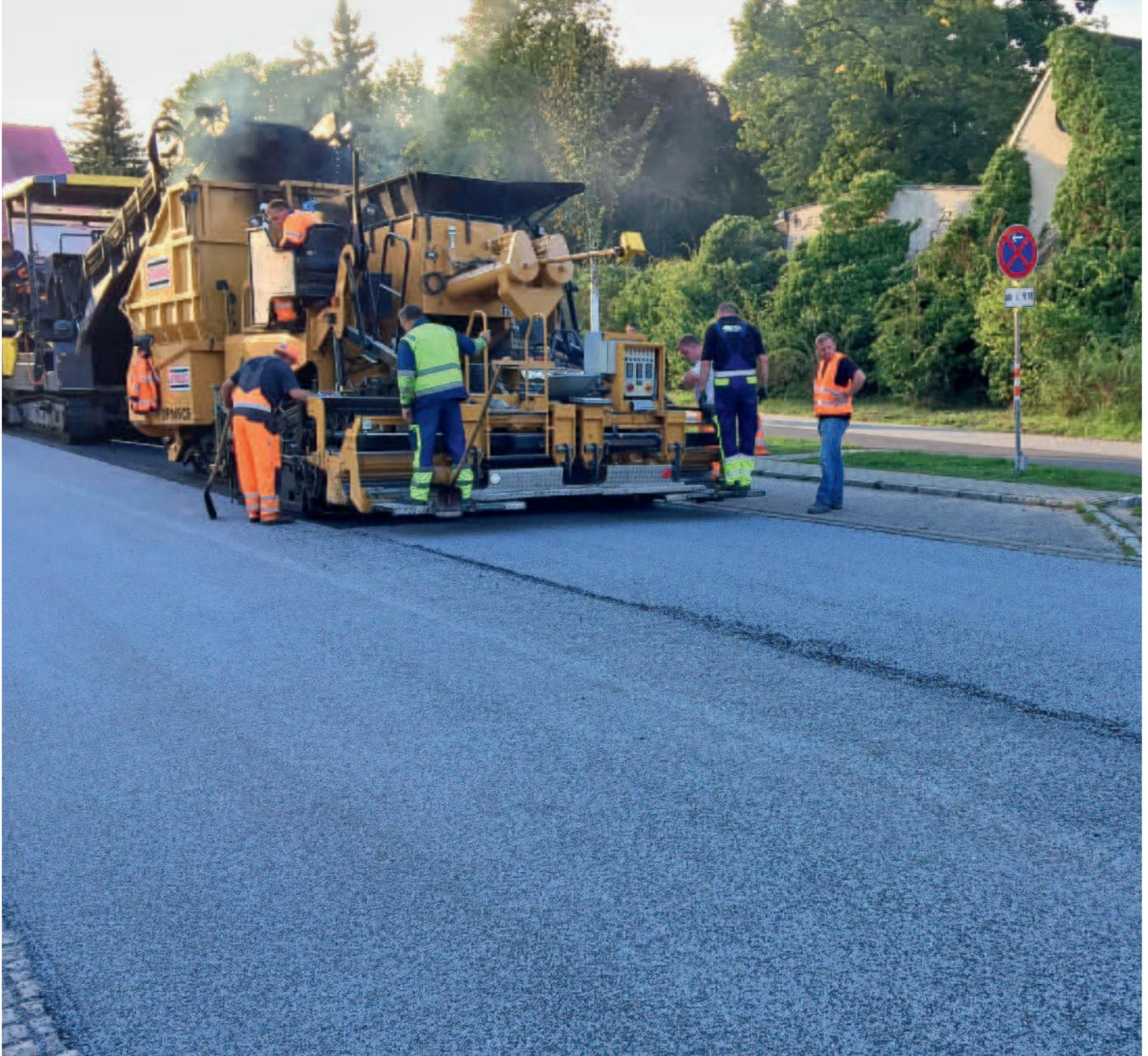
Um die Schadstoffreduzierung auch in einer stark verkehrsbelastenden städtischen Umgebung voll auszuschöpfen, wurde ein Straßenbelag entwickelt, der auch im Fahrbahnbereich eingebaut werden kann.
