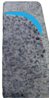
Durch Frostereignisse kommt es zu innerer Gefügezerstörung und endgültigem Versagen
