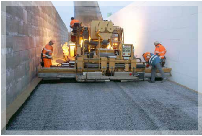
Aufbringung des AirClean®-Granulats
