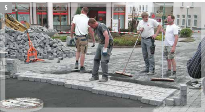
Verlegung der Pflastersteine
