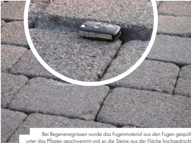
Bei Regenereignissen wurde das Fugenmaterial aus den Fugen gespült, unter das Pflaster geschwemmt und so die Steine aus der Fläche hochgedrückt.
