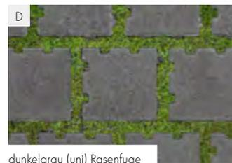
Sowohl bei der breiten, begrünbaren Rasenfuge als auch bei der schmalen Drainfuge ist die Versickerungsfähigkeit für Regenwasser – durchlässiger Unterbau vorausgesetzt – gewährleistet.
