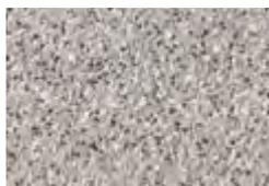
**gestrahlt** – Natursteinvorsatz, der auf der Oberfläche kugelgestrahlt wird
