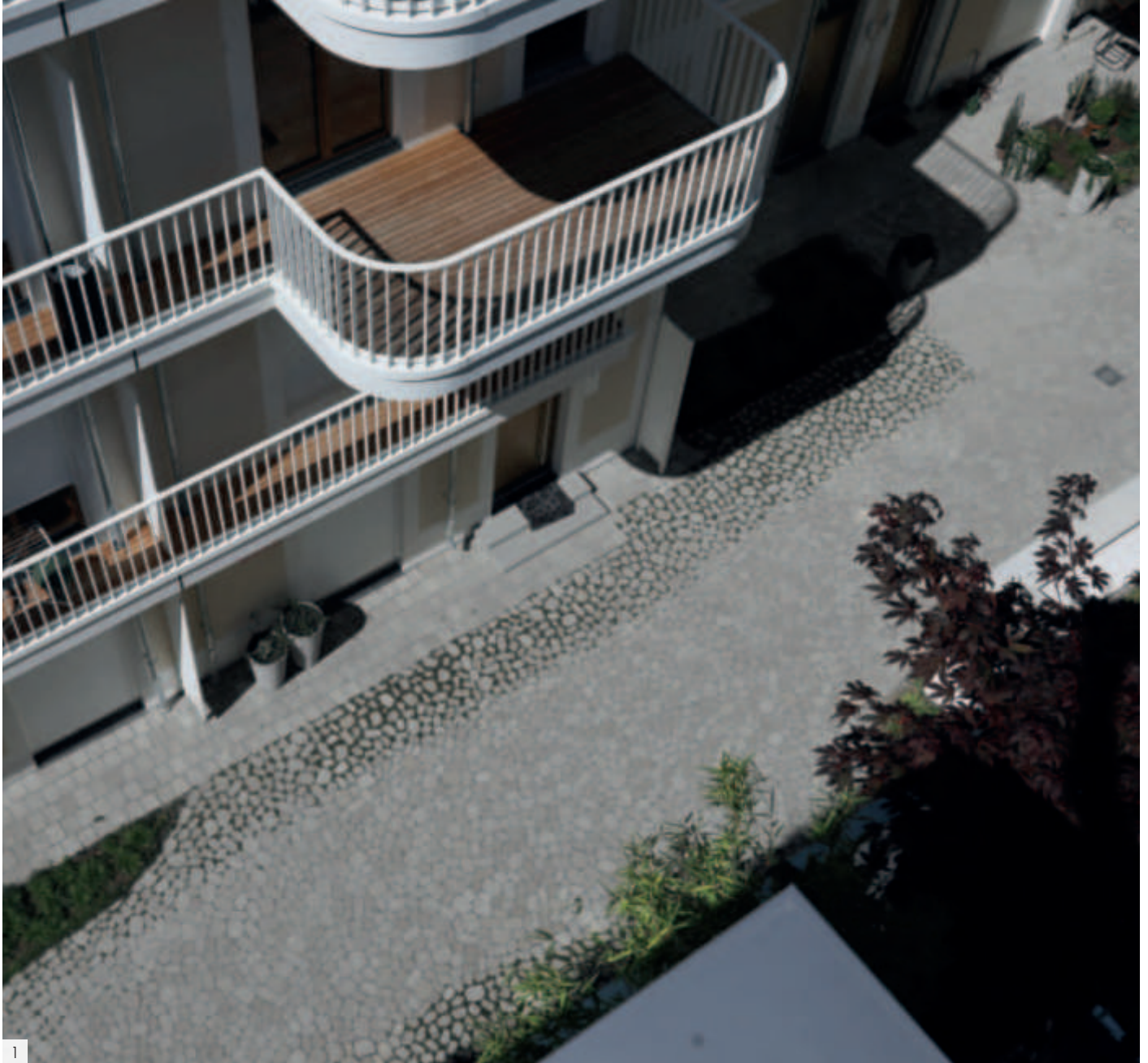
1-2 | Mehrformat 14-Stein-System | grau | V400 - wilder Verband
