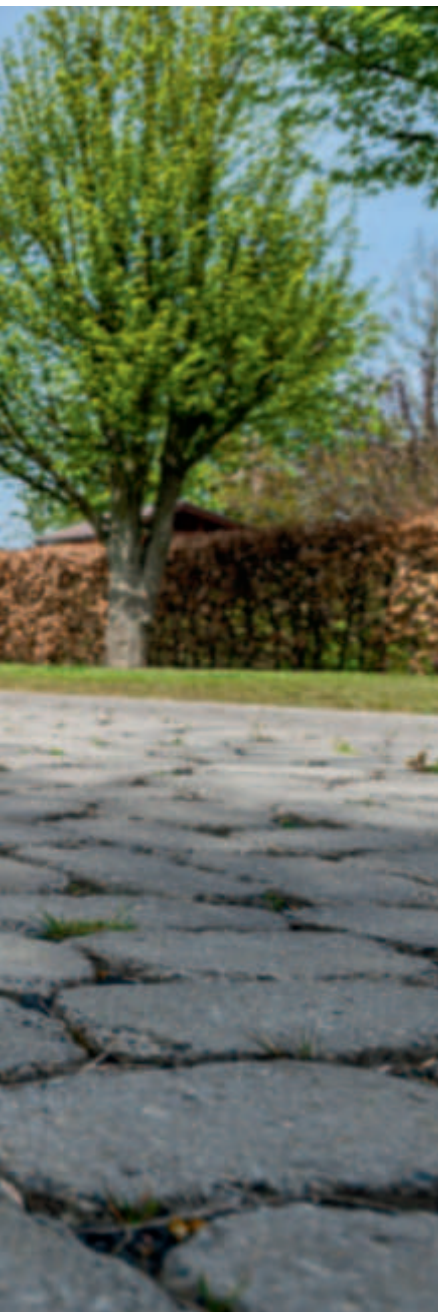
1-4 | Mehrformat 11-Stein-System | grau V400 - wilder Verband
