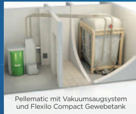
Das Vakuumsaugsystem transportiert die Pellets auf schonende Art vom Pelletlager zum Kessel.
