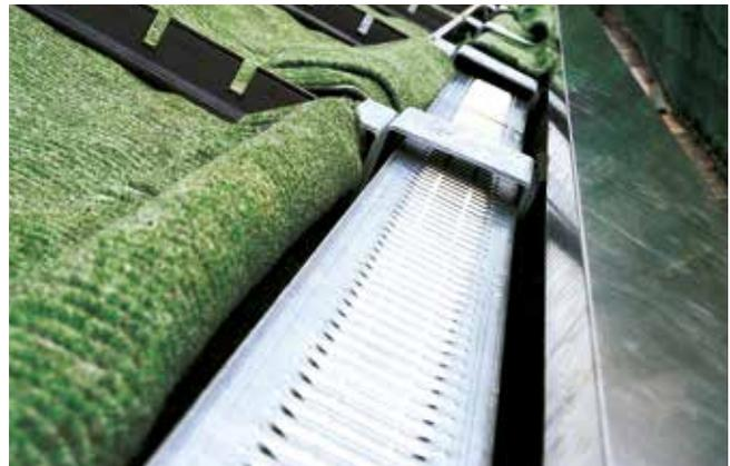
Innenliegende Optigrün-Entwässerungsrinne, darüber angeordnet das Optigrün-Struktur- und Speichervlies SSV 800
