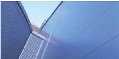
Sandwich-Paneele sind nichtbrennbare Elemente mit Deckschalen aus Stahl und einem Kern aus Steinwolle. Im Industrie- und Gewerbebau eignen sich die Elemente als wirtschaftliche Lösung für Außenwände, Innenwände und Decken.
