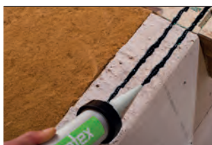
Abb. 18 Verkleben Anschlüsse und Bahnen
