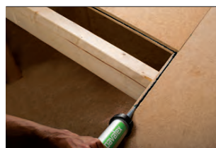
Abb. 19 Verkleben der Plattenstöße
