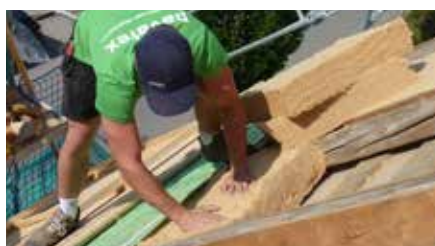
Abb. 2 Dachsanierung von außen ohne Beeinträchtigung des Innenraums.
