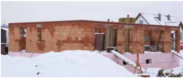
Abb. 1 Winterbaustelle mit starkem Feuchteintritt im Ziegelmauerwerk
