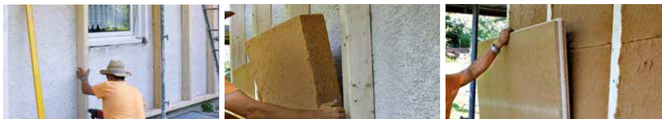
Abb. 2 Wandsanierung von außen: PAVAFLEX zwischen Holzständer und vollflächiger Holzfaser-Dämmung z.B. ISOLAIR.
