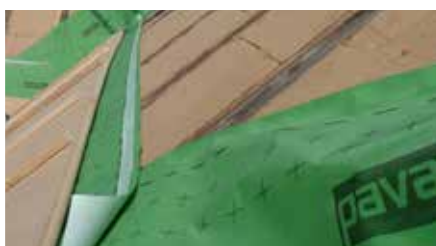
Abb. 2 Dachsanierung von außen ohne Beeinträchtigung des Innenraums.
