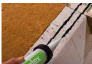
Abb. 8 Verkleben Anschlüsse und Bahnen
