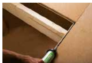
Abb. 9 Verkleben der Plattenstöße
