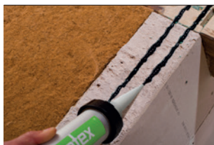
Abb. 9 Verkleben Anschlüsse und Bahnen
