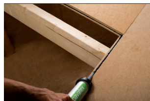
Abb. 10 Verkleben der Plattenstöße
