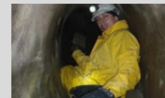
Aufbringen der sulfatbeständigen Dichtschlämme PCI Barraseal® im Bereich von Abwässern
