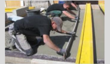
PCI Peciment® 50 auf einer Brücke nach ZTV-ING
