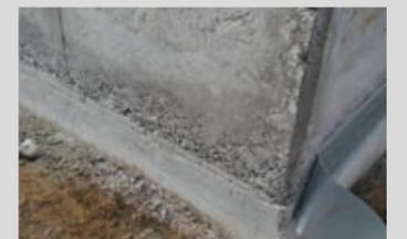
Abdichten einer Konstruktionsfuge mit PCI Pecitape® 3000
