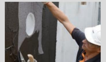
Einlegen einer PCI Gewebbahn im Bereich einer Rohrdurchführung
