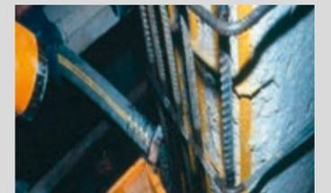
Einbringen des hochfesten, fließfähigen PCI Nanocret® R4 Fluid in einen Bereich mit dichter Bewehrungsanordnung
