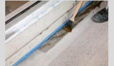
Das Aufbringen einer Grundierung mit PCI PUR-Grund erleichtert den Auftrag einer Kratzspachtelung
