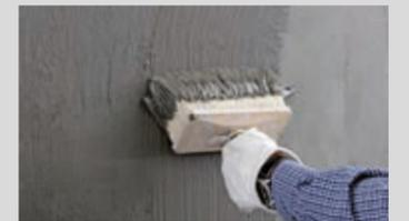
Aufbringen der mineralischen, sulfatbeständigen Abdichtung PCI Barraseal®
