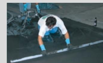
Estriche auf Dämm- und Trennlagen sind in homogenen Schichtdicken aufzubringen
