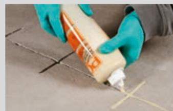
PCI Apogel® SH in eine Kartusche umfüllen, mischen und gleichmäßig in die vorbereitete Fuge füllen
