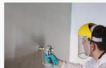
Maschineller Auftrag von PCI Polyflex® zum rissüberbrückenden Schutz gegen Karbonatisierung einer Tiefgaragenwand aus Beton
