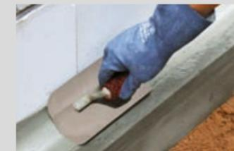
Scharfe Kanten brechen, Innenecken mit Reparaturmörtel PCI Nanocret® R4 PCC/ PCI Polyfix® Plus L als Dichtungs-/Hohlkehle ausbilden
