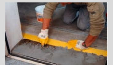
Ausgleich einer Schwelle oder Treppenstufe mit standfestem Epoxi-Mörtel PCI Aposan®
