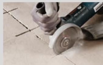
Estrich quer zur Arbeitsfuge einschneiden, aussaugen und PCI Estrichklammern bzw. PCI Apogel® Dübel einlegen
