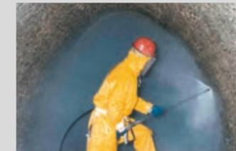
Vorbereiten einer geschädigten Betonoberfläche in einem Kanal
