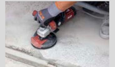
Alte Rückstände und Verunreinigungen durch Abschleifen entfernen.
