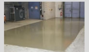
Ausgleich eines Betonbodens mit leichtverlaufendem Fließestrich PCI Zemtec® 180
