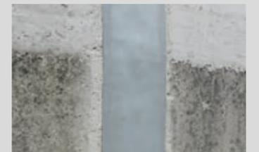
Abdichten von zwei Fertigbauteilen mit PCI Pecitape® 3000
