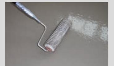
Das Material gleichmäßig verteilen und mit einer Stachelwalze entlüften
