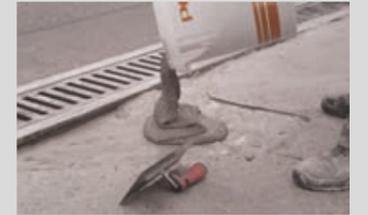
Fließfähiger Ausgleich einer Bodenfläche aus Beton mit PCI Repafast® Fluid
