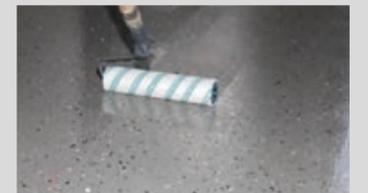
Die eingestreuten Farbchips müssen mit PCI Pursol® transparent versiegelt werden. Bei Beschichtungen ohne Farbchips kann die 2. Lage mit PCI Pursol® 1K farbig erfolgen.
