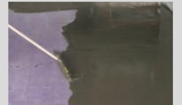
Nach 3 Stunden kann ein Bodenausgleich, z. B. mit PCI Zemtec® 1K, homogen aufgetragen werden
