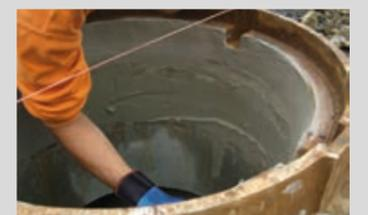
Auskleiden eines Schachtrings und Setzen mit PCI Polyfix® plus L
