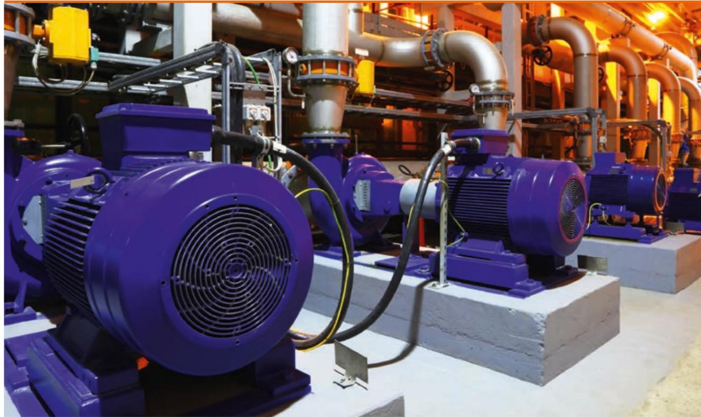
Für eine lange Lebensdauer und ein Minimum an Vibrationen sind Präzisionsvergussmörtel unumgänglich. Durch beste Verlaufeigenschaften und hohe Festigkeiten ermöglichen PCI Repaflow®-Vergussmörtel einen optimalen Lastabtrag auf das Fundament. Neben den rein zementären Systemen haben sich für starke dynamische Belastungen oder die Einbettung von Metallfüßen und Stützen Reaktionsharz-Vergussmörtel wie z. B. PCI Repaflow® EP Plus bewährt.
