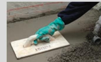
Der PCI Novoment® Schnellestrich muss frisch in frisch auf die Haftbrücke aufgebracht werden
