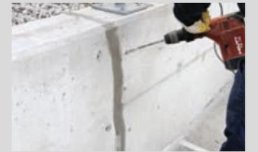
Bauteil schräg zum Rissverlauf abwechselnd rechts und links anbohren. Das Bohrloch muss den Riss etwa in der Mitte überschneiden
