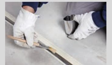
Primern der Fugenflächen und Abluftzeiten beachten. Hier: PCI Elastoprimer 110 bei saugenden Untergründen ca. 60 Minuten. Auf gleichmäßiges Einbringen des Fugendichtstoffs achten
