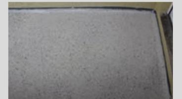
Der erste Auftrag von PCI Pursol® 1K wird mit PCI Farbchips 05 graniti abgestreut
