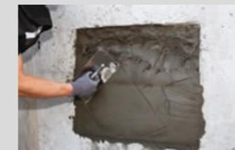
Den hochfesten Reparaturmörtel, z. B. PCI Nanocret® R4 PCC, satt und hohlraumfrei händisch oder maschinell auftragen
