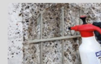
Vor der Betonsanierung Flächen mattfeucht vornässen, ggf. mit PCI Nanocret® AP grundieren
