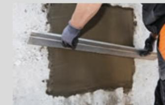
Die Reparaturflächen bündig abziehen und nach kurzer Wartezeit glätten bzw. abfilzen
