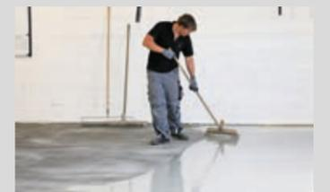
Verteilen mit Rakel und Stachelwalze
