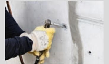
Den selbstdichtenden Packer in das zuvor gereinigte Bohrloch fest eindrehen
