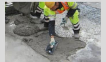
Standfester Bodenausgleich eines Betonausbruchs mit PCI Repafast® Tixo
