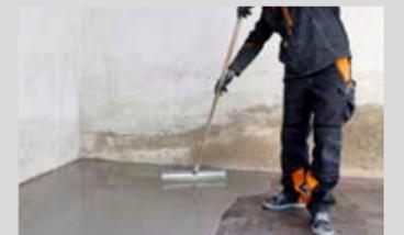
Angemischtes PCI Zemtec® 1K gleichmäßig verteilen und anschließend mit einer Stachelwalze entlüften.
