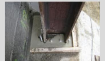
Verguss einer Stütze mit PCI Repaflow®
