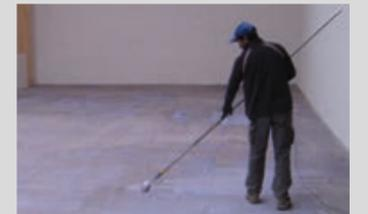
Vor dem Auftrag der fließfähigen Bodenausgleichsmasse PCI Gisogrund® 404 als Haftvermittler aufbringen
