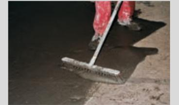
Aufbringen einer Mörtelhaftbrücke mit PCI Pecihaft®
