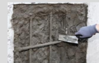
Kontaktschicht mit der ersten Lage Reparaturmörtel aufstreichen oder mit der Traufel aufkratzen
