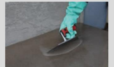
Die porenfreie Kratzspachtelung bestehend aus PCI PUR-Grund abgemischt mit Quarzsand 0,06 – 0,30 ermöglicht eine sichere Haftung und eine blasenfreie Aushärtung der nachfolgenden Beschichtung
