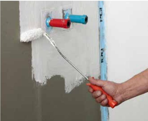
Zweilagiger Auftrag (in unterschiedlichen Farben) der Polymerdispersion PCI Lastogum®. Systemgeprüfte Dichtbänder und -manschetten PCI Pecitape® 120 und PCI Pecitape® 10x10.
