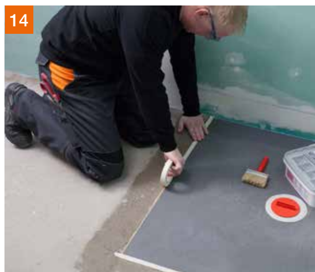
14 Tipp: Kleben Sie den schallentkoppelnden Randdämmstreifen mit einem Klebeband ab. Dann kann dort nichts dazwischenlaufen.
