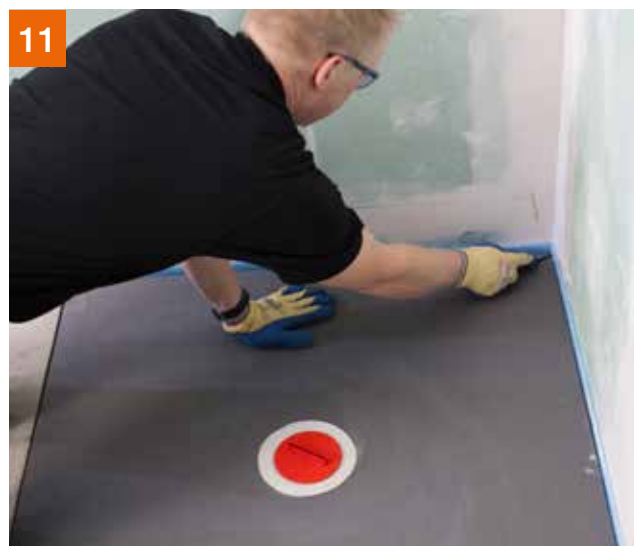
11 ...anschließend das PCI Pecibord® mittels Baustopfen fest mit dem Bodenablauf verschrauben. Der Baustopfen stellt sicher, dass der Bodenablauf durch nachfolgende Arbeitsgänge nicht verunreinigt wird.
