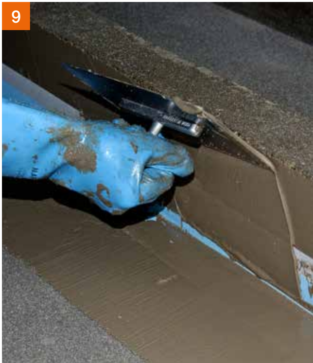
Anschließend noch einmal mit PCI Apoflex® überarbeiten.
