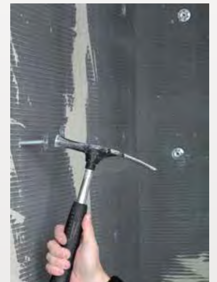
Zu guter Letzt die Schlagdübel einschlagen.
