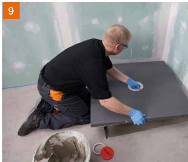
9 ... und das PCI Pecibord® ansetzen und andrücken, bis der Dichtungsring den Rand des Bodenablaufs sauber umschließt.
