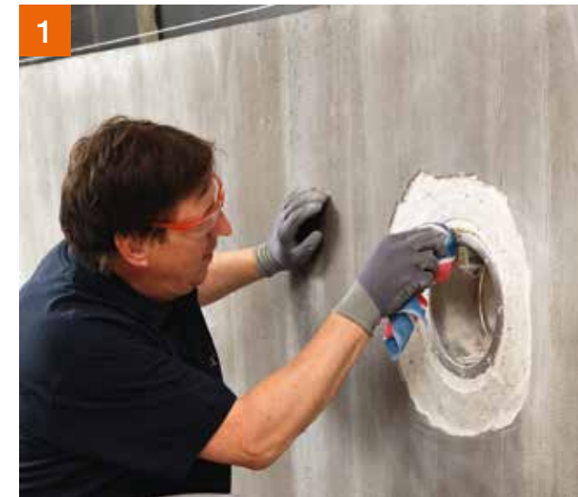
Professionelle Alternativlösung: Klemmflansch mit Dichtmanschette.
