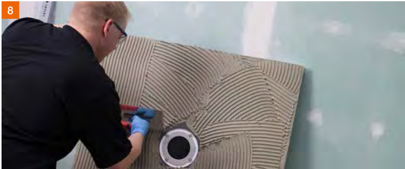
Zunächst eine Kratzspachtelung auf dem Unterbau und der Rückseite des PCI Pecibord® ausführen, den Kleber aufkämmen ...
