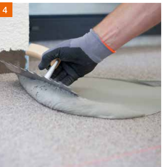
PCI Flexmörtel® S2 Rapid vorlegen und als Kratzspachtelung ausführen.
