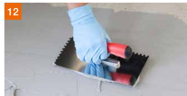
Kratzspachtelung mit PCI Seccoral® 2K Rapid ausführen.
