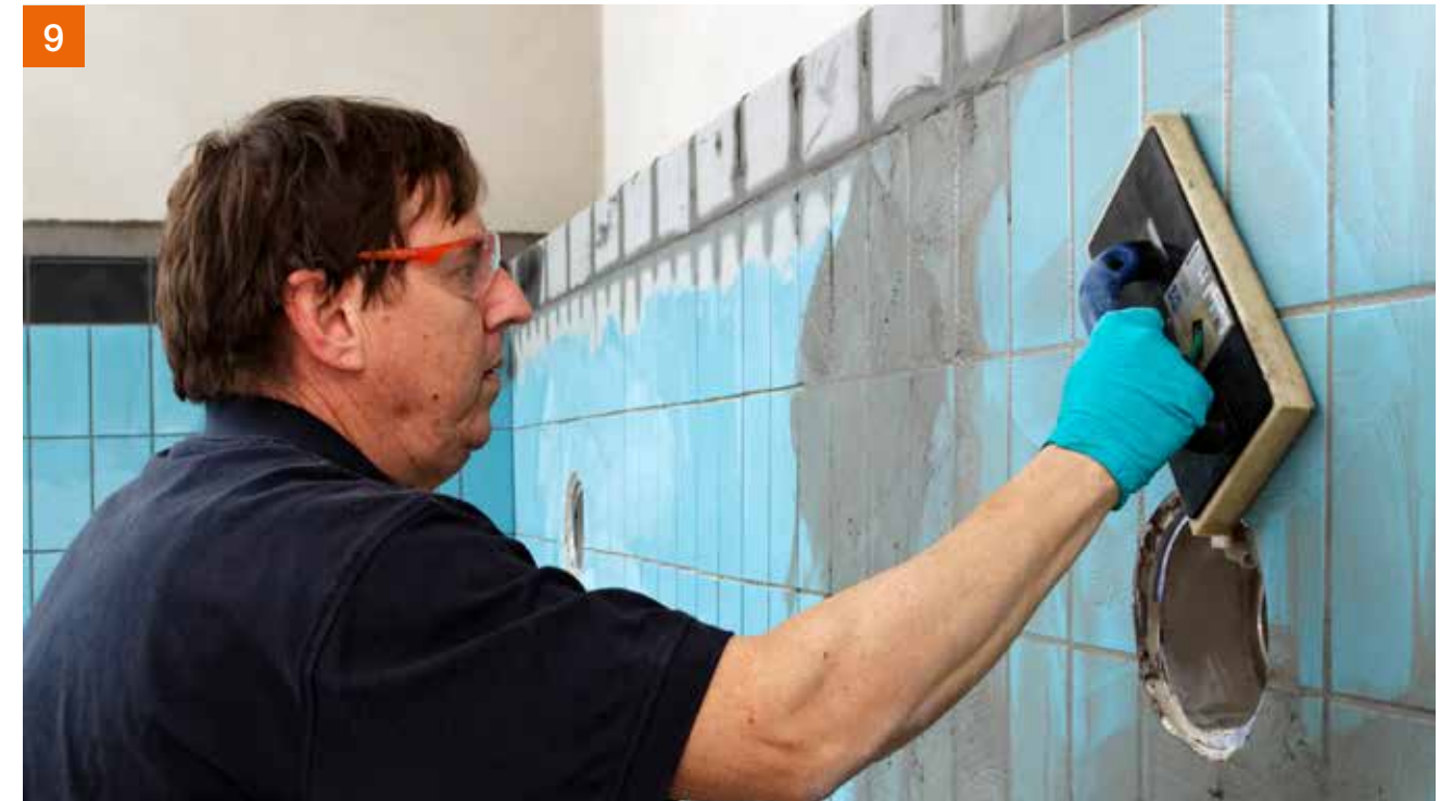
...und vorwaschen, sobald der Fugenmörtel stabil genug ist...
