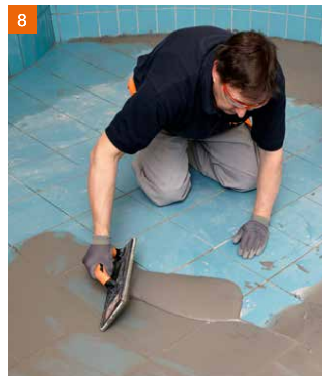
Am nächsten Tag erfolgt die Verfugung, zum Beispiel mit PCI Durafug® NT. Die Fläche einschlänmen ...
