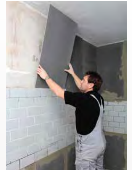
PCI Pecidur®-Element ansetzen und anschließend anklopfen.
