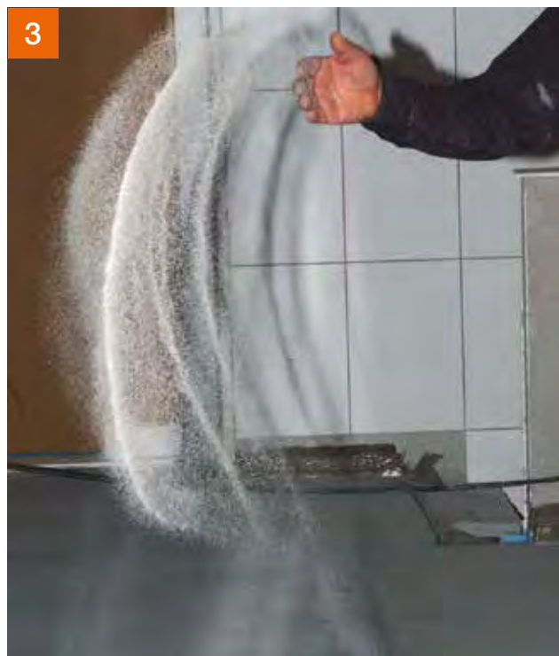
Zur besseren mechanischen Verkrallung mit dem Fliesenkleber PCI Apoflex® vollsatt mit Quarzsand abstreuen.
