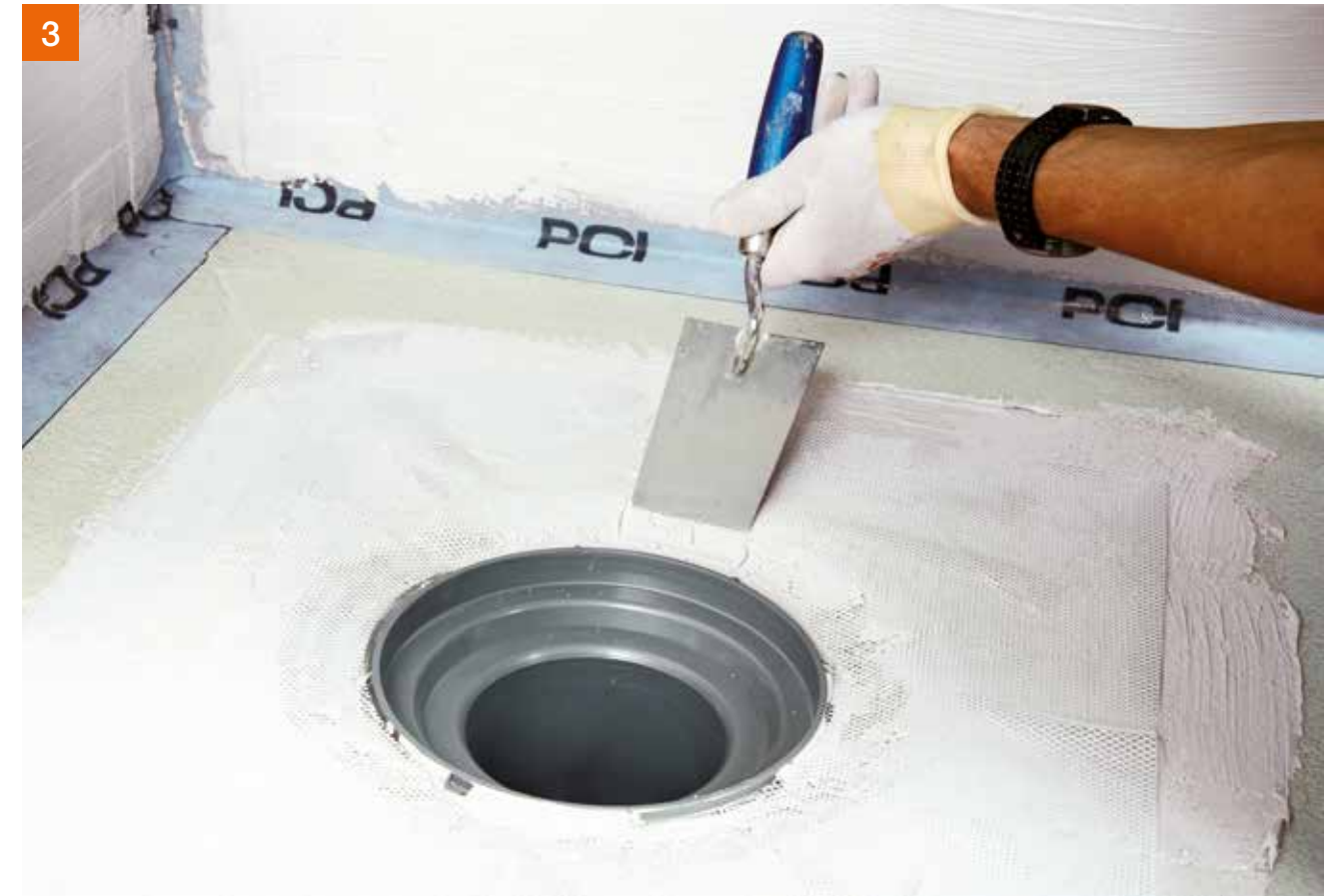
...anschließend das Gewebe entsprechend dem Gefälleverlauf andrücken und mit PCI Lastogum® überarbeiten. Nach Durchtrocknung (ca. 1 Std.) erfolgt der 2. Arbeitgang mit PCI Lastogum®.
