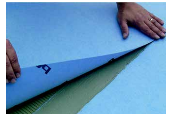
Zum wasserdichten Verkleben werden die Bahnenränder im Überlappungsbereich (ca. 5 bis 10 cm) mit einer Dichtschlämme (z.B. PCI Seccoral®) eingestrichen und innerhalb der klebeoffenen Zeit die folgende Bahn eingelegt und sorgfältig angedrückt.
