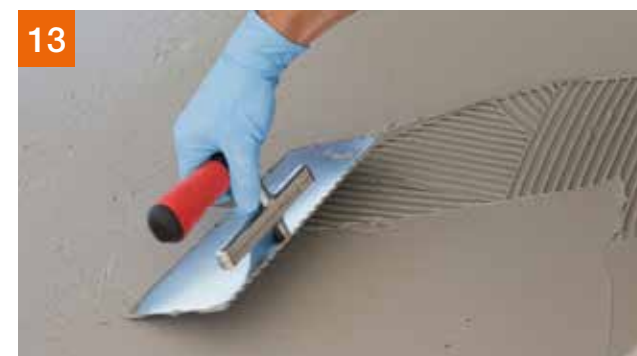
PCI Seccoral® 2K Rapid mit 6er Zahnung aufkämmen und anschließend glattstreichen.
