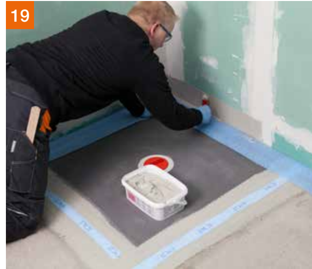
Nächster Schritt: Abdichten der Wand-/Bodenanschlüsse.
