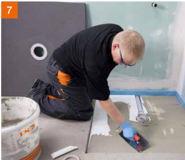
Fliesenkleber aufziehen, um das PCI Pecibord® mit dem Unterbauelement zu verkleben.
