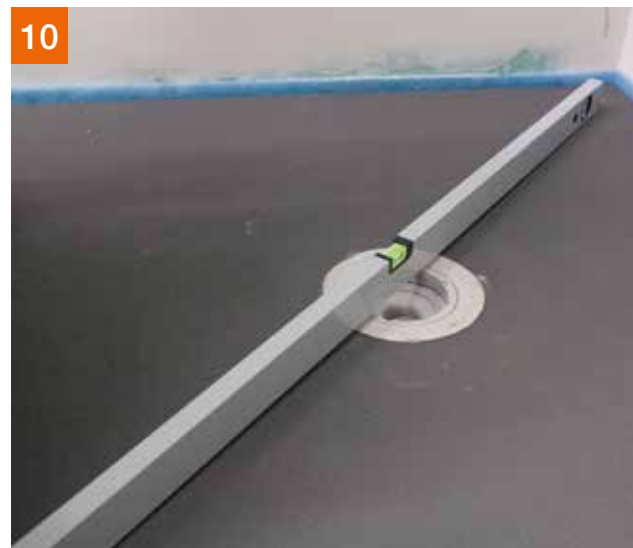
10 Korrekten Einbau mittels Wasserwaage prüfen und ...
