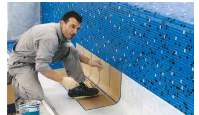
... werden keramische Beläge sicher auf Stahlkonstruktionen verlegt.
