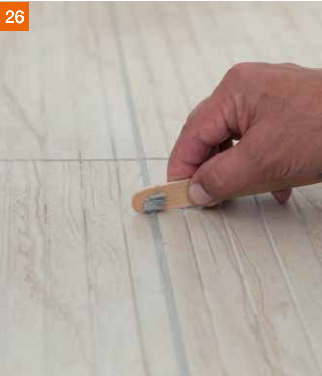
... und dann einfach die Fugen sauber abziehen.
