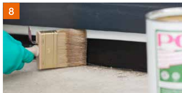
Element grundieren mit PCI Epoxigrund 390 ...
