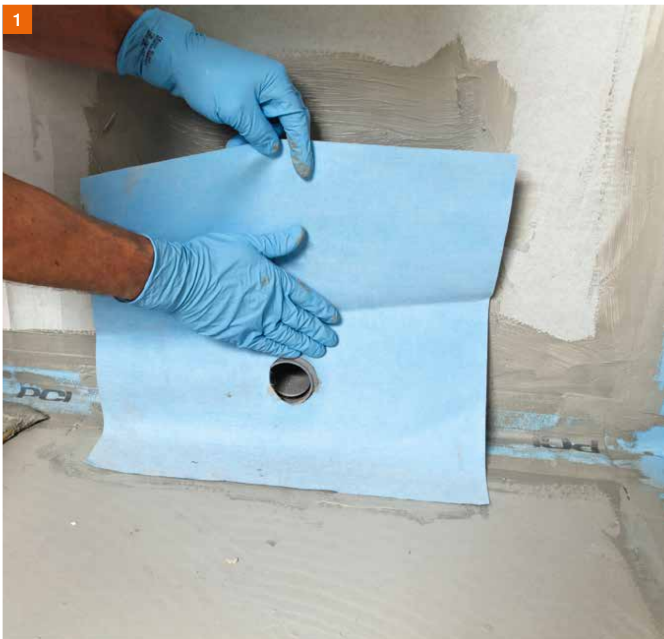
Rohrdurchführungen mit einem Durchmesser > 3/4" werden mit PCI Pecitape® 42,5 x 42,5 abgedichtet. Alternativ Dichtmanschette aus PCI Pecilastic® W erstellen.
