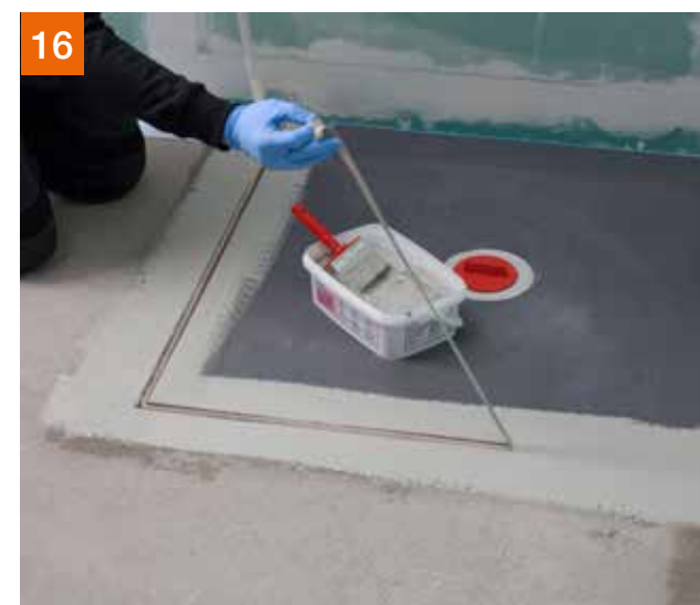
16 ... Klebestreifen abziehen ...
