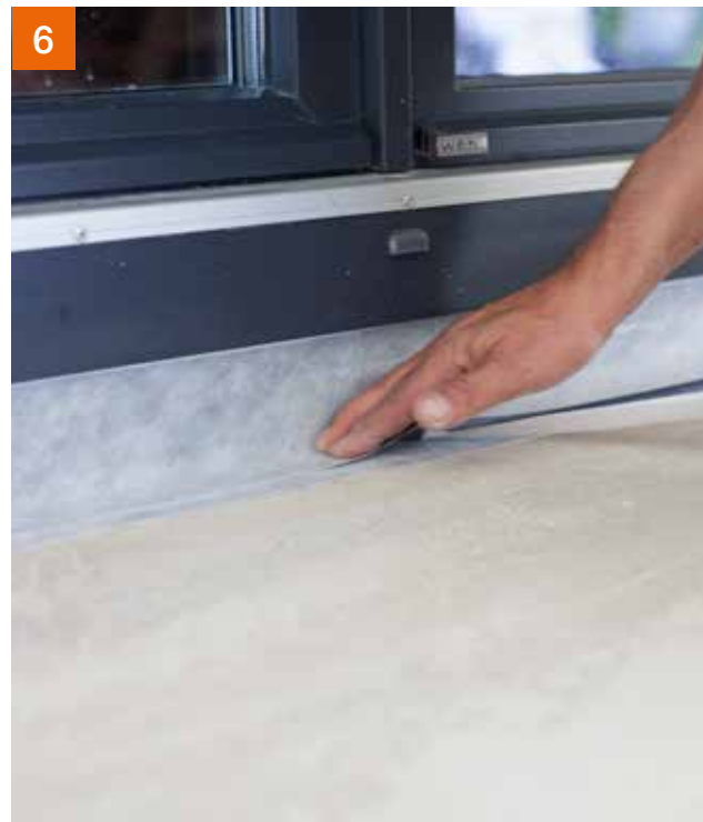
Detail Türabdichtung mit PCI Pecitape® WS: vorher gründlich reinigen.
