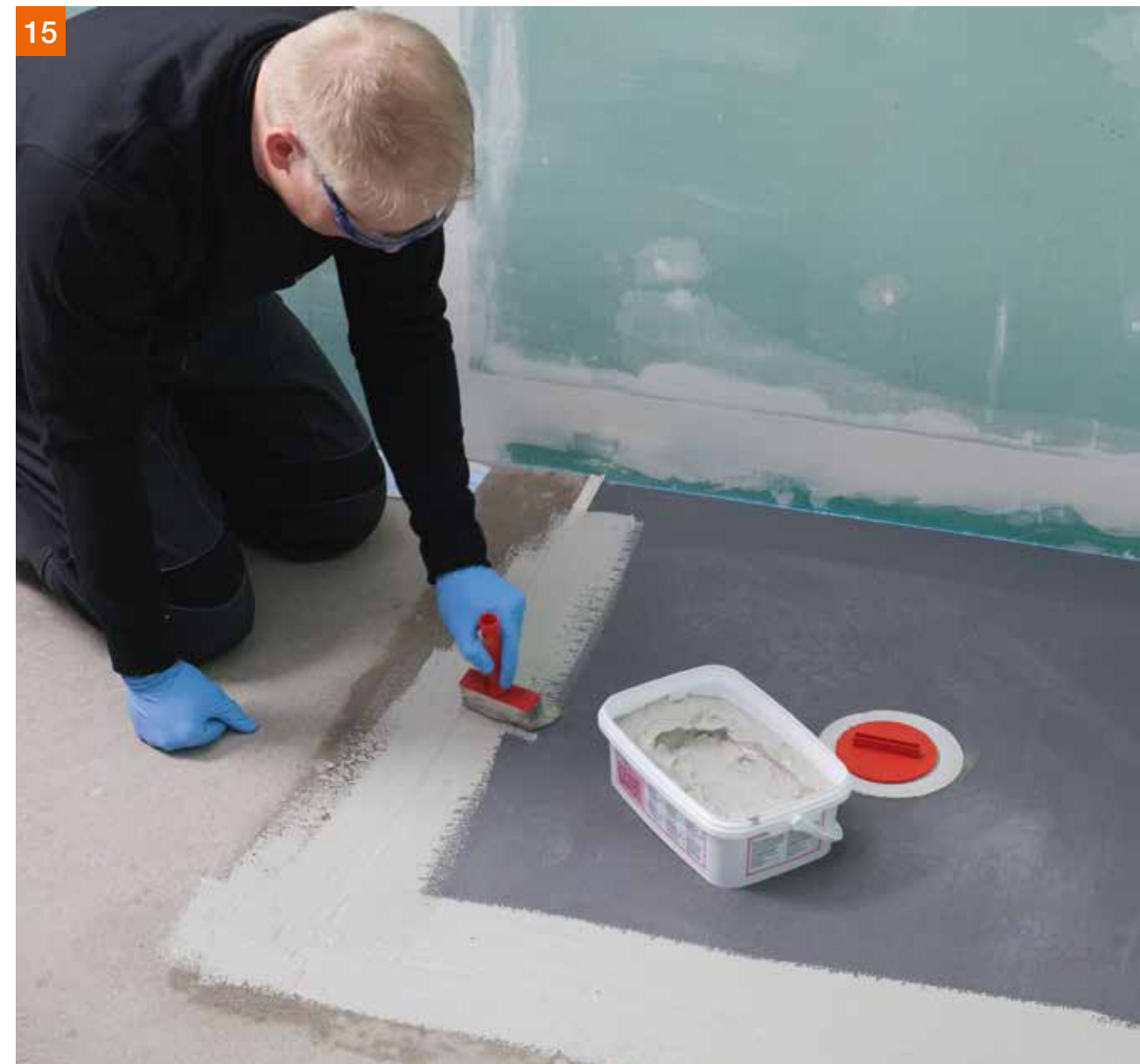
15 PCI Lastogum® als Kleber für die Abdichtbänder vorlegen ...
