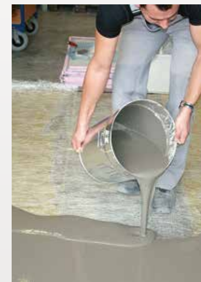
Die Bodenausgleichsmasse PCI Periplan® Extra in einer Mindestdicke von 10 mm ausgießen.
