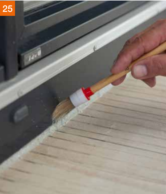
Zum leichteren Abziehen der Silikonfuge zum Beispiel PCI Glättmittel auftragen ...
