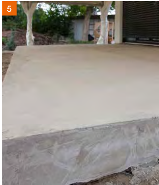
Terrassenplatte mit PCI Pericret® im Gefälle gespachtelt.
