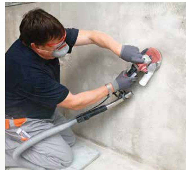
Grate und grobe Unebenheiten mittels Handfräse egalisieren.
