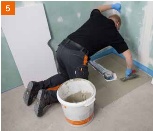
Die Höhenanpassung erfolgt mit Polystyrol-Hartschaumplatten in entsprechender Stärke.
