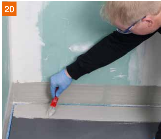
Abdeckung entfernen und im Randbereich PCI Lastogum® vorlegen.
