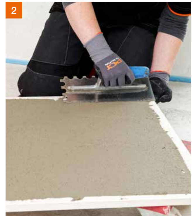
Aufbringen der rückseitigen Kratzspachtelung, um eine nahezu hohlraumfreie Verlegung zu gewährleisten.
