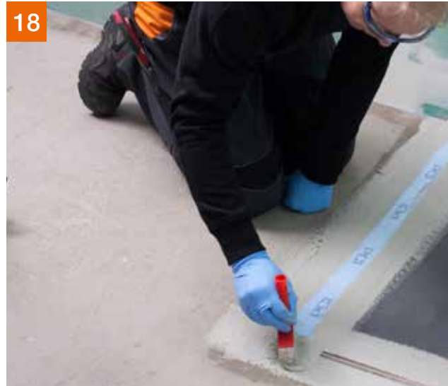
...und noch einmal an den Randbereichen mit PCI Lastogum® überstreichen.
