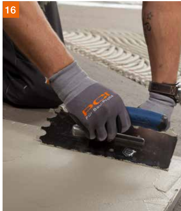
16 Kratzspachtelung mit PCI Flexmörtel® S2 Rapid auf der Fliesenrückseite aufziehen ...
