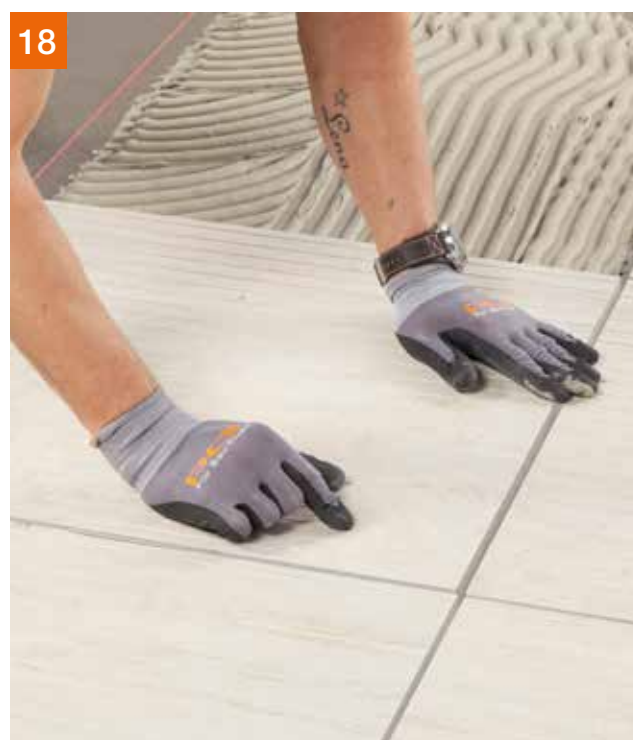
18 ... einschieben und ggf. mittels Gummihammer einklopfen. Danach ausrichten.
