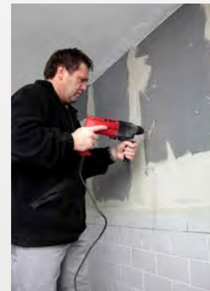
Nach Erhärtung des Klebemörtels werden die Bohrungen für die Dübel (ca. 5 Stck./m²) gesetzt.
