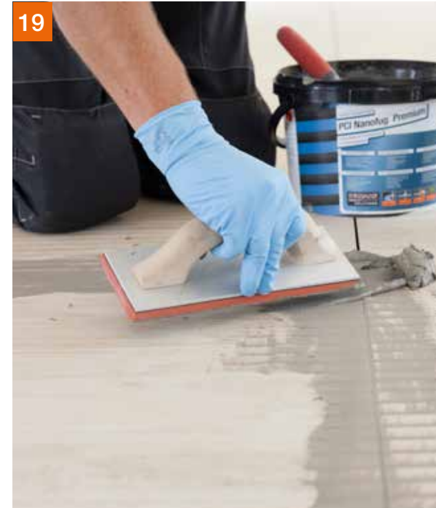
19 Fliesenbelag mit PCI Nanofug® Premium einfügen ...
