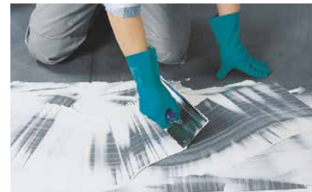
Mit dem verformungsfähigen Reaktionsharz-Fliesenkleber PCI Collastic® ...
