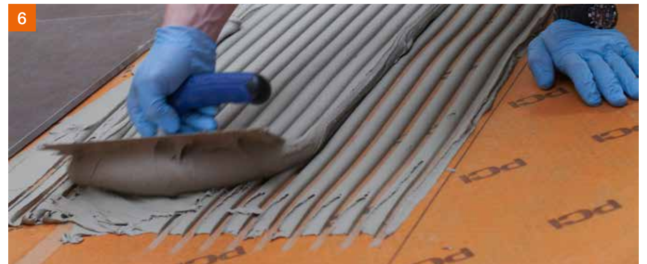
Verlegen der Fliesen mit PCI Flexmörtel® S2 Rapid.
