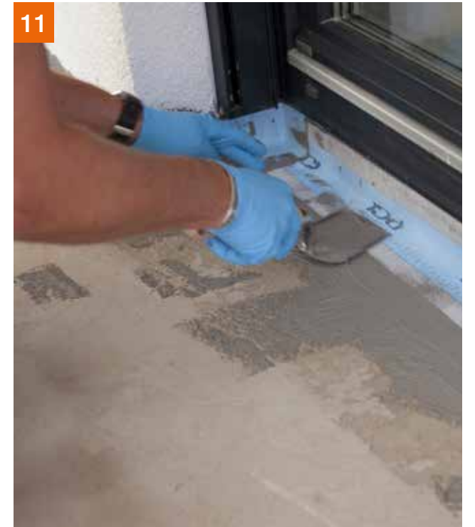
PCI Pecitape® 120 in PCI Seccoral® 2K Rapid einlegen.
