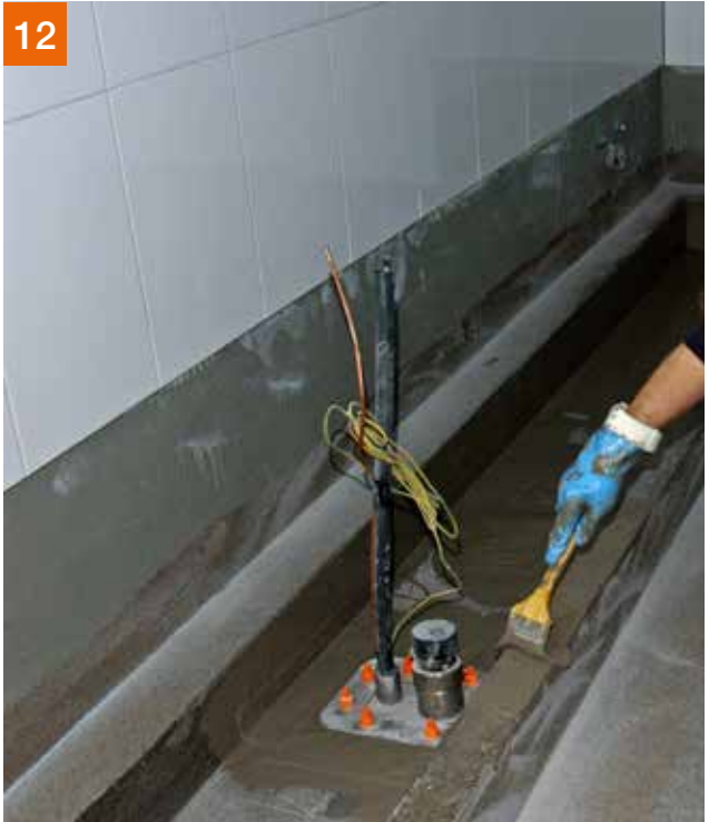
... sowie Durchdringungen mit PCI Epoxigrund 390 grundieren.
