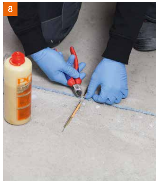
PCI Apogel® Dübel in die Nut einlegen und den Spanning entfernen.
