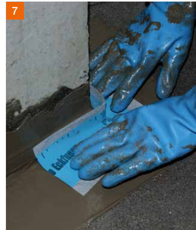
Formteil PCI Pecitape® 90° in die Abdichtungsschicht einlegen ...
