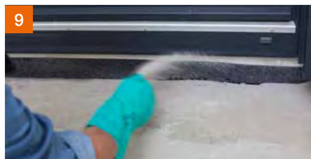
... anschließend die Grundierung absanden.
