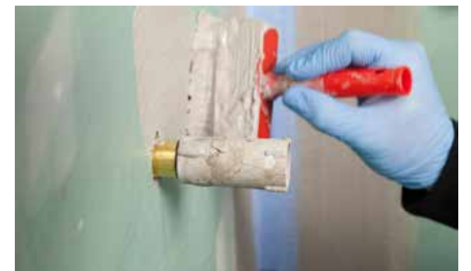
Beispiele für Rohrdurchführungen.
