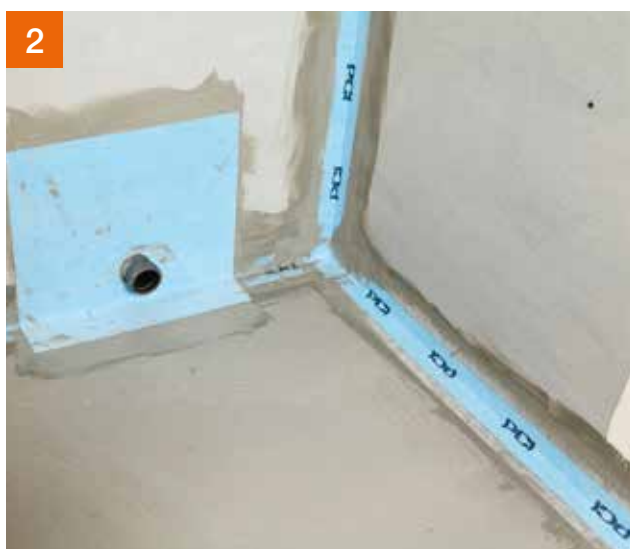
Wichtig: Abdichtungen müssen immer zweilagig aufgetragen werden.
