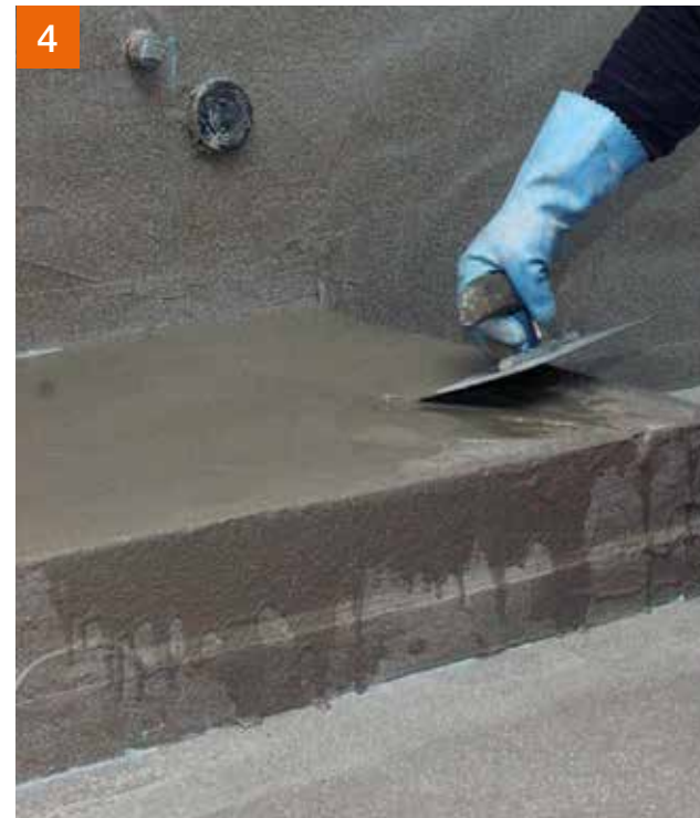
1. Arbeitsgang PCI Apoflex® F.
