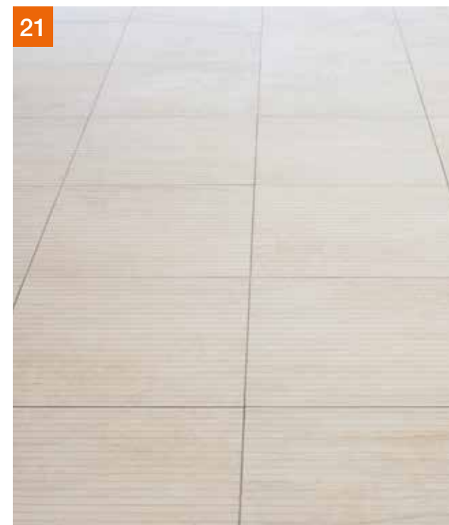
21 Der fertiggestellte und verfugte Fliesenbelag.
