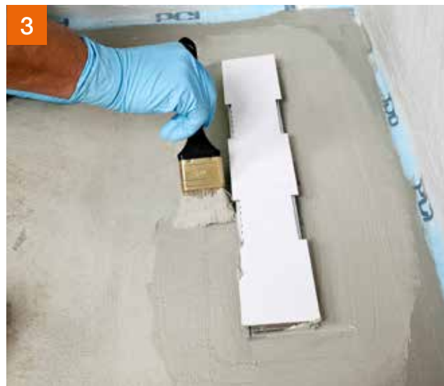
PCI Lastogum® oder PCI Seccoral® 2K Rapid als Kleber für das werksseitig mitgelieferte Gewebe vorlegen ...
