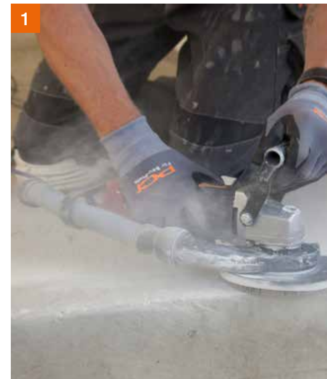
1 Untergrundvorbereitung: Grate entfernen.
