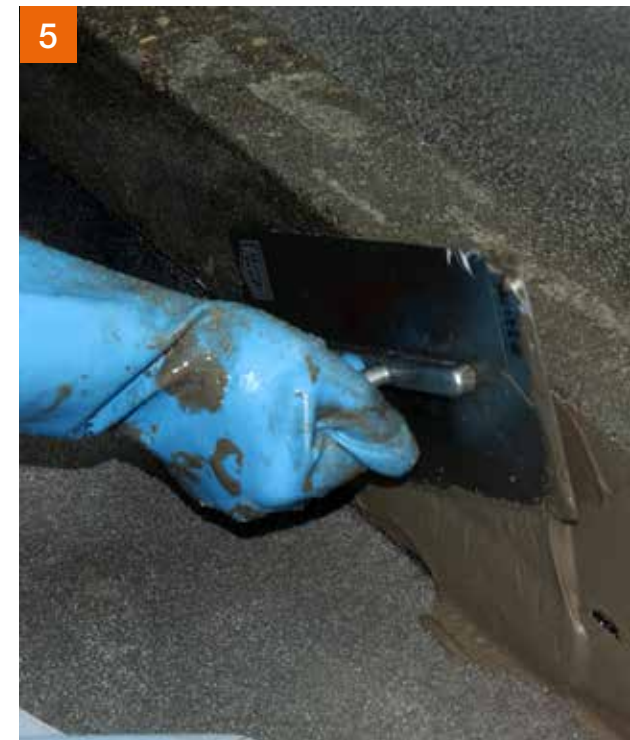
Vor dem Verkleben der Abdichtbänder wird PCI Apoflex® vorgelegt ...
