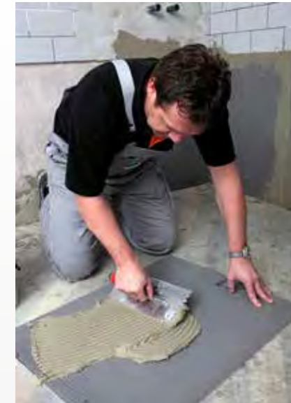
Den Klebemörtel mittels Zahntraufel auf der Plattenrückseite aufziehen. Bei größeren Unebenheiten kann in der „Batzenmethode“ gearbeitet werden.
