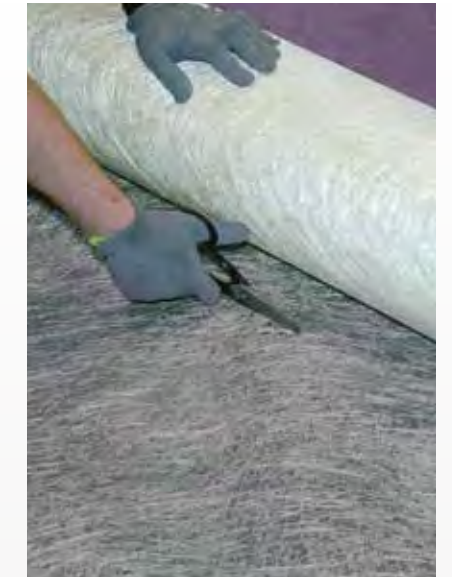
Das Glasfasergelege der PCI Armiermatte GFM mit einer Schere zurechtschneiden und auf dem grundierten Untergrund auslegen bzw. ausrollen.
