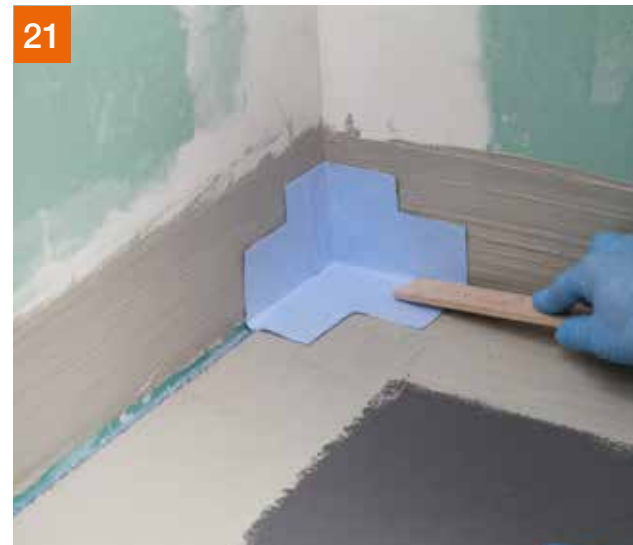
PCI Innenecke | 90° einbauen...
