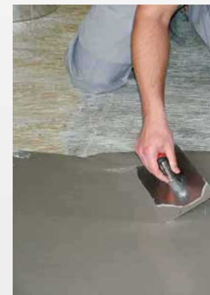
Mit einer Glättkelle verteilen (keine Rakel verwenden!) ...
