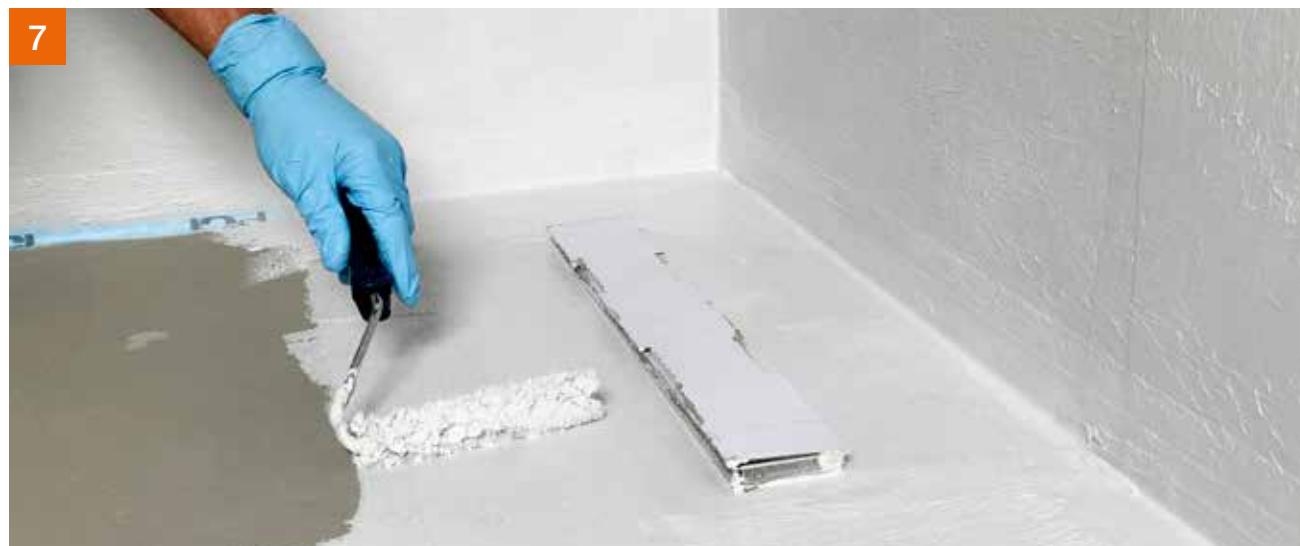
Nach einer Wartezeit von ca. 1 Stunde erfolgt der 2. Auftrag.
