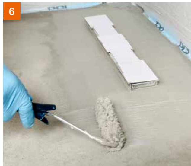
Anschließend die Entwässerungsrinne mit zwei Arbeitsgängen in die Flächenabdichtung einbinden.
