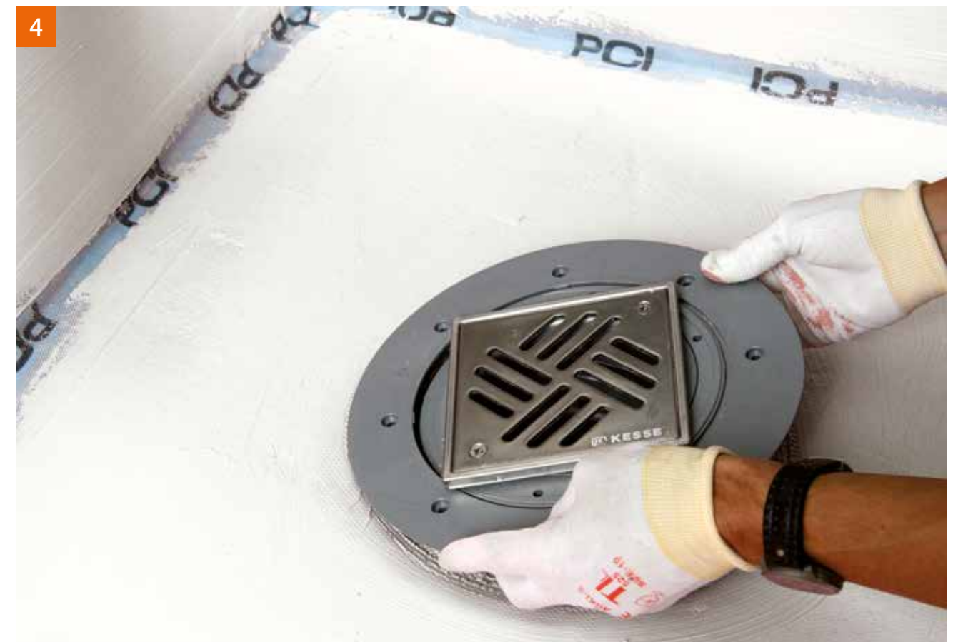
Klemmflansch aufsetzen und festschrauben.
