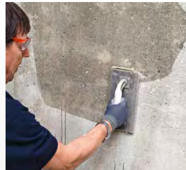
Zur Regulierung des Saugverhaltens den Untergrund leicht anfeuchten oder abhängig von der nachfolgenden Anwendung mit PCI Gisogrund® oder PCI Gisogrund® 404 grundieren.
