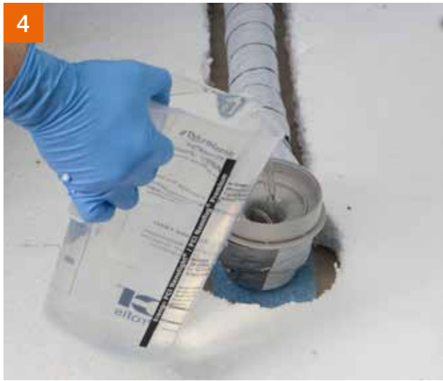
Vor Beginn der weiteren Arbeiten wird eine Dichtigkeitsprüfung durchgeführt.
