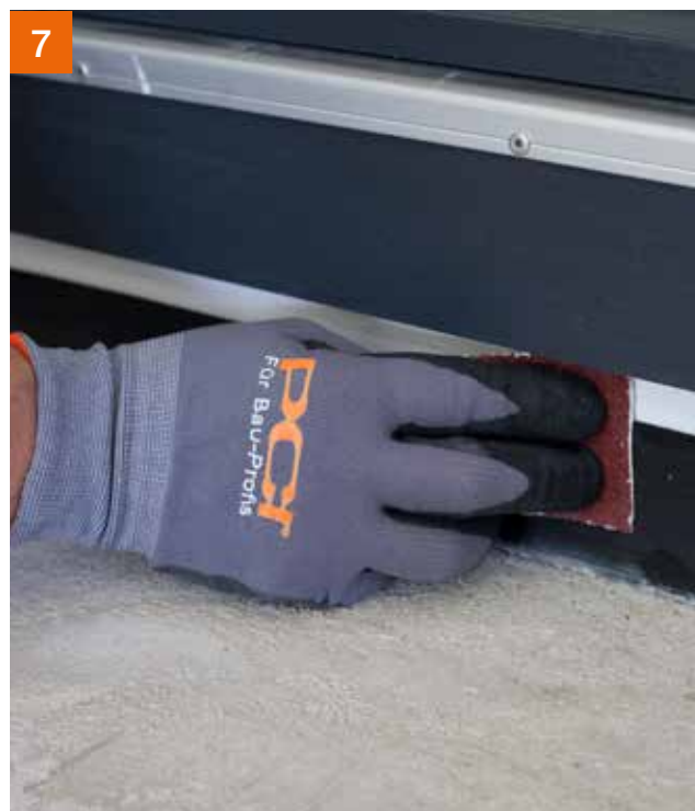
Detail Türabdichtung mit PCI Pecitape® 120: Element anschleifen und anschließend reinigen mit PCI Univerdünner.
