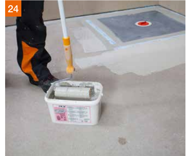
Anschließend Ausführen der Flächenabdichtung: 1. Auftrag mit PCI Lastogum® im Farbton grau.
