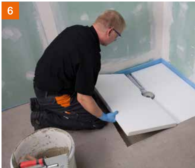
Die Platten werden untereinander mit einem Klebemörtel, zum Beispiel PCI Flexmörtel® S1, verklebt. Tipp: Höhe der Estrich-Konstruktion – Randstärke PCI Pecibord® – 5 mm für Fliesenkleber = Stärke der EPS-Platten
