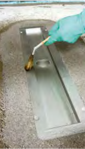
Andichten an den Edelstahl-Flansch einer Abflurinne: Grundieren mit PCI Epoxigrund 390, Abstreuen mit Quarzsand 0,3-0,8. Auftragen von PCI Seccoral® 2K Rapid und Einlegen von Dichtband PCI Pecitape® 120/250.
