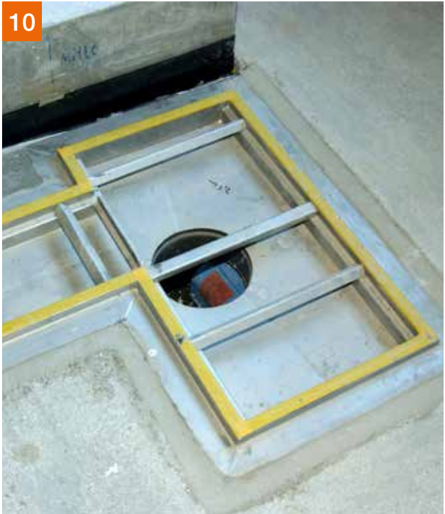
Einbauteile, Abläufe, Durchdringungen, Rinnen und Schwallmulden werden in die Flächenabdichtung eingebunden.
