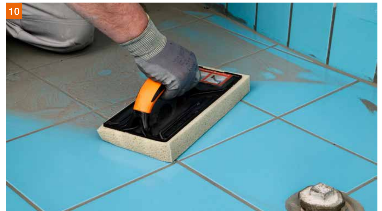
... und anschließend die Fläche nachwaschen und sauber abziehen.
