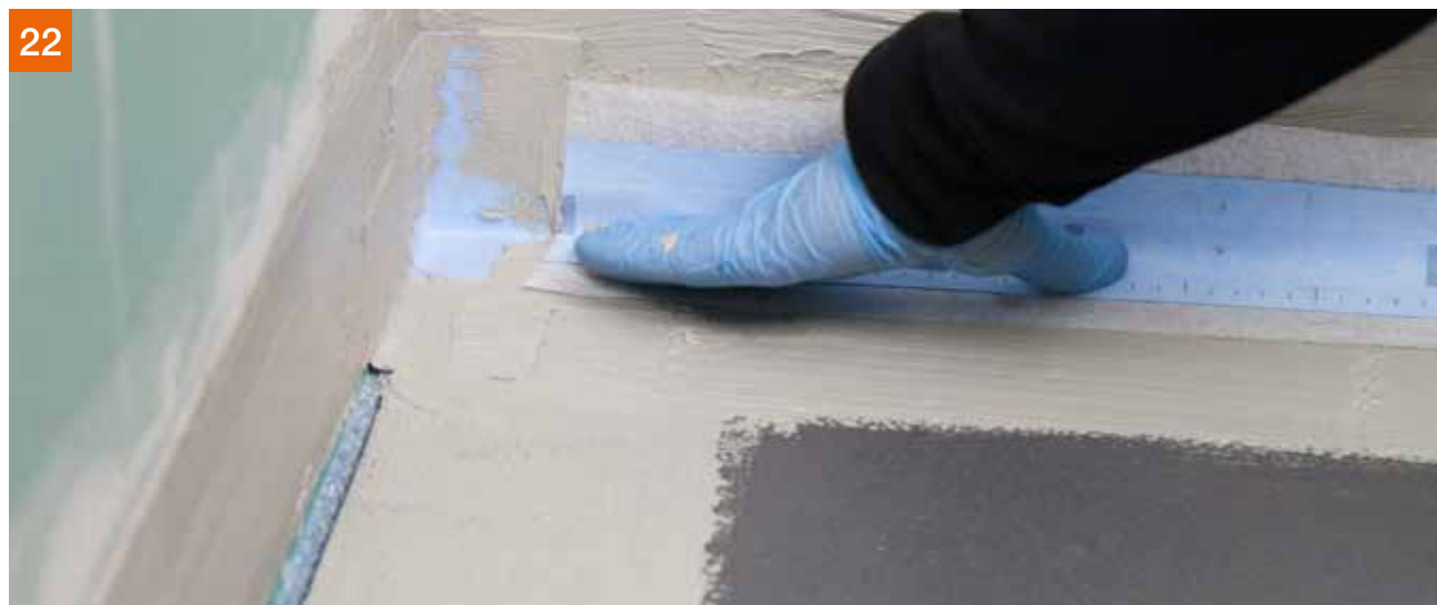
...dann PCI Pectape® 120 einlegen, andrücken ...
