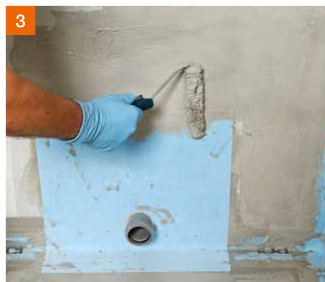
Rohrdurchführungen mit einem Durchmesser > 3/4" werden mit PCI Pecitape® 42,5 x 42,5 abgedichtet. Alternativ Dichtmanschette aus PCI Pecilastic® W erstellen.
