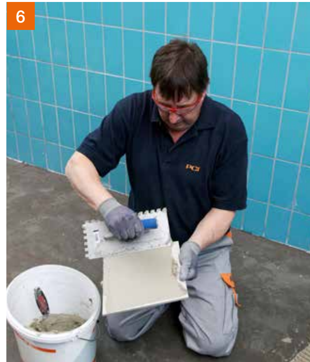
... wird das Buttering-Floating-Verfahren angewendet.
