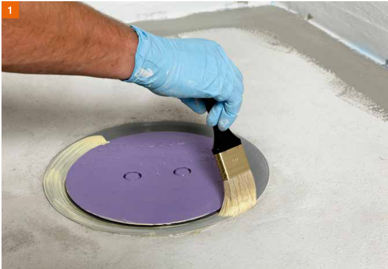
Grundierung des Flansches mit PCI Gisogrund® 303 oder PCI Gisogrund® 404.
