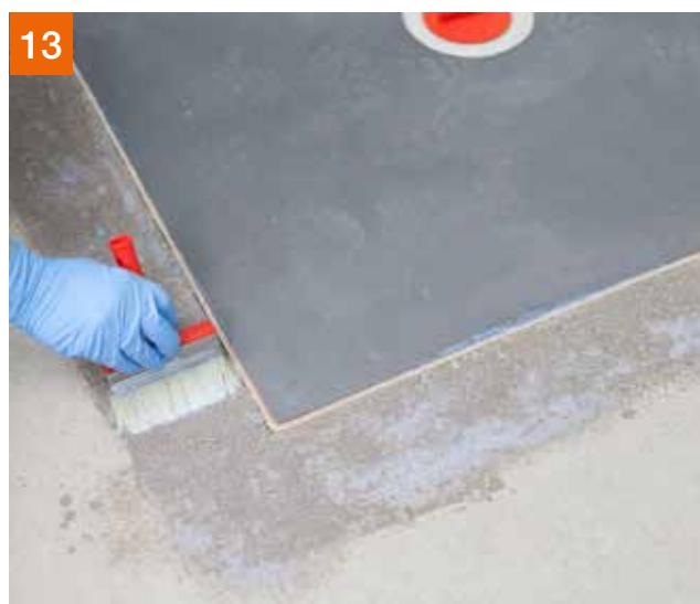
13 Estrich im Übergangsbereich mit PCI Gisogrund® grundieren.
