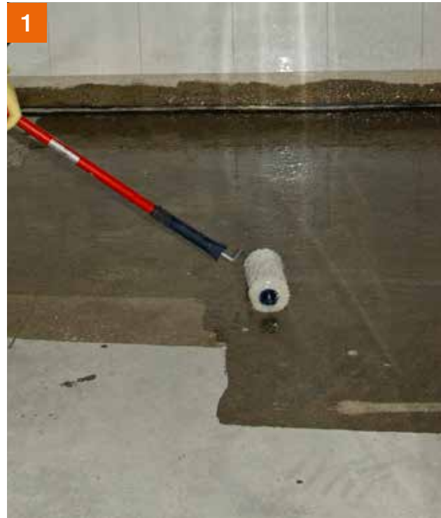
Untergründe vorbereiten, Verunreinigungen und nicht tragfähige Bereiche entfernen und ausgleichen. Mit PCI Epoxigrund 390 grundieren.
