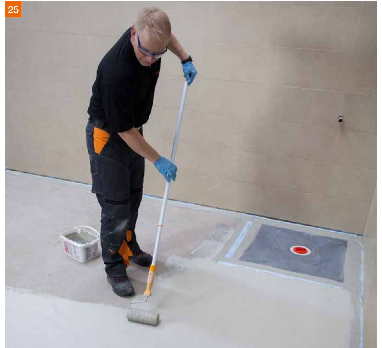
Nach ca. 1 Stunde erfolgt der 2. Auftrag mit PCI Lastogum® im Farbton weiß.
