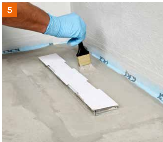
... und mit etwas Abdichtungsmaterial nochmals überstreichen.
