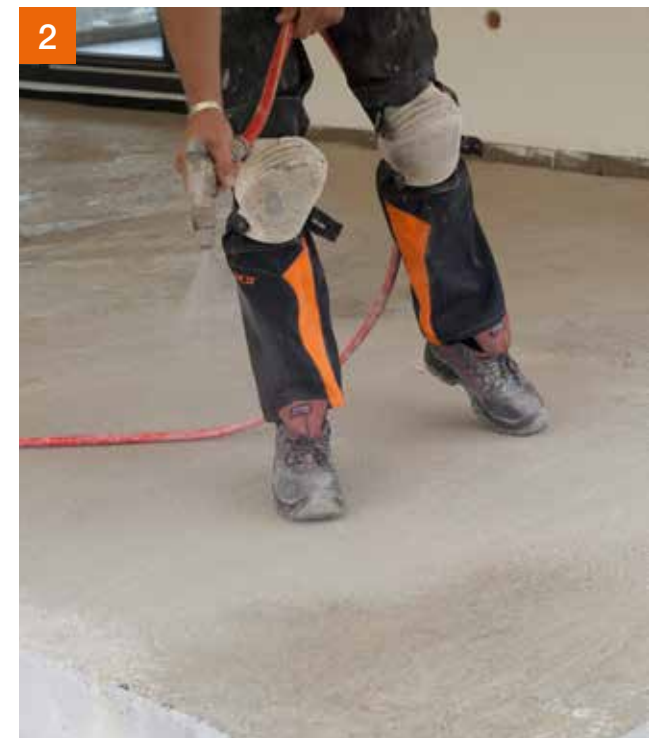
2 Untergrund vornässen für die Aufbringung der Ausgleichspachtelung.
