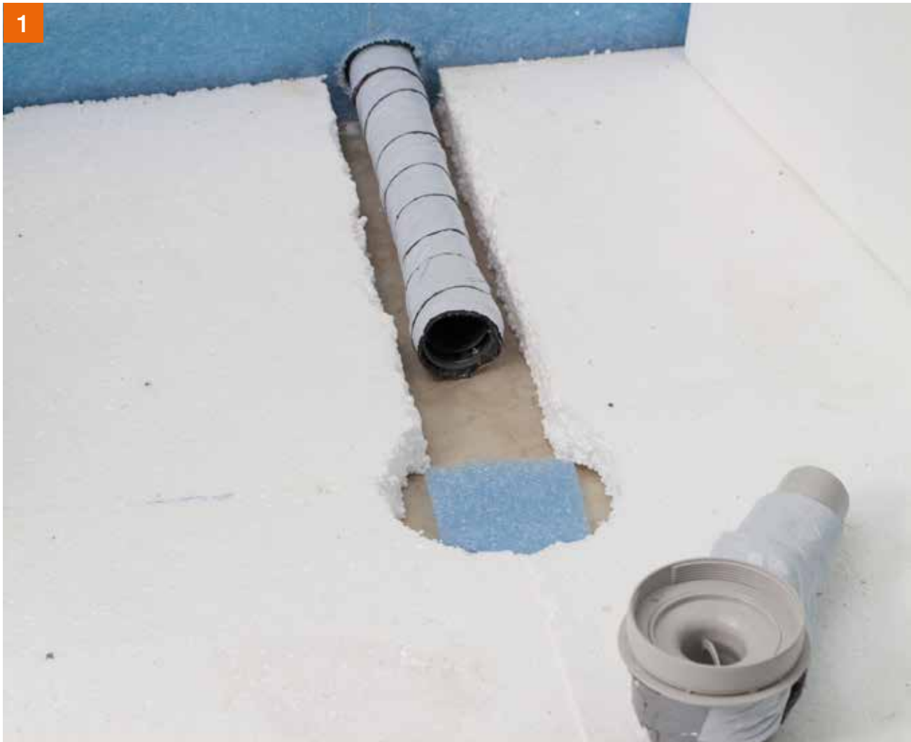
Der Einbau von PCI Pecibord® kann auf einer druckstabilen, vollflächig verklebten Polystyrol-Hartschaumplatte erfolgen.
