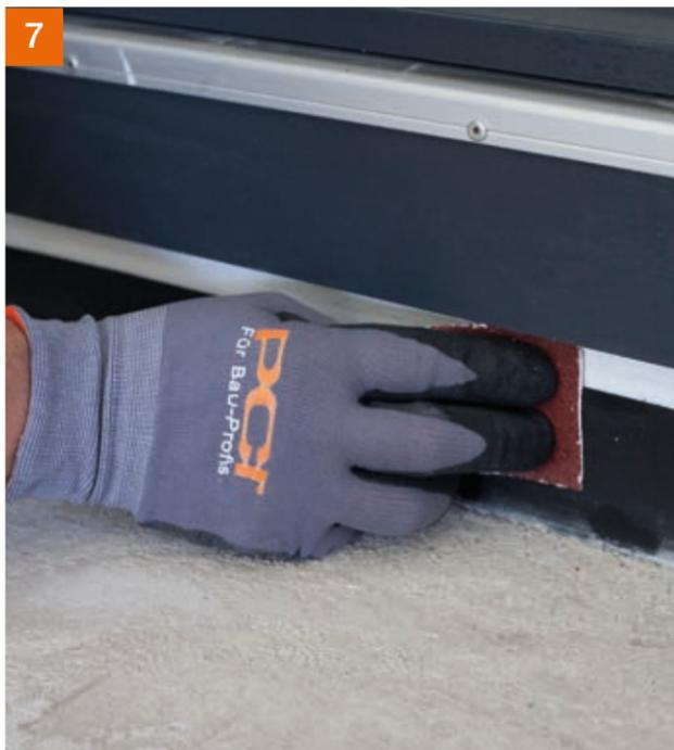
Detail Türabdichtung mit PCI Pectitape® 120: Element anschleifen und anschließend reinigen mit PCI Univerdüner.
