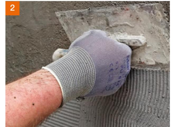
1. Auftrag PCI Seccoral® 1K / 2K Rapid. Ziehen Sie die Abdichtung mit einem Zahnpachtel (6 mm) auf ...
