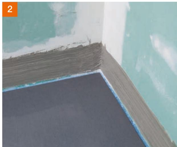
Anschließend wird zum Verkleben des Sicherheits-Dichtbands PCI Pectitape® 120 das Abdichtungsmaterial PCI Seccoral® 1K / 2K Rapid an der Wand vorgelegt.
