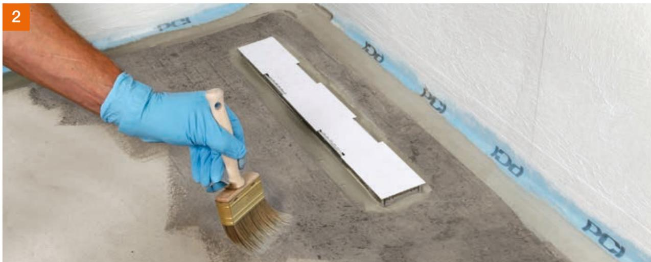
Die übrige Bodenfläche wird vorgehäst und mit verdünntem PCI Seccoral® 1K / 2K Rapid grundiert.
