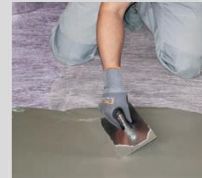
Mit einer Glättkelle verteilen (keine Rakel verwenden!) ...
