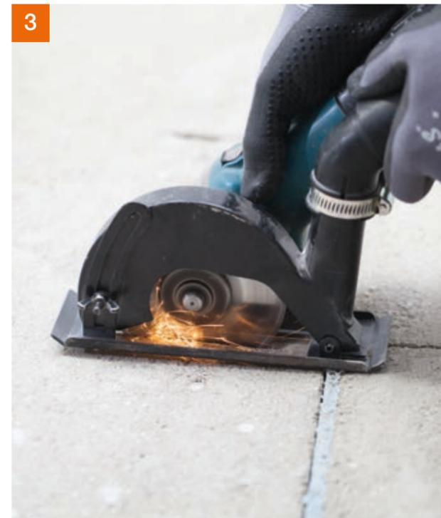
Anschließend werden diese Bereiche mittels Trennschleifer eingeschnitten ...
