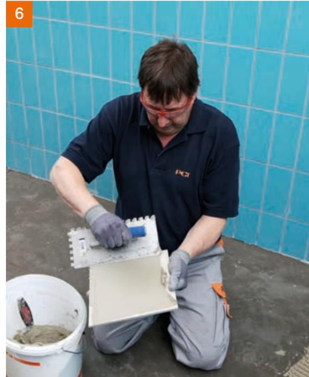
... wird das Buttering-Floating-Verfahren angewendet.
