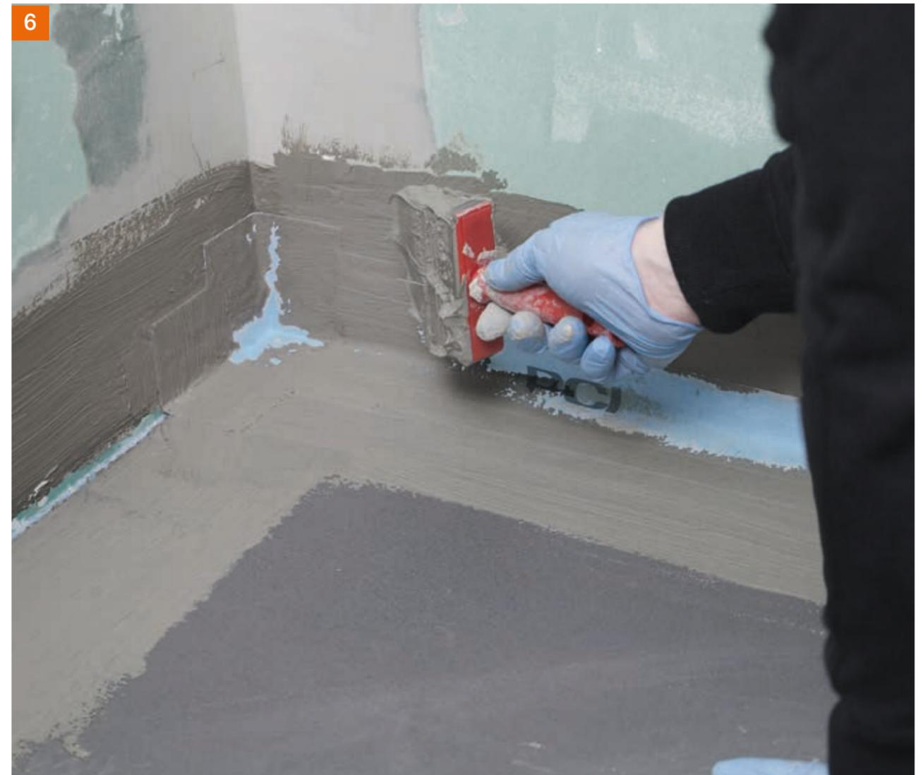
... und die vlieskaschierten Bereiche mit PCI Seccoral® 1K / 2K Rapid überstreichen.
