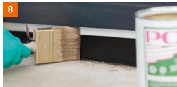
Element grundieren mit PCI Epoxigrund 390 ...
