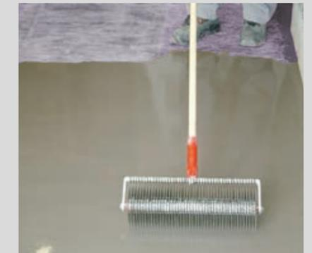
... und mit einer geeigneten Stachelwalze entlüften.
