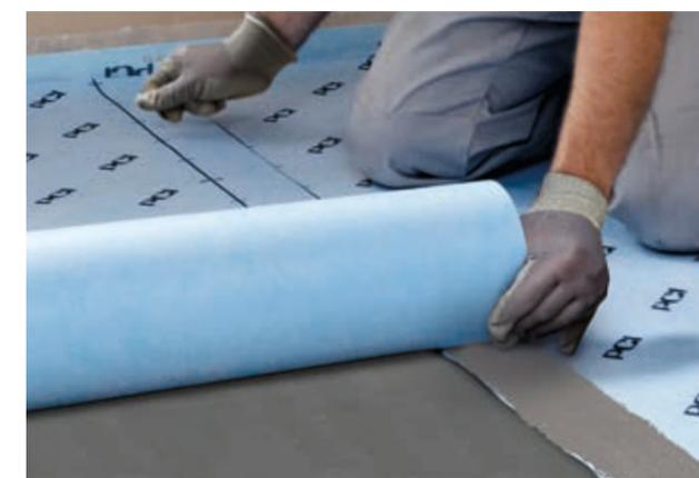
Die Stöße der Bahnen müssen ca. 5 bis 10 cm überlappen. Die Überlappung der Bahnen mit PCI Seccoral® 1K / 2K Rapid einstreichen und innerhalb der klebeffenen Zeit die folgende Bahn eingelegt und sorgfältig angedrückt.
