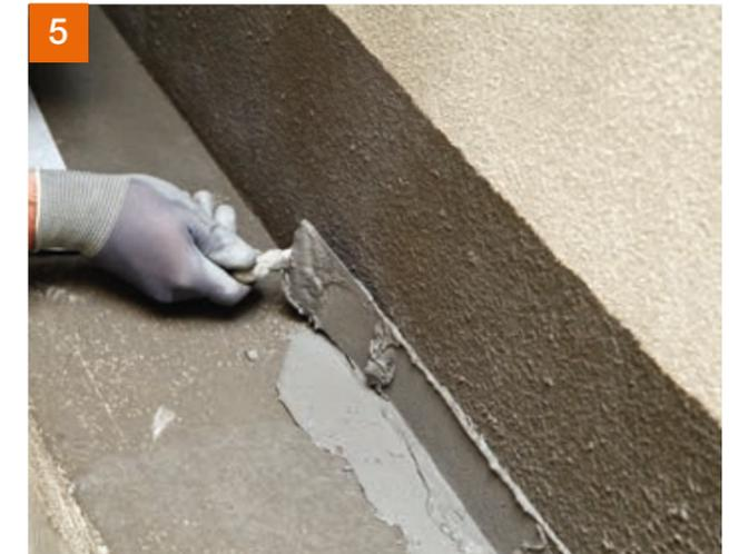
Zur Abdichtung von Kanten (zum Beispiel Wand-/Bodenanschlüssen) wird PCI Seccoral® 1K / 2K Rapid vorgelegt ...
