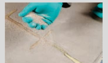
Angemischtes Gießharz in die Risse/ Fugen oberflächenbündig eingießen, glatt abziehen und mit trockenem Quarzsand abstreuen.
