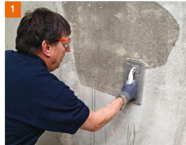
Das gründliche Vornässen reduziert die Saugfähigkeit des Betons und verhindert, dass der nachfolgenden Abdichtung zu schnell das Wasser entzogen wird.
