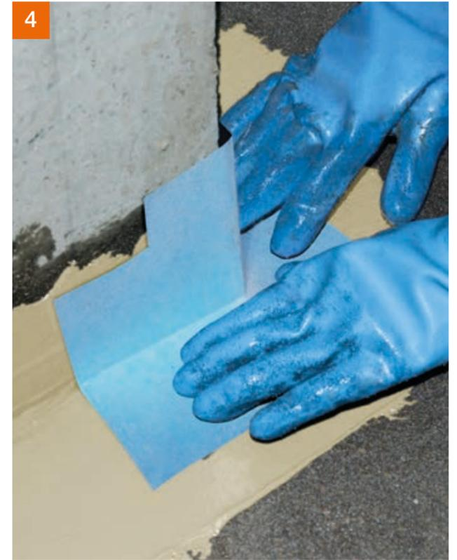
Formteil PCI Pectatpe® 90° in die Abdichtungsschicht einlegen ...
