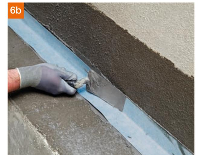
... dann das Abdichtband PCI Pecitape® Objekt in die frische Dichtschlämme eingelegt und behutsam angedrückt. Die Ränder des Dichtbandes werden anschließend mit PCI Seccoral® 1K / 2K Rapid überarbeitet.
