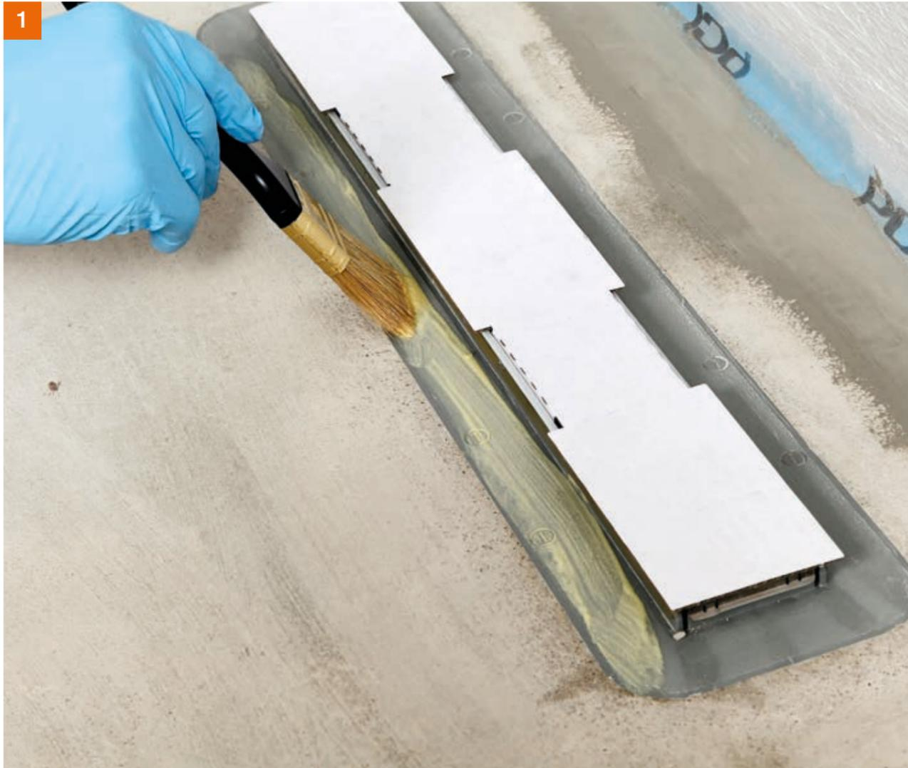
Grundierung des Anschlussflansches mit PCI Epoxigrund.
