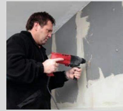
Nach Erhärtung des Klebemörtels werden die Bohrungen für die Dübel (ca. 5 Stck./m<sup>2</sup>) gesetzt.
