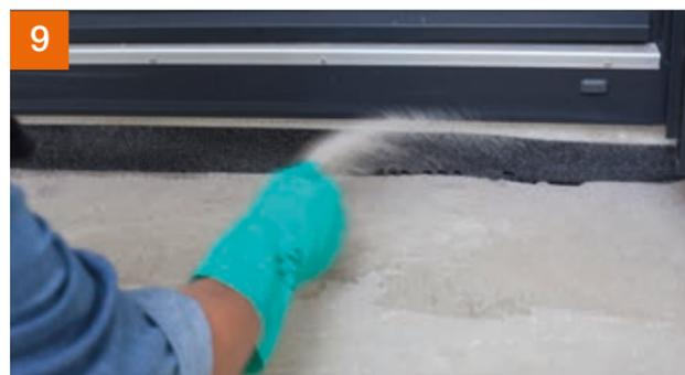
... anschließend die Grundierung absanden.
