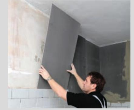
PCI PowerBoard-Element ansetzen und anschließend anklopfen.
