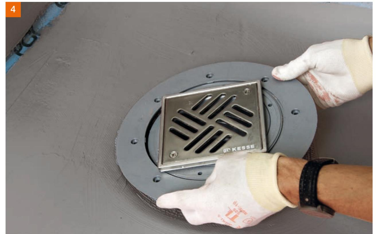
Klemmflansch aufsetzen und festschrauben.
