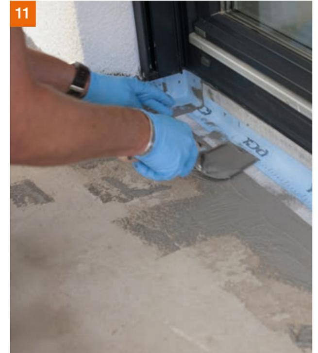
PCI Pectitape® 120 in PCI Seccoral® 2K Rapid einlegen.
