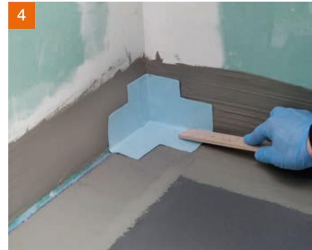
Einlegen der vorgefertigten Spezial-Innenecke PCI Pectitape® 90° L in PCI Seccoral® 1K / 2K Rapid.
