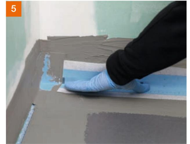
PCI Pectitape® 120 die Dichtcke überlappend einlegen...
