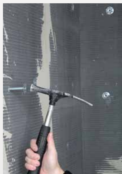
Zu guter Letzt die Schlagdübel einschlagen.
