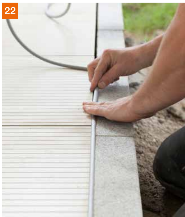
22 Danach die Rundschnüre einbauen für das nachfolgende Silikonieren.
