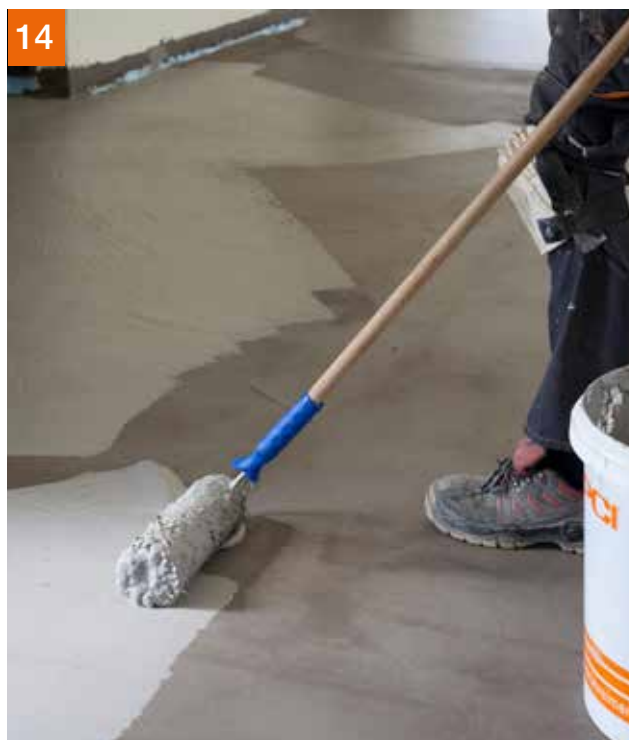
14 PCI Seccoral® 2K Rapid im 2. Auftrag mittels Lammfellrolle auftragen.
