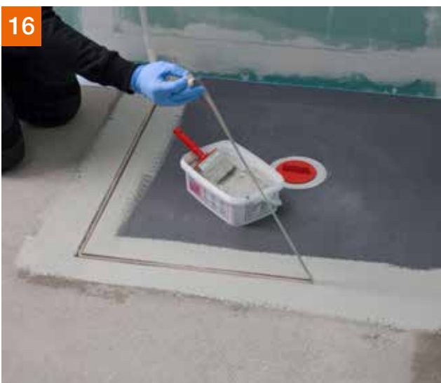
...Klebestreifen abziehen...
