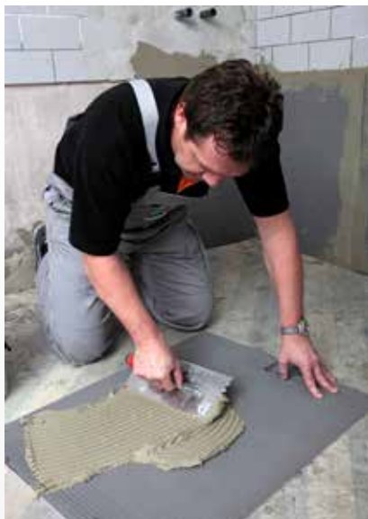
Den Klebemörtel mittels Zahntraufel auf der Plattenrückseite aufziehen. Bei größeren Unebenheiten kann in der „Batzenmethode“ gearbeitet werden.
