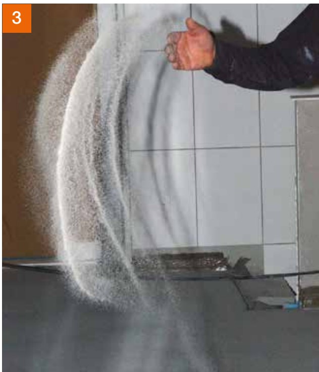
3 Zur besseren mechanischen Verkrallung mit dem Fliesenkleber PCI Apoflex® vollsatt mit Quarzsand abstreuen.
