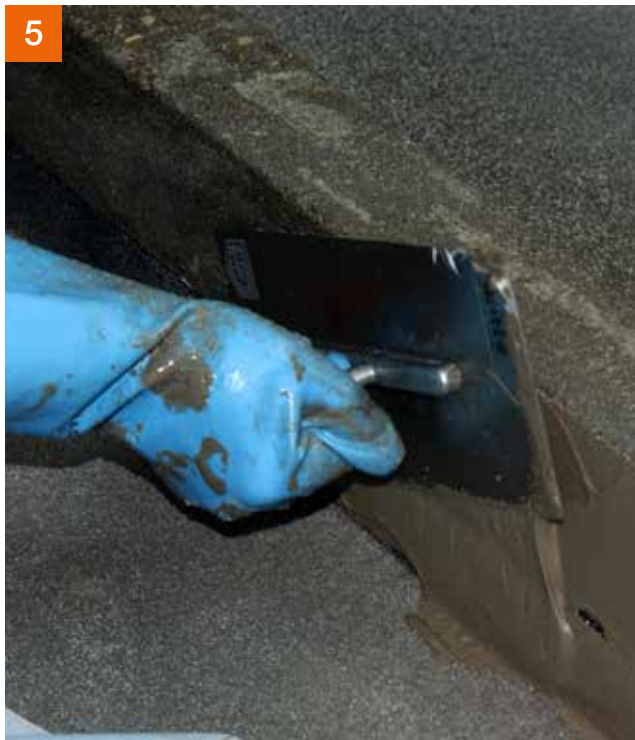
5 Vor dem Verkleben der Abdichtbänder wird PCI Apoflex® vorgelegt ...
