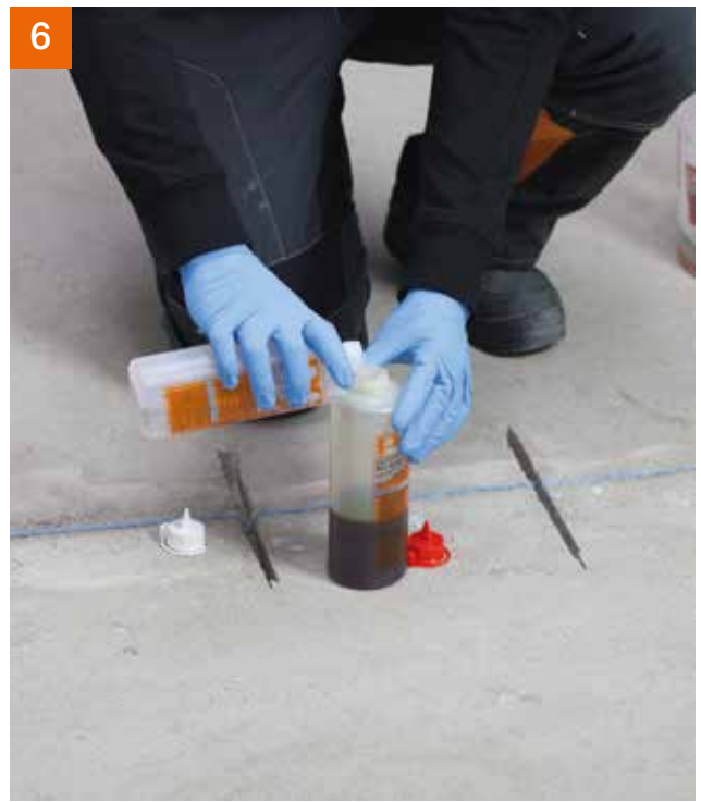
6 Sind die Nuten so weit vorbereitet, werden die beiden Komponenten von PCI Apogel® SH zusammenschüttet ...
