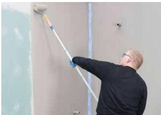
Flüssigabdichtungen sind immer mindestens 2-lagig auszuführen.
