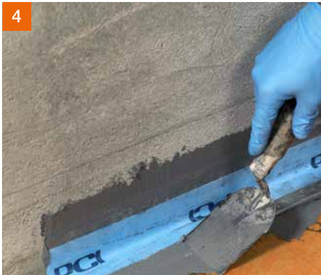
4 Anschlüsse mit PCI Seccoral® 2K Rapid ...
