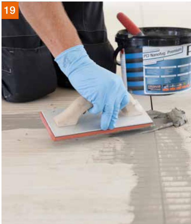
19 Fliesenbelag mit PCI Nanofug® Premium einfügen ...
