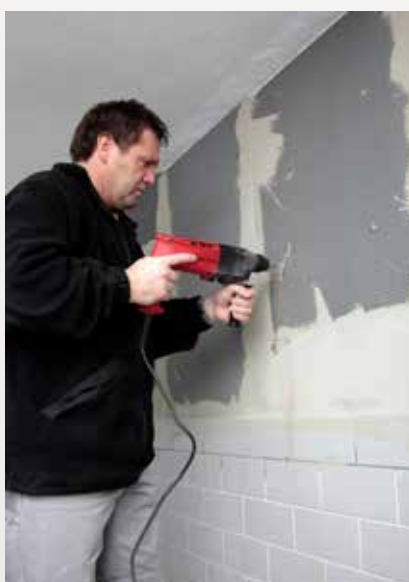
Nach Erhärtung des Klebemörtels werden die Bohrungen für die Dübel (ca. 5 Stck./m 2 ) gesetzt.
