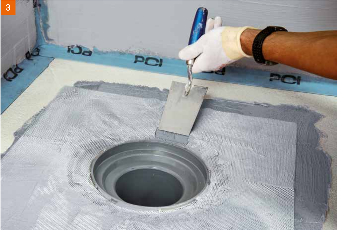
...anschließend das Gewebe entsprechend dem Gefälleverlauf andrücken und mit PCI Seccoral® überarbeiten. Nach Durchtrocknung (ca. 1 Std.) erfolgt der 2. Arbeitsgang mit PCI Seccoral®.
