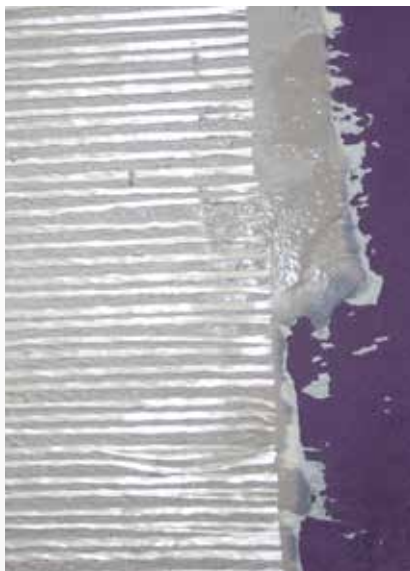
Eingelegte PCI Armiermatte GFS nach dem Abziehen der Trägerfolie.
