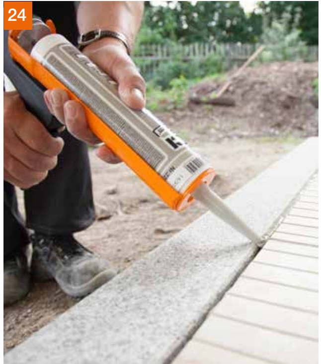
Silikonieren mit PCI Carraferm® im Übergang zum Naturwerkstein.
