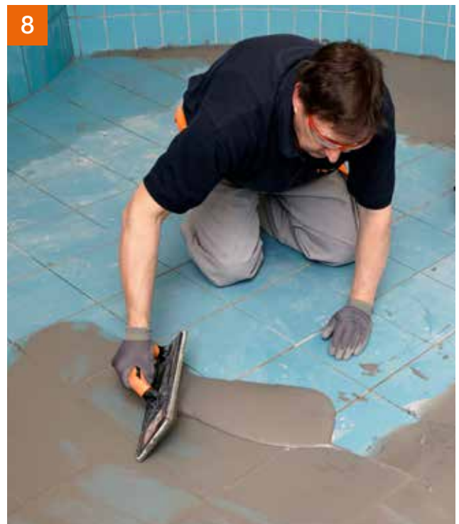
8 Am nächsten Tag erfolgt die Verfugung, zum Beispiel mit PCI Durafug® NT. Die Fläche einschlämmen ...
