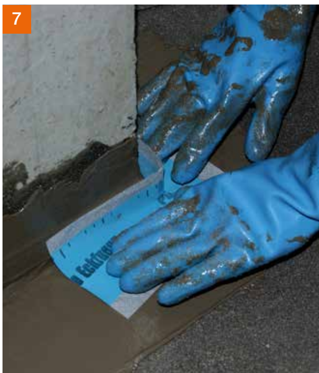
7 Formteil PCI Pecitape® 90° in die Abdichtungsschicht einlegen ...
