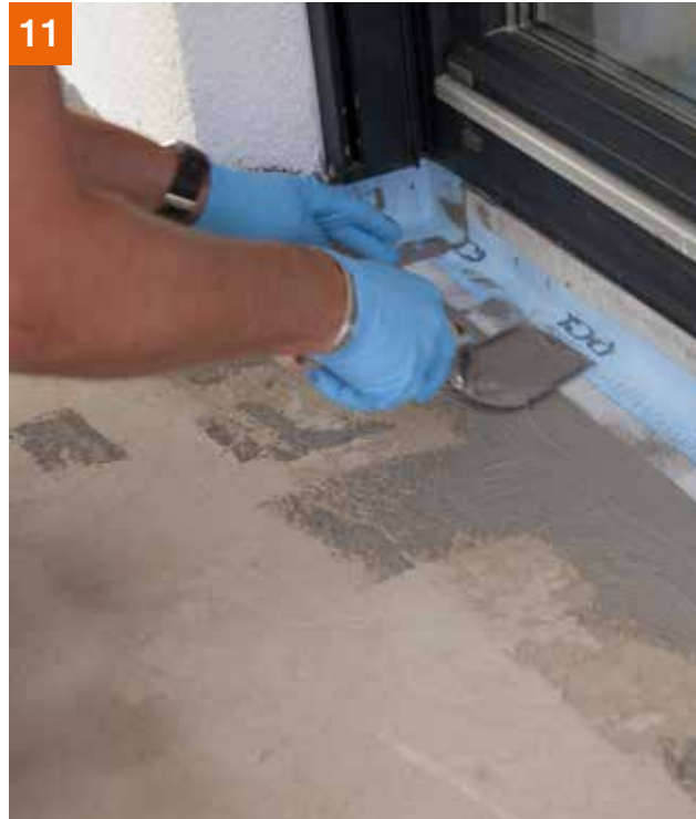
11 PCI Pectape® 120 in PCI Seccoral® 2K Rapid einlegen.
