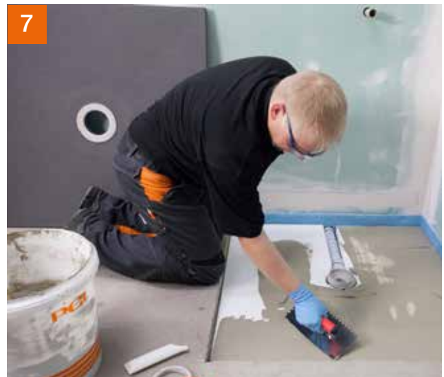
7 Fliesenkleber aufziehen, um das PCI Pecibord® mit dem Unterbauelement zu verkleben.
