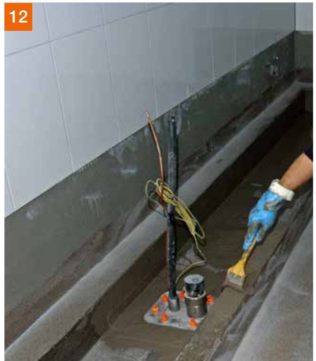
12 ... sowie Durchdringungen mit PCI Epoxigrund 390 grundieren.
