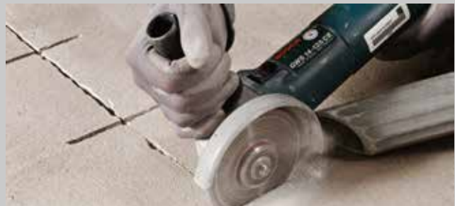
Zur Vorbereitung für eine Vernadelung rechtwinklig zum Rissverlauf Nuten einschneiden.
