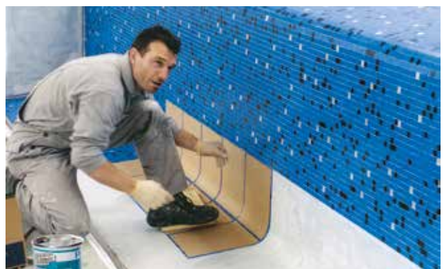
... werden keramische Beläge sicher auf Stahlkonstruktionen verlegt.
