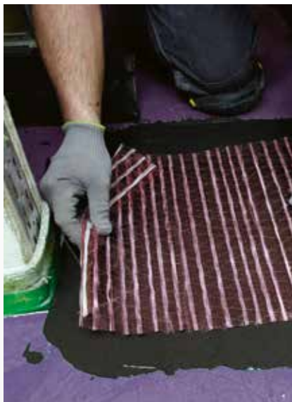
Die Glasfaserstränge der PCI Armiermatte GFS in die frische Vorspachtelung einlegen.
