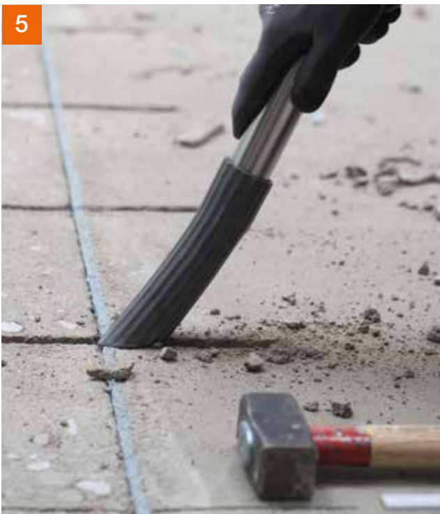
5 ... und lose Estrichreste mittels Industriestaubsauger abgesaugt.
