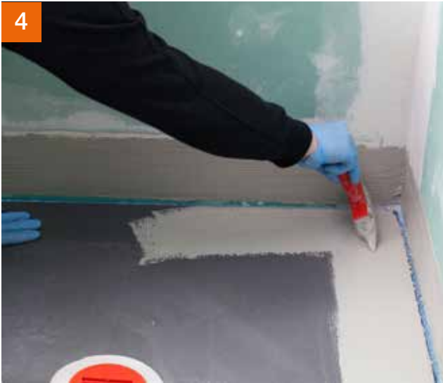
Danach wird PCI Lastogum® auch im Bodenbereich vorgelegt.
