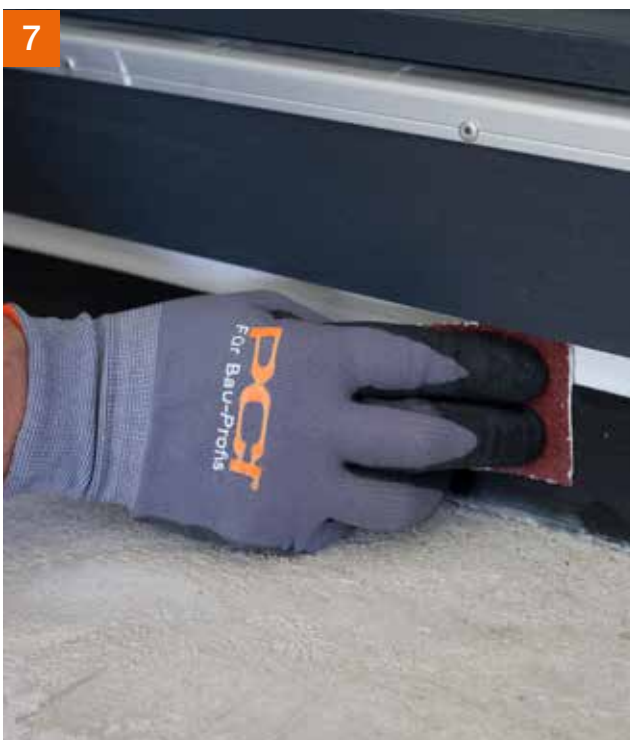
7 Detail Türabdichtung mit PCI Pecitape® 120: Element anschleifen und anschließend reinigen mit PCI Univerdünnern.
