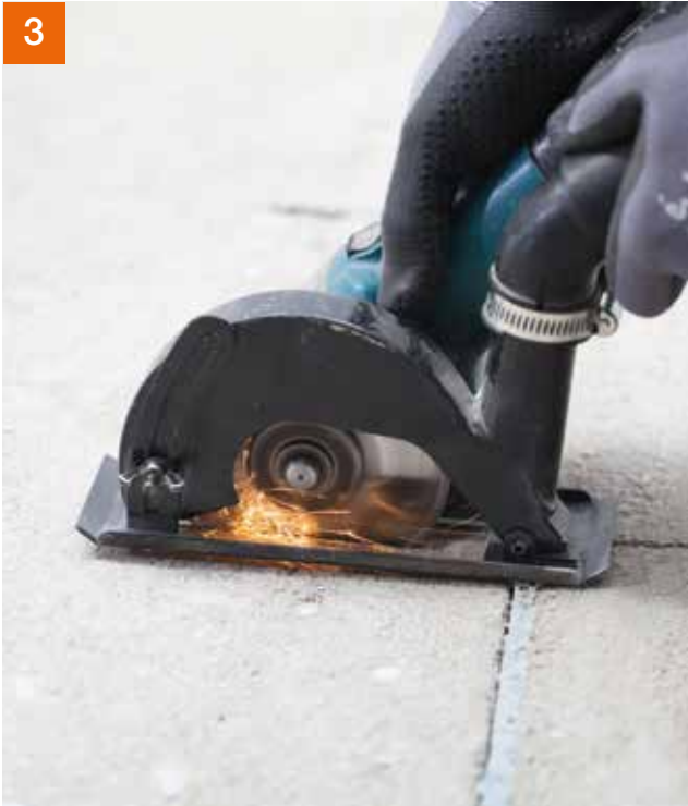
3 Anschließend werden diese Bereiche mittels Trennschleifer eingeschnitten ...
