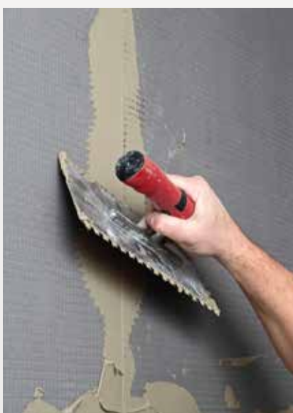
Die Plattenstöße und Anschlüsse werden mittels Klebemörtel beigespachtelt. Bei Bedarf kann auch zusätzlich ein Glasseidengewebe, zum Beispiel PCI Gewebbahn, eingespachtelt werden.
