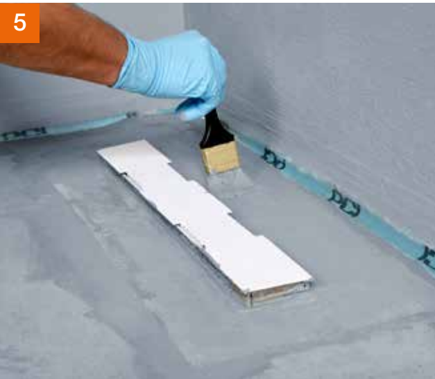
5 ... und mit etwas Abdichtungsmaterial nochmals überstreichen.
