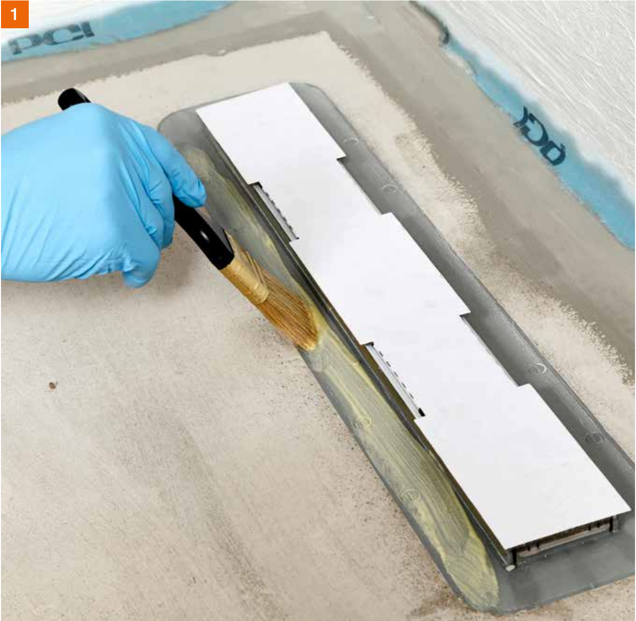
Grundierung des Anschlußflansches mit PCI Gisogrund® 303 oder PCI Gisogrund® 404 im mäßig belasteten Bereich, bei hoher Beanspruchung mit PCI Epoxigrund.
