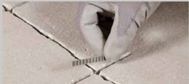
Estrichklammern in die quer zum Rissverlauf angelegten und ausgesaugten Nuten einlegen.
