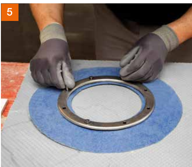
5 Anschließend werden die Schrauben eingesetzt. Nun kann das Set auf einem stabilen Karton umgedreht werden.
