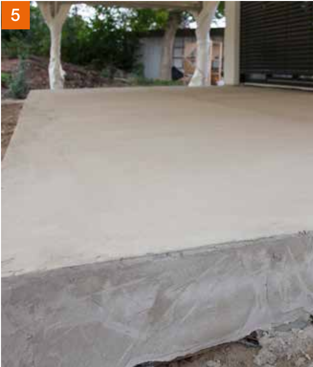
5 Terrassenplatte mit PCI Pericret® im Gefälle gespachtelt.
