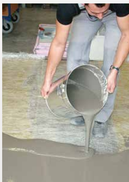
Die Bodenausgleichsmasse PCI Periplan® Extra in einer Mindestschichtdicke von 10 mm ausgießen.
