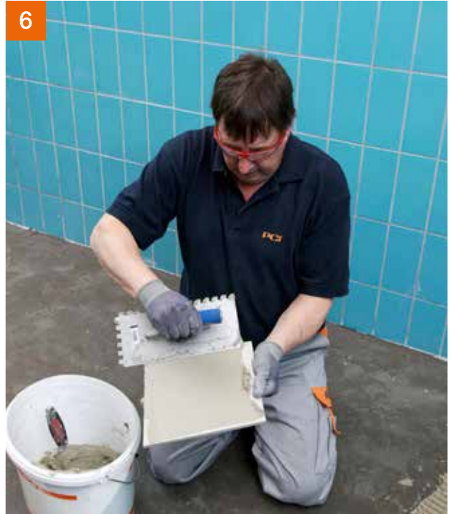
6 ... wird das Buttering-Floating-Verfahren angewendet.
