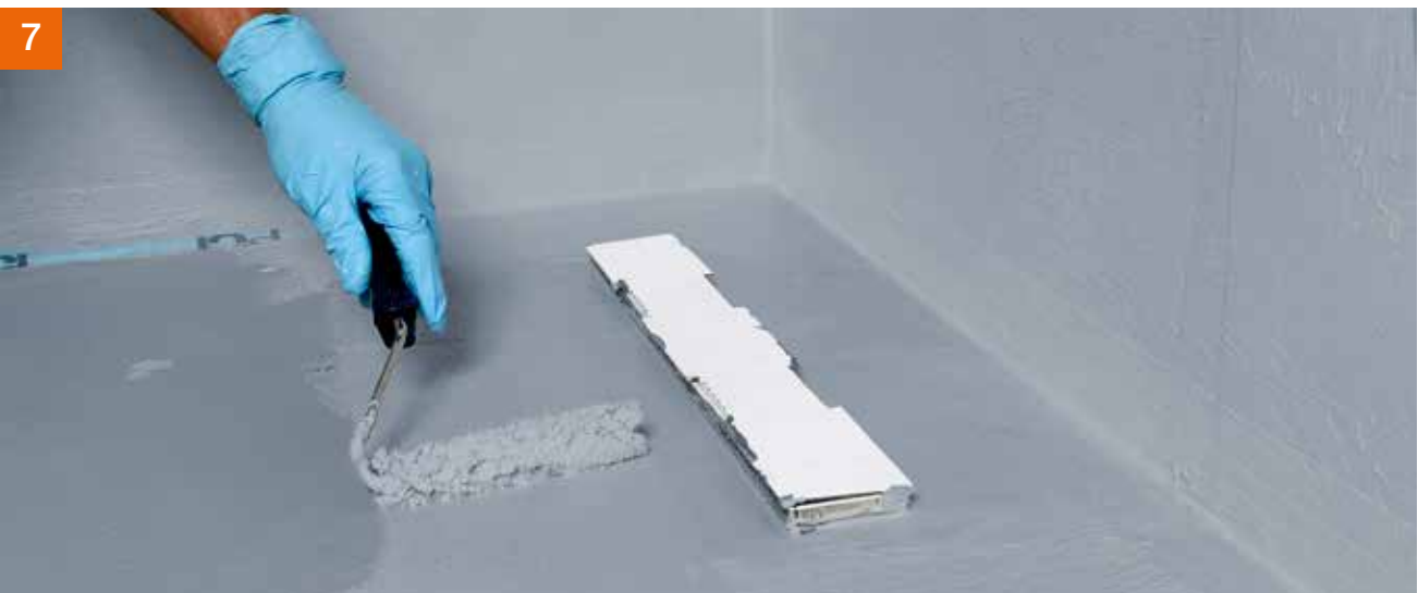
7 Nach einer Wartezeit von ca. 1 Stunde erfolgt der 2. Auftrag.
