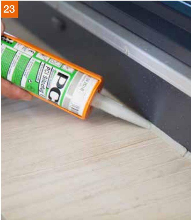
Silikonieren mit PCI Silcofug® E oder PCI Silcoferm® S im Anschlussbereich zum Kunststofffenster.
