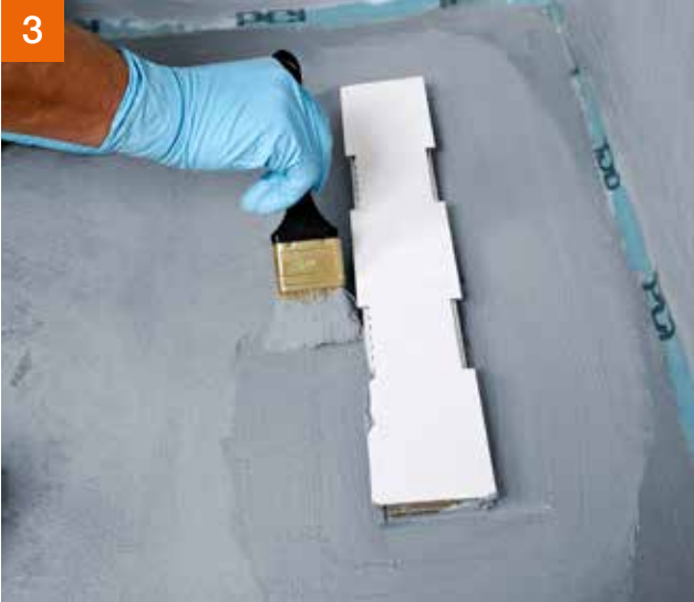
3 PCI Seccora® 2K Rapid als Kleber für das werksseitig mitgelieferte Gewebe vorlegen ...
