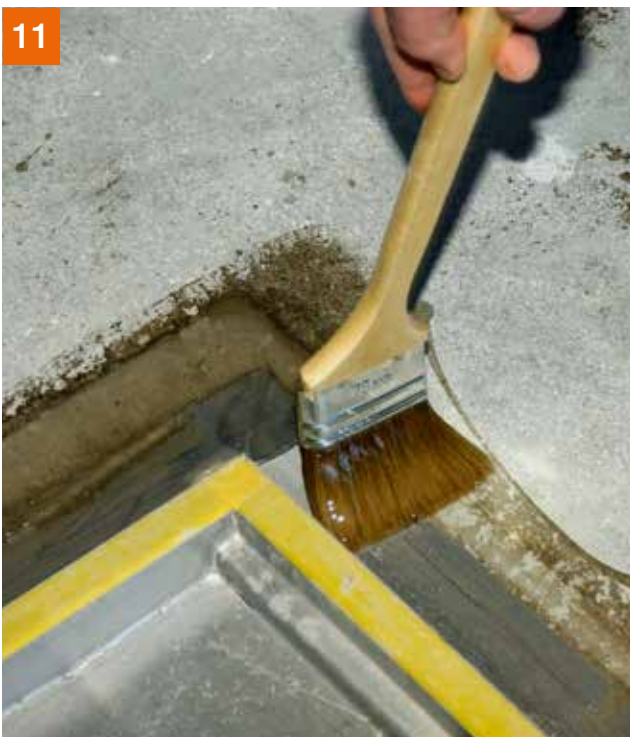
11 Details und Übergänge an Einbauteilen ...
