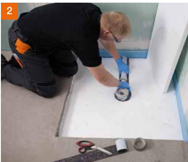
Der Ablauftopf wird an das vorhandene Ablaufrohr angeschlossen ...
