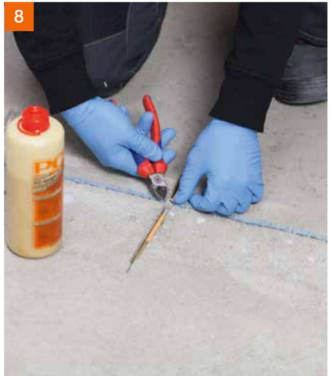
8 PCI Apogel® Dübel in die Nut einlegen und den Spannring entfernen.
