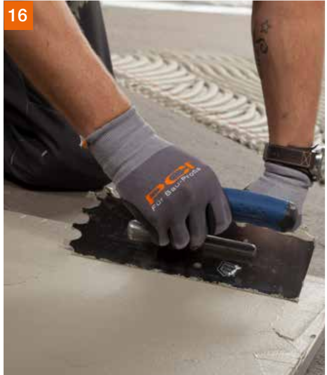
Kratzspachtelung mit PCI Flexmörtel® Premium auf der Fliesenrückseite aufziehen ...
