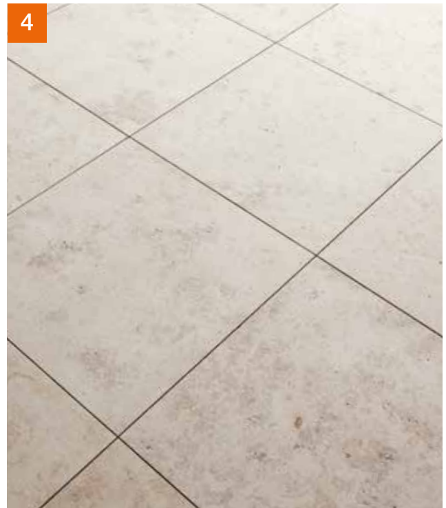
4 Sicher verlegt mit dem System Naturwerkstein Universal.
