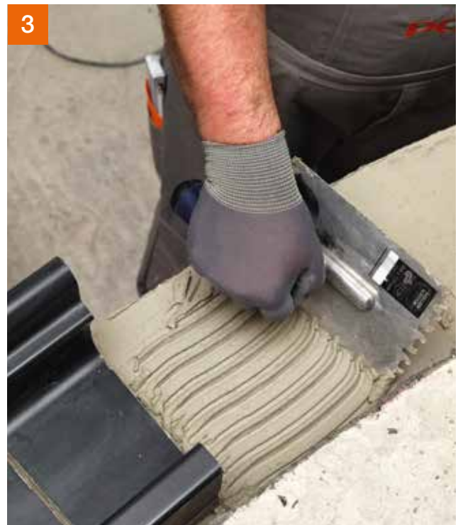
... und dann das Kleberbett aufkämmen.
