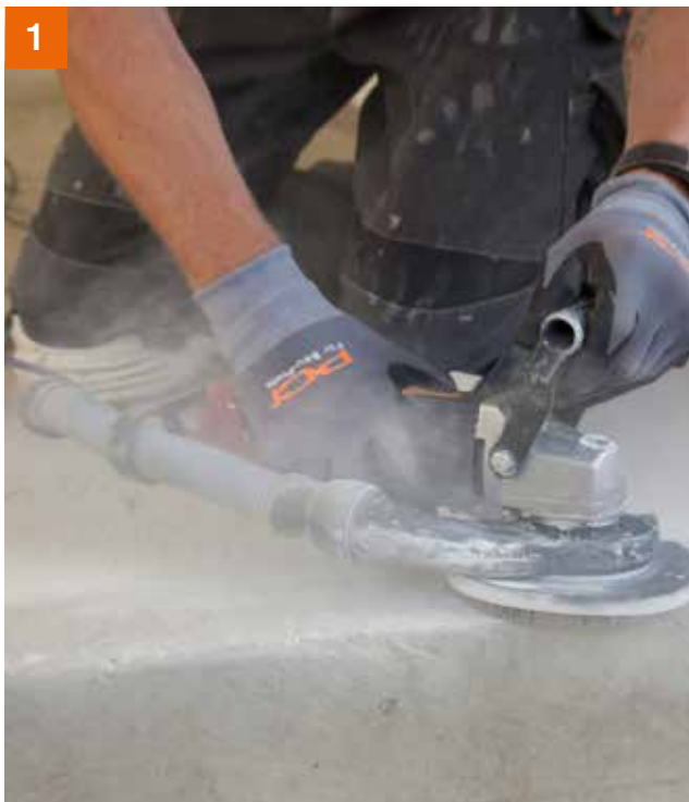
1 Untergrundvorbereitung: Grate entfernen.
