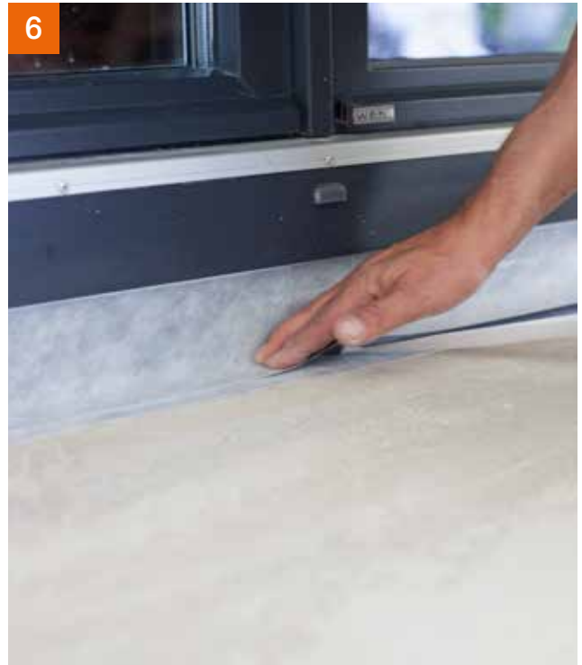
6 Detail Türabdichtung mit PCI Pecitape® WS: vorher gründlich reinigen.
