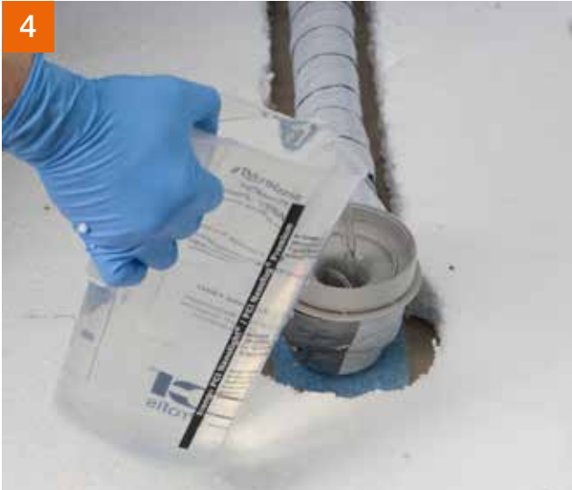
4 Vor Beginn der weiteren Arbeiten wird eine Dichtigkeitsprüfung durchgeführt.
