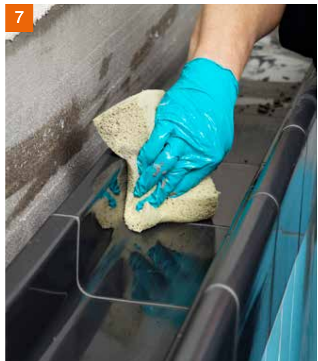
7 Sind die Rinnensteine gesetzt, kann nachfolgend zum Beispiel mit PCI Durafug® NT oder PCI Durapox® NT Plus verfugt werden.
