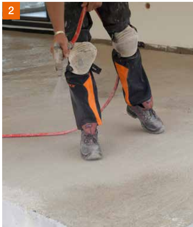
2 Untergrund vornässen für die Aufbringung der Ausgleichspachtelung.
