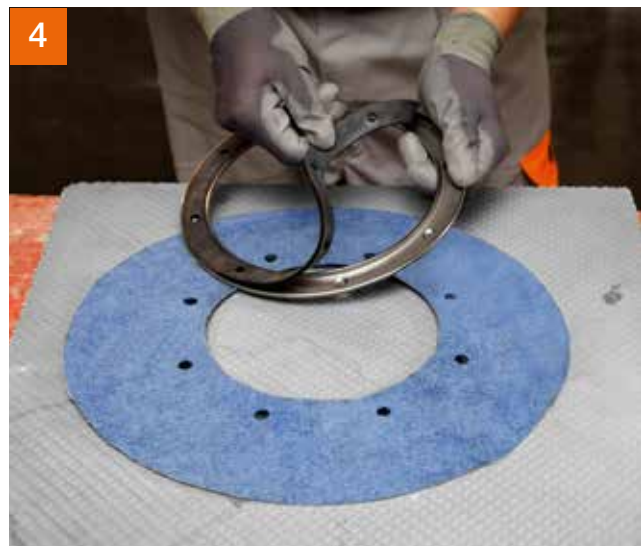
4 ... dann folgen die dafür vorbereitete Dichtmanschette, zweite Gummidichtung und Klemmflansch.
