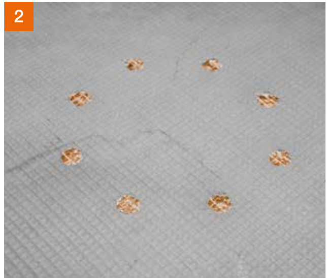
2 Know-how: Um die Kombination aus Dichtring-Manschette/Dichtring-Flansch-Schrauben einfach und schnell zusammensetzen zu können, wird entsprechend den Bohrungen im Klemmflansch eine Schablone vorbereitet.
