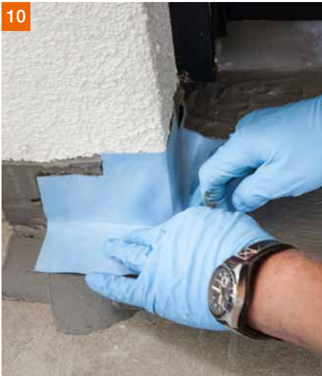
10 Detail Wandanschluss: PCI Seccoral® 2K Rapid vorlegen und Außenecke einlegen.
