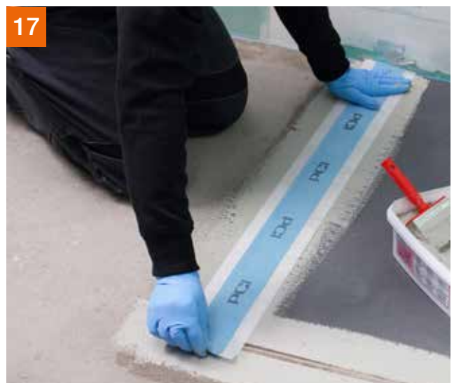
...PCI Pectape® 120 einlegen, andrücken...
