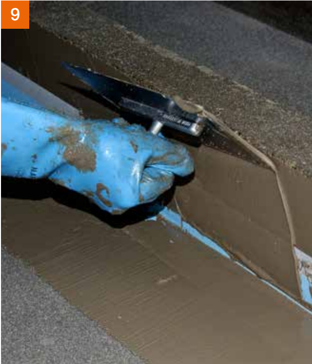
9 Anschließend noch einmal mit PCI Apoflex® überarbeiten.
