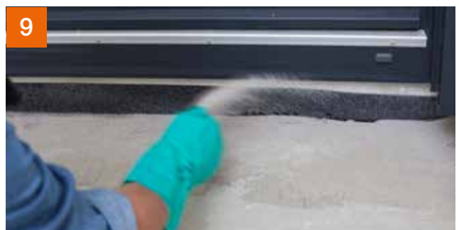
9 ... anschließend die Grundierung absanden.
