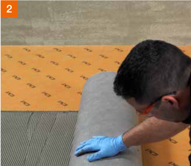
2 PCI Pecilastic® U in das frische Kleberbett einlegen ...
