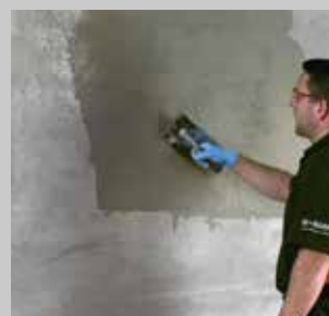
Untergrundvorbereitung für die Verlegung großformatiger Fliesen und Platten auf dem Boden und an der Wand.
