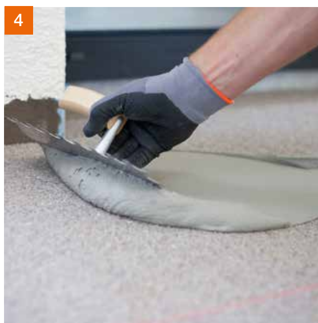
4 PCI Flexmörtel® Premium vorlegen und als Kratzspachtelung ausführen.
