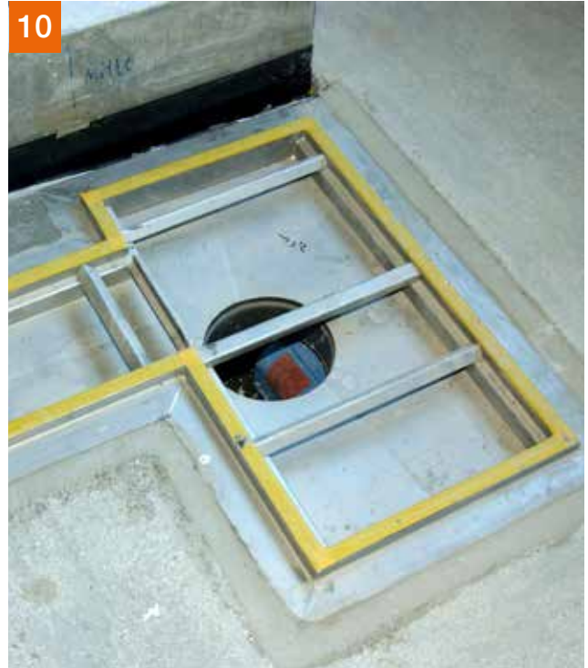
10 Einbauteile, Abläufe, Durchdringungen, Rinnen und Schwallmulden werden in die Flächenabdichtung eingebunden.
