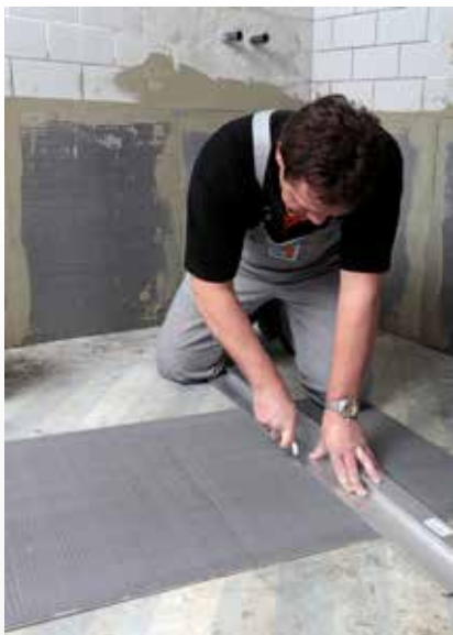
PCI Pecidur®-Elemente mit einem Cuttermesser auf Maß schneiden.
