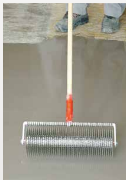
... und mit einer geeigneten Stachelwalze entlüften.
