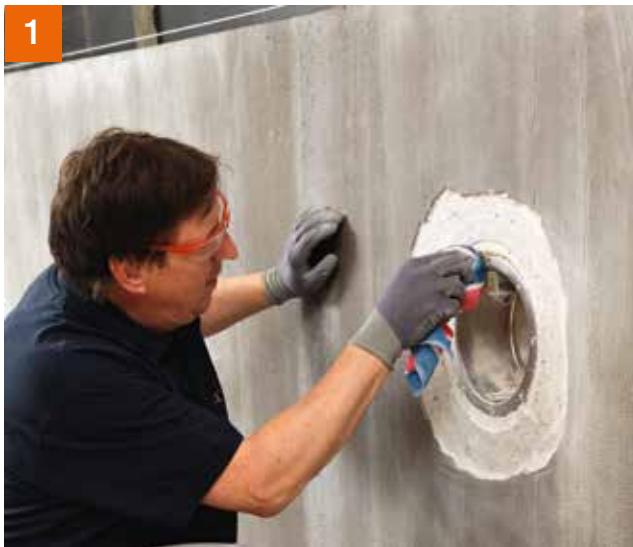
1 Professionelle Alternativlösung: Klemmflansch mit Dichtmanschette.
