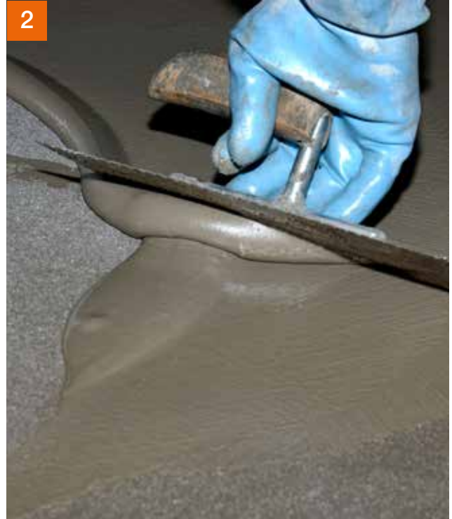
2 PCI Apoflex® in der Wand- oder Bodenvariante als Verbundabdichtung in zwei Arbeitsgängen auftragen.
