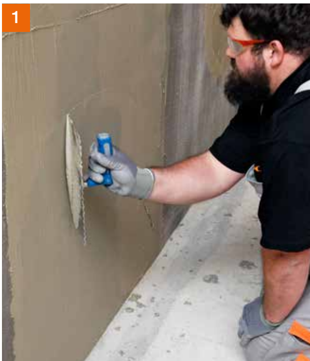
1 Kratzspachtelung mit PCI FT® Klebemörtel vergütet mit PCI Lastoflex® ausführen.
