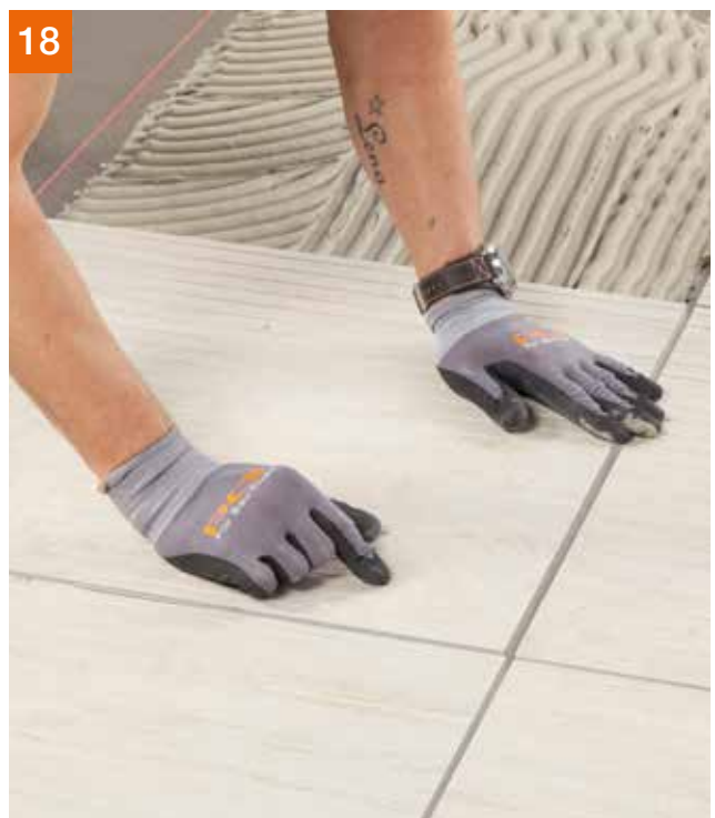
... einschieben und ggf. mittels Gummihammer einklopfen. Danach ausrichten.
