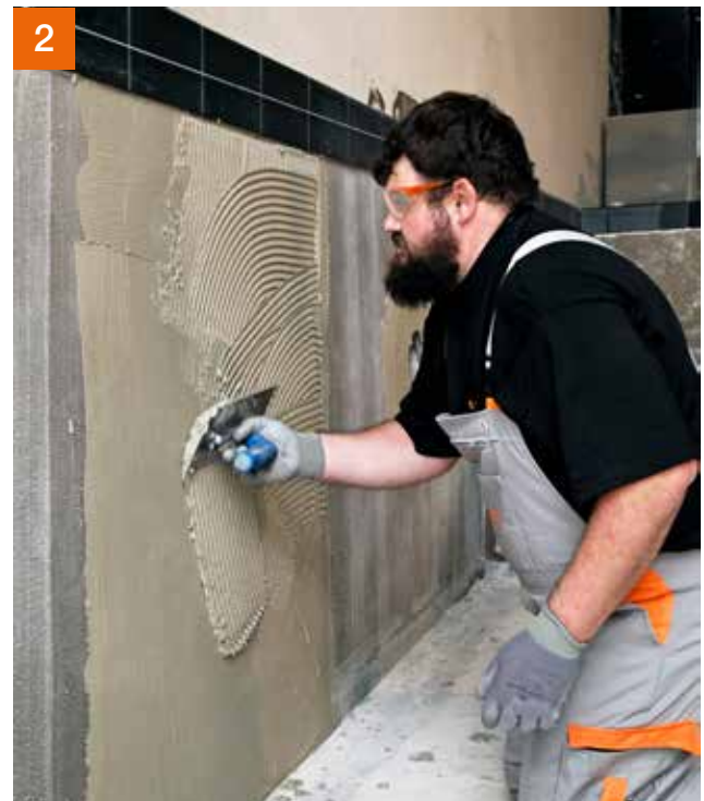
2 Anschließend den Kleber aufkämmen ...
