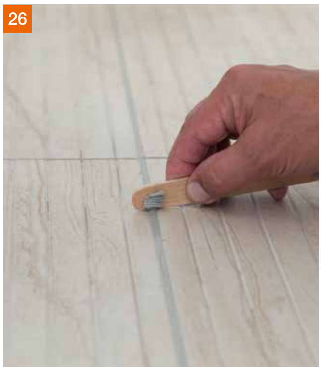
... und dann einfach die Fugen sauber abziehen.
