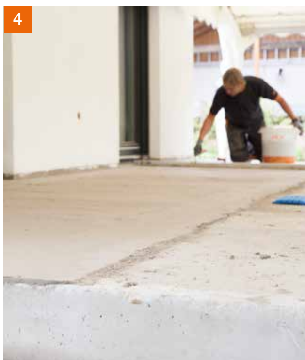
4 Fertiggestellte Teilfläche mit PCI Pericret®.
