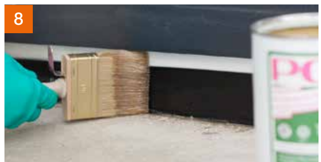
8 Element grundieren mit PCI Epoxigrund 390 ...
