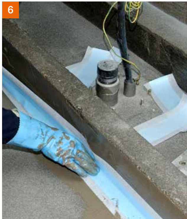
6 ... und anschließend, zum Beispiel PCI Pecitape® 120 oder PCI Pecitape® Objekt eingelegt und übergearbeitet.
