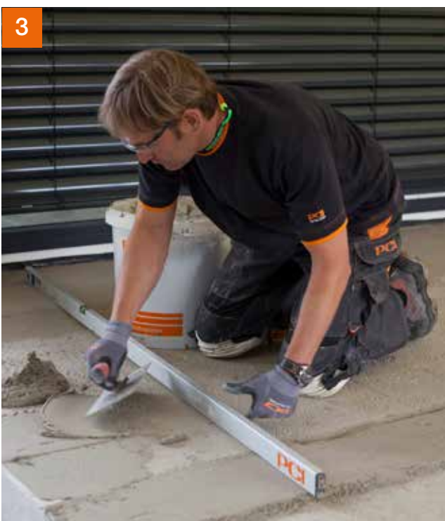
3 Lehren aufziehen und Flächenspachtelung mit PCI Pericret® ausführen.
