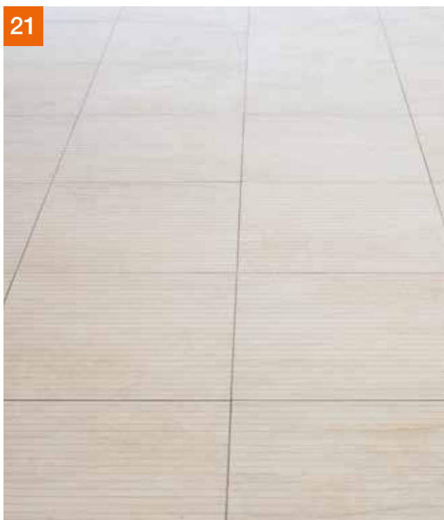
21 Der fertiggestellte und verfugte Fliesenbelag.
