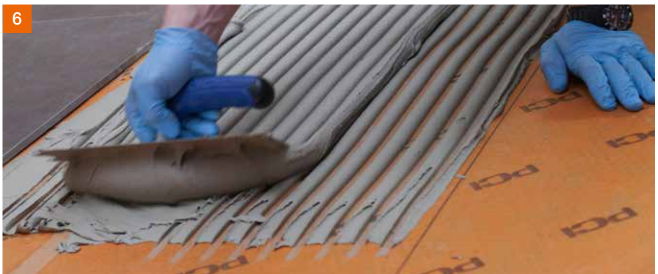
6 Verlegen der Fliesen mit PCI Flexmörtel® Premium.
