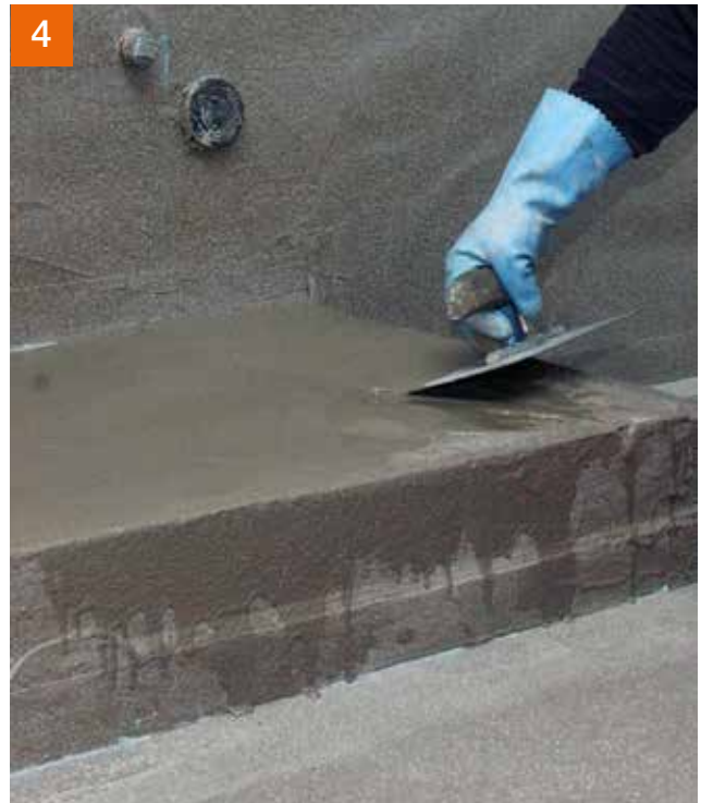
4 1. Arbeitsgang PCI Apoflex® F.
