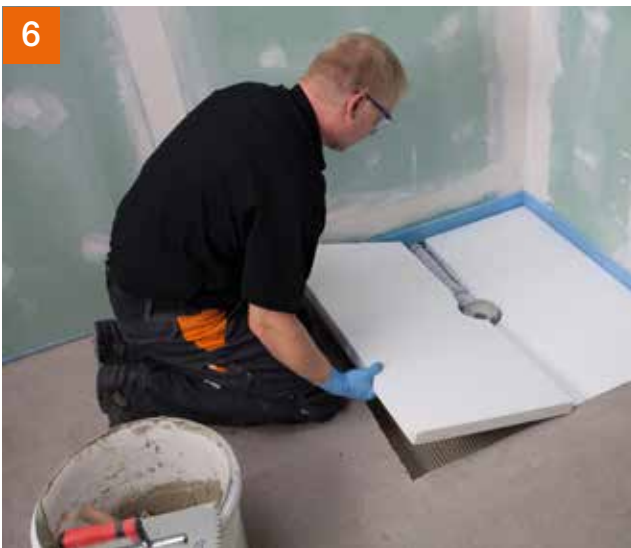
6 Die Platten werden untereinander mit einem Klebemörtel, zum Beispiel PCI Flexmörtel® S1, verklebt.
