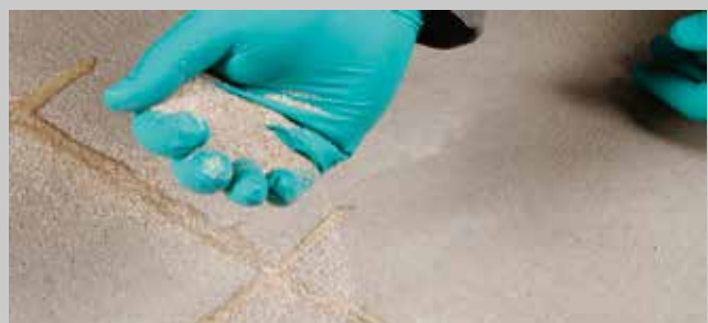
Angemischtes Gießharz in die Risse/Fugen oberflächenbündig eingießen, glatt abziehen und mit trockenem Quarzsand abstreuen.
