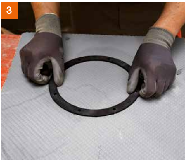
3 Das erste Dichtgummi wird passgenau aufgelegt ...
