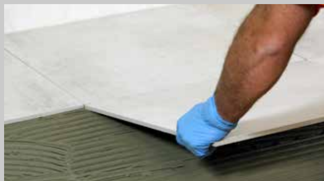
Untergrundvorbereitung für die Verlegung großformatiger Fliesen und Platten auf dem Boden und an der Wand.
