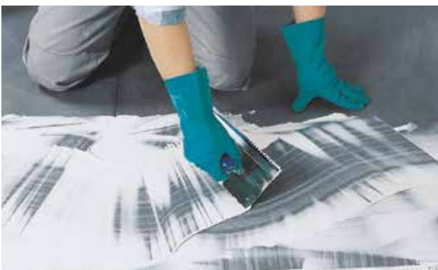
Mit dem verformungsfähigen Reaktionsharz-Fliesenkleber PCI Collastic® ...
