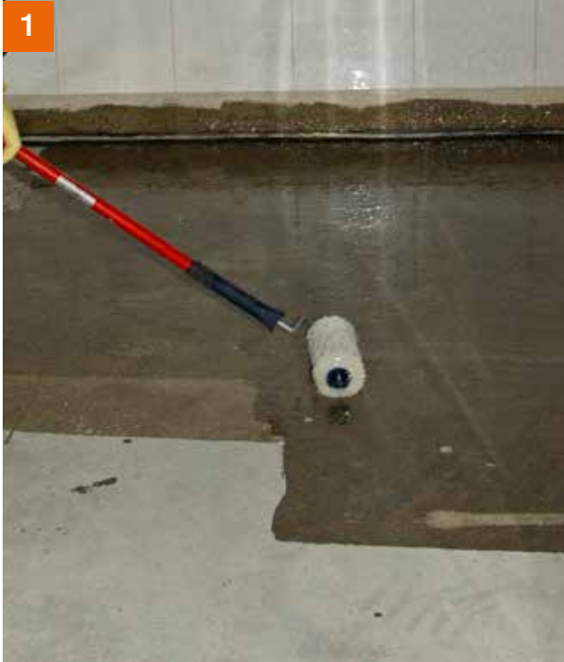
1 Untergründe vorbereiten, Verunreinigungen und nicht tragfähige Bereiche entfernen und ausgleichen. Mit PCI Epoxigrund 390 grundieren.
