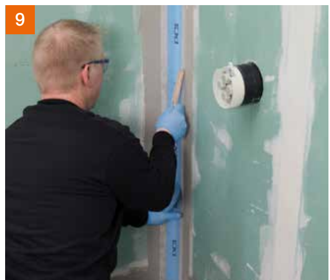
Dieselben Arbeitgänge sind auch bei senkrechten innenliegenden Ecken durchzuführen.
