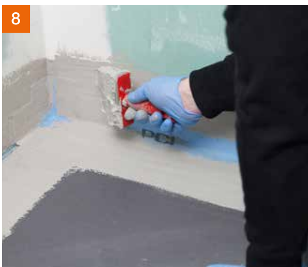
... und die vlieskaschierten Bereiche mit PCI Lastogum® überstreichen.
