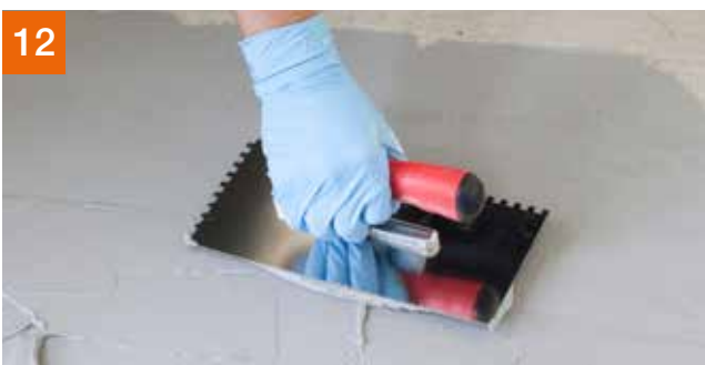
12 Kratzspachtelung mit PCI Seccoral® 2K Rapid ausführen.
