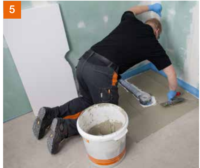
5 Die Höhenanpassung erfolgt mit Polystyrol-Hartschaumplatten in entsprechender Stärke.
