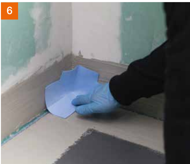
Einlegen der vorgefertigten Spezial-Innenecke PCI Pecitape® 90° I in PCI Lastogum®.
