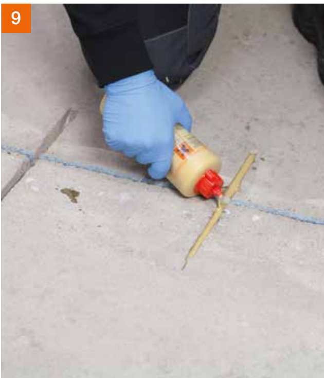
9 Danach die Nut komplett mit PCI Apogel® SH aufgießen ...
