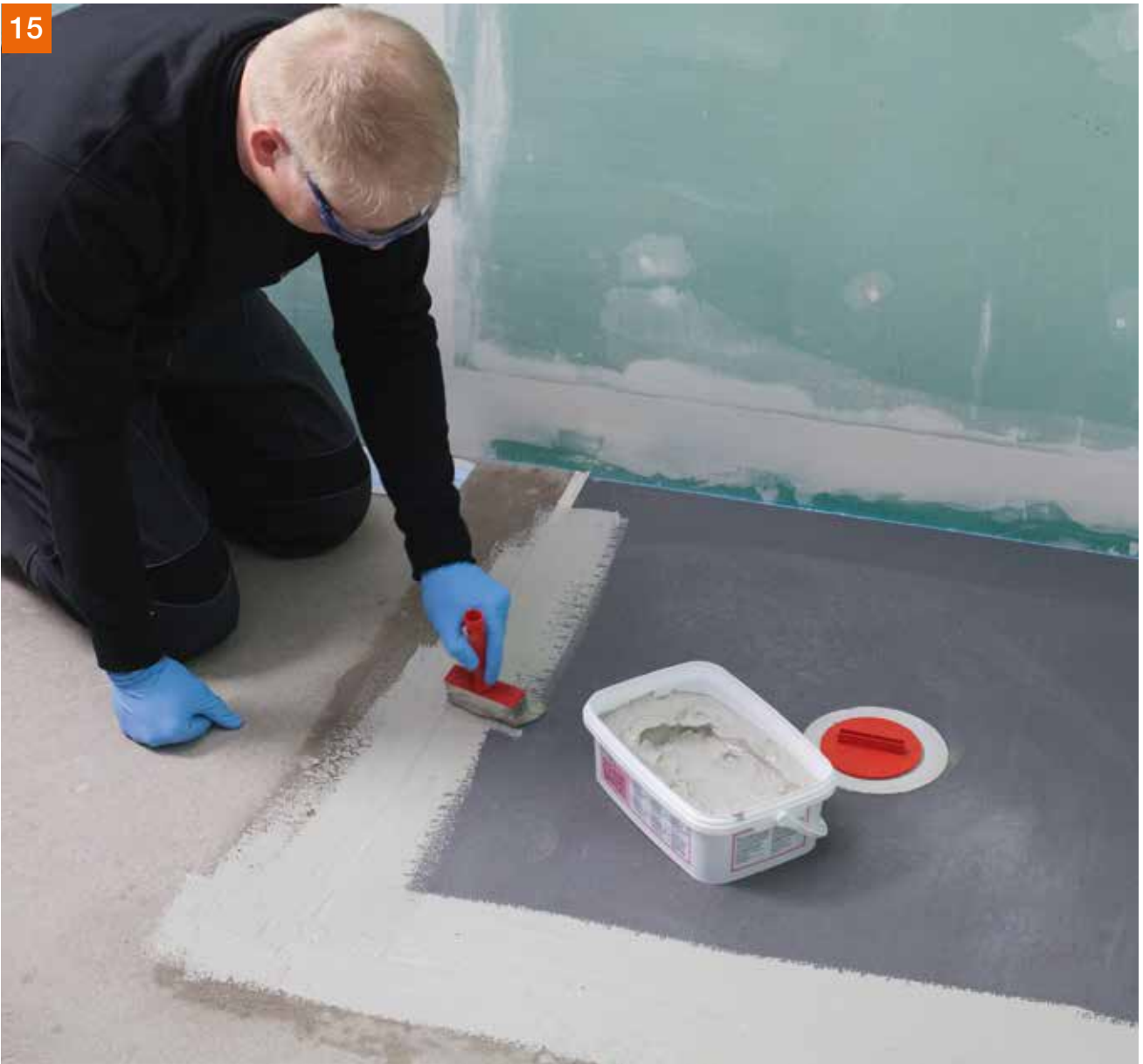
PCI Lastogum® als Kleber für die Abdichtbänder vorlegen...
