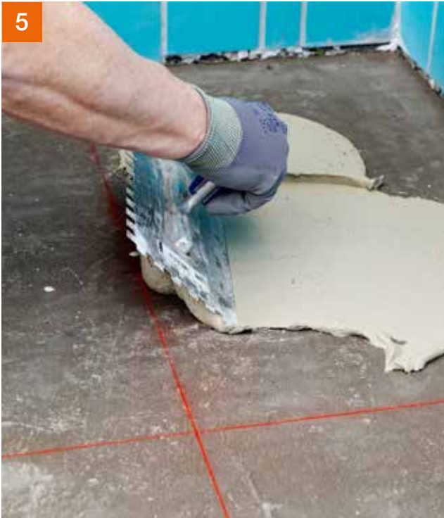
5 Auch bei der Verlegung der Bodenfliesen ...
