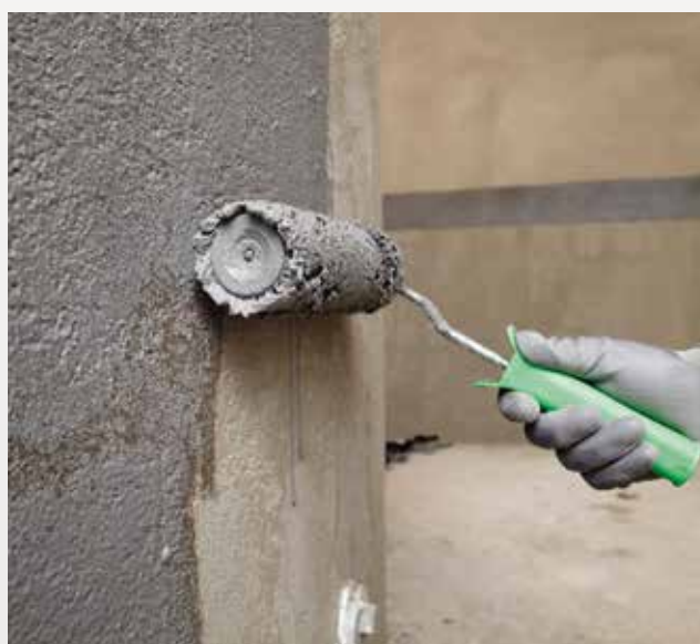
Tipp: Rollgrundierung mit verdünntem PCI Seccoral® 2K Rapid ausführen. Alle weiteren Arbeitsschritte finden Sie im Kapitel „Untergründe sicher abdichten“ ab Seite 40.
