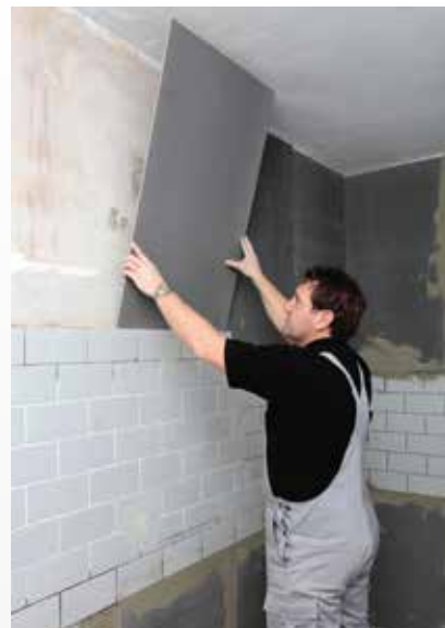
PCI Pecidur®-Element ansetzen und anschließend anklopfen.
