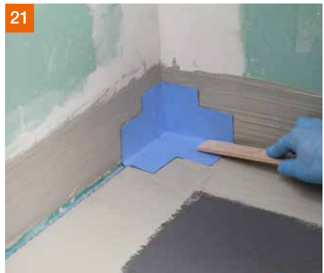
21 Vorgefertigte Spezial-Innenecke PCI Pecitape® ...
