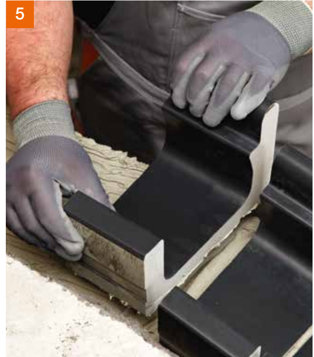
5 ... Formteil frisch in frisch setzen ...
