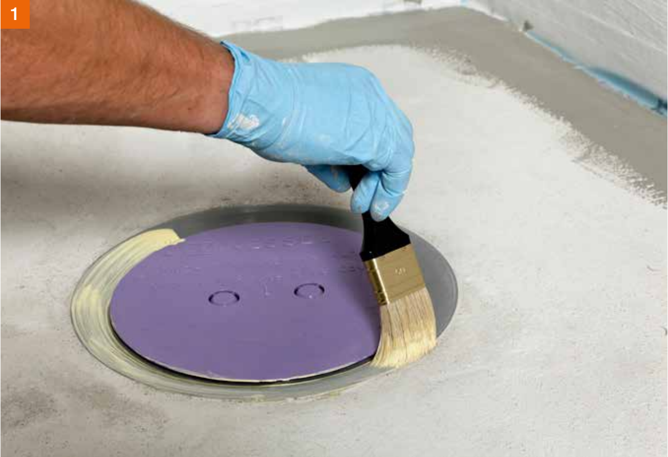
Grundierung des Flansches mit PCI Gisogrund® 303 oder PCI Gisogrund® 404.
