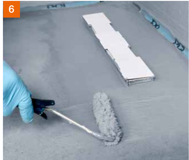
6 Anschließend die Entwässerungsrinne mit zwei Arbeitsgängen in die Flächenabdichtung einbinden.
