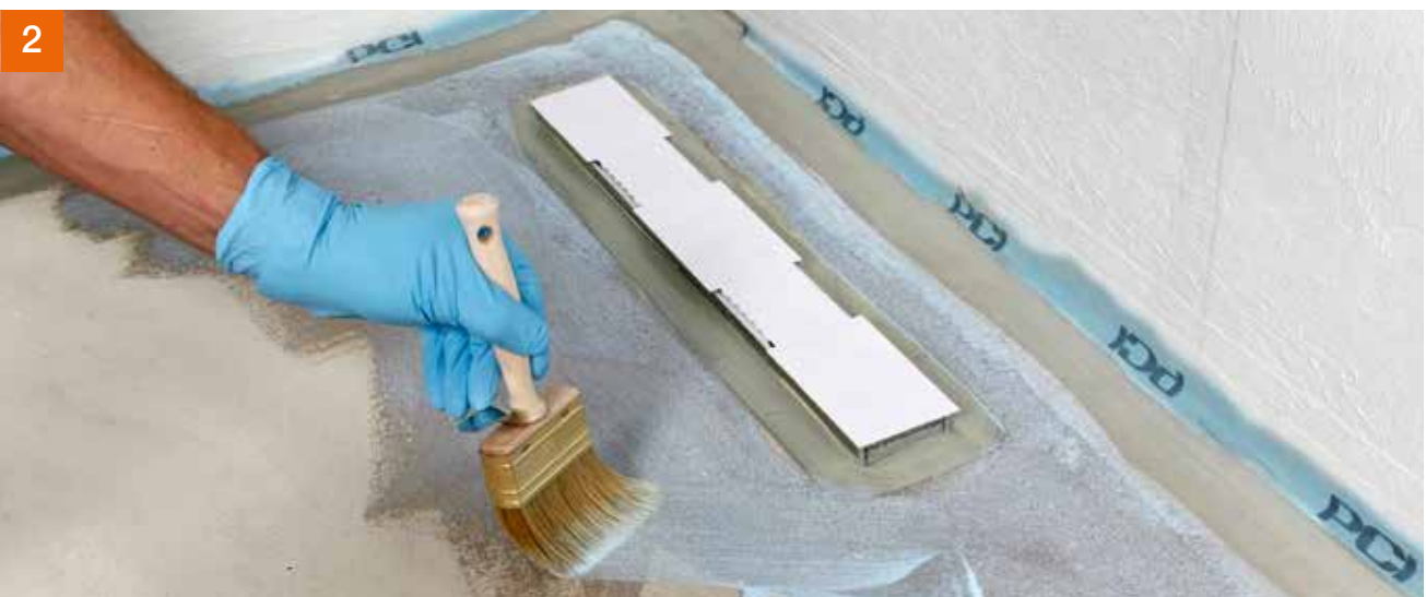
Die übrige Bodenfläche wird mit PCI Gisogrund® grundiert.
