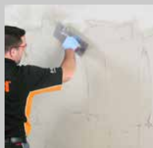
Untergrundvorbereitung für die Verlegung großformatiger Fliesen und Platten auf dem Boden und an der Wand.
