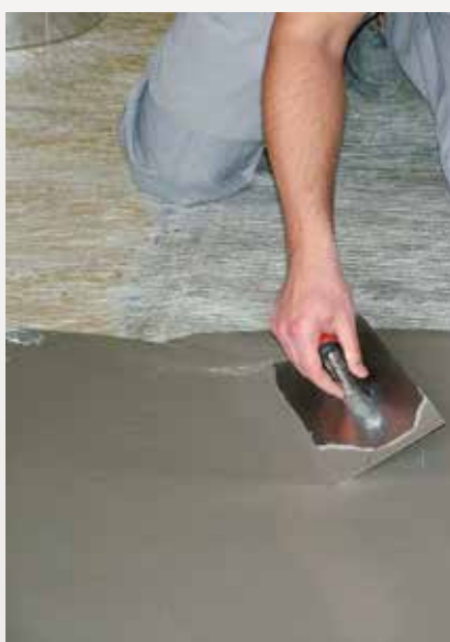
Mit einer Glättkelle verteilen (keine Rakel verwenden!) ...
