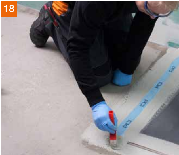
18 ...und noch einmal an den Randbereichen mit PCI Lastogum® überstreichen.
