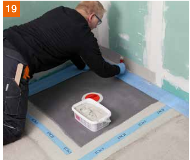
19 Nächster Schritt: Abdichten der Wand-/Bodenanschlüsse.
