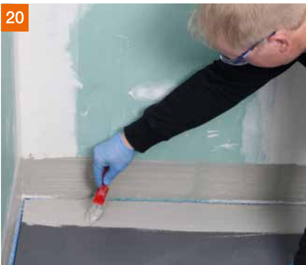
20 Abdeckung entfernen und im Randbereich PCI Lastogum® vorlegen.
