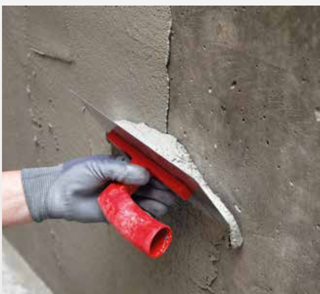
Fläche mit PCI Pericret® oder alternativ PCI Nanocret® R2 egalisieren.
