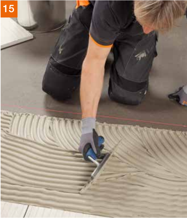
PCI Flexmörtel® S2 Premium Kleberbett aufziehen.
