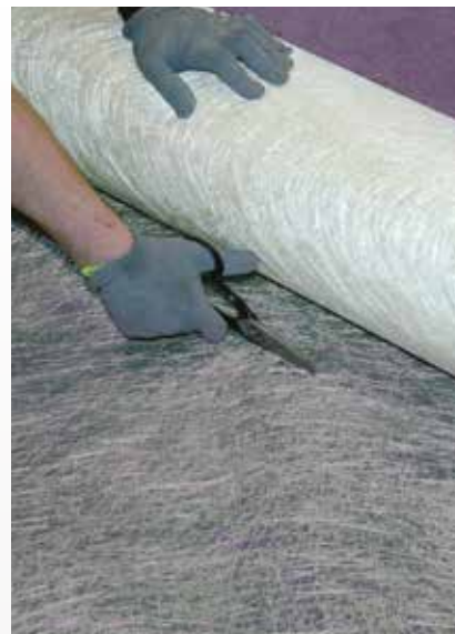
Das Glasfasergelege der PCI Armiermatte GFM mit einer Schere zurechtschneiden und auf dem grundierten Untergrund auslegen bzw. ausrollen.
