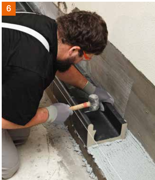
6 ... und ausrichten.
