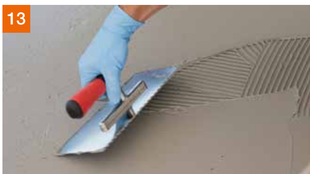
13 PCI Seccoral® 2K Rapid mit 6er Zahnung aufkämmen und anschließend glattstreichen.
