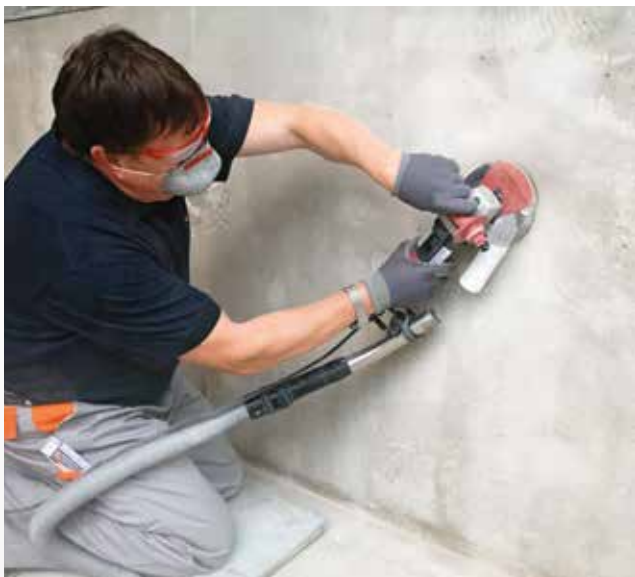
Grate und grobe Unebenheiten mittels Handfräse egalisieren.
