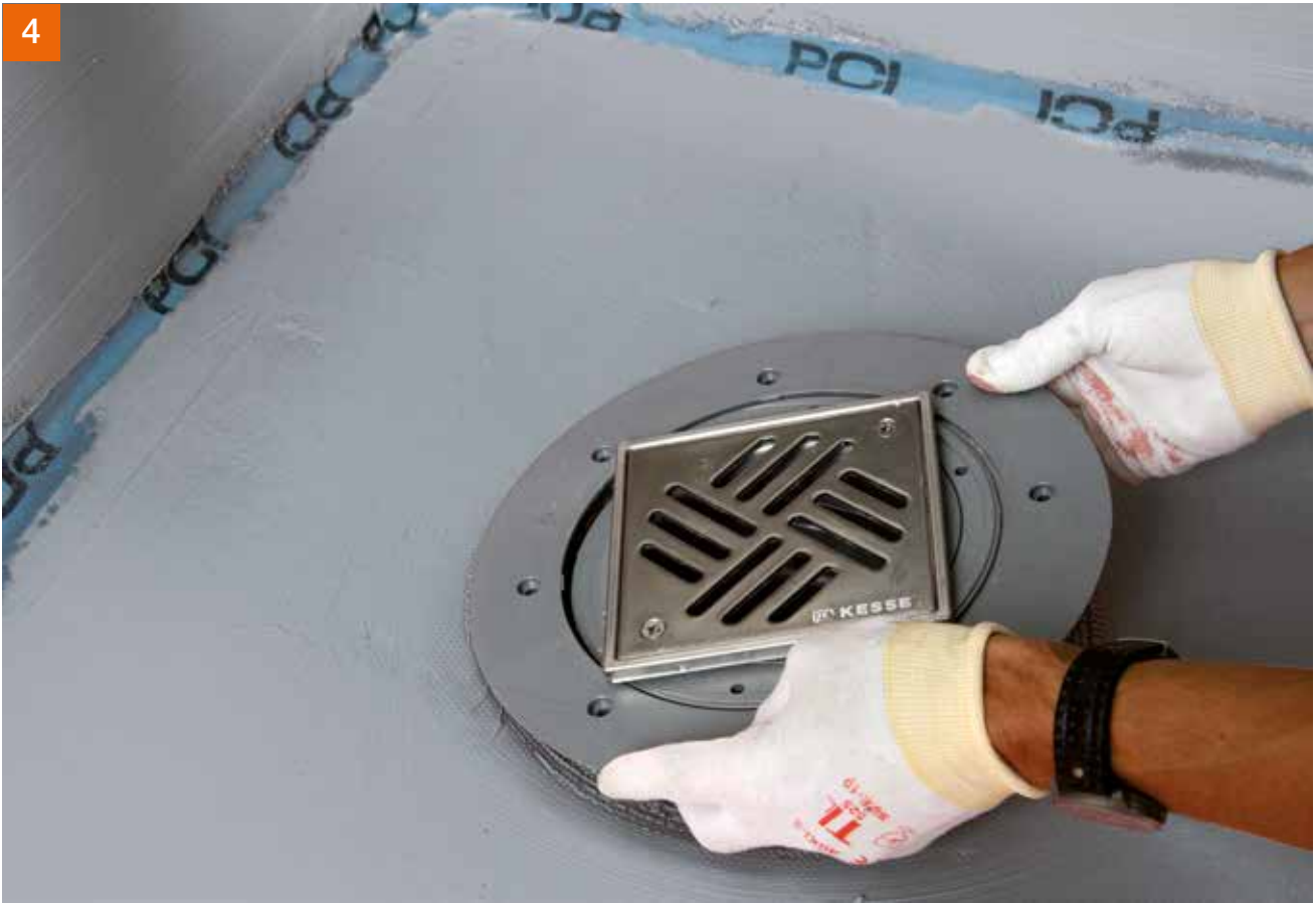
Klemmflansch aufsetzen und festschrauben.
