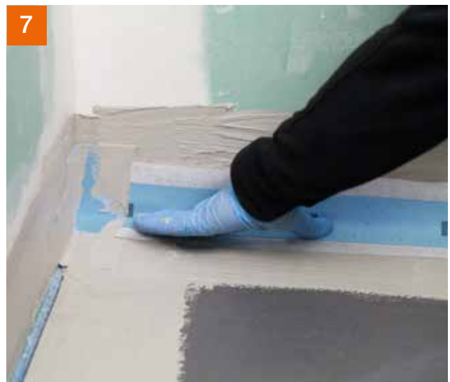
PCI Pecitape® 120 die Dichtetecke überlappend einlegen ...
