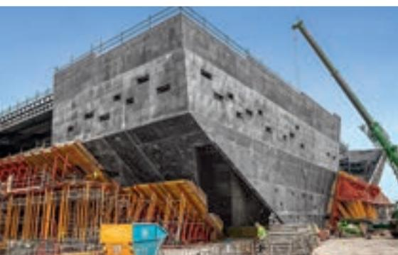
Die schottischen Küstenformationen beeinflussten den japanischen Stararchitekten Kengo Kuma bei der Gestaltung des Museums. Die Außenhülle des Bauwerks mit auskragenden Paneelen aus Beton-Fertigteilen zeigt schwarze Oberflächen in höchster Sichtbetonqualität. Um diese Gebäudestruktur in Beton abzubilden, erforderte es Schalungs- und Logistiklösungen auf höchstem Niveau.
