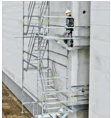
Die Anpassung an Gebäudeöffnungen erfolgt mit kurzen Treppenläufen auf außen angehängten Konsolen.
