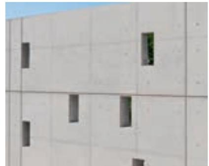
Neben den Zeitvorteilen punktet MAXIMO mit einem sehenswerten Betonergebnis durch das klar geordnete Fugen- und Ankeraster.
