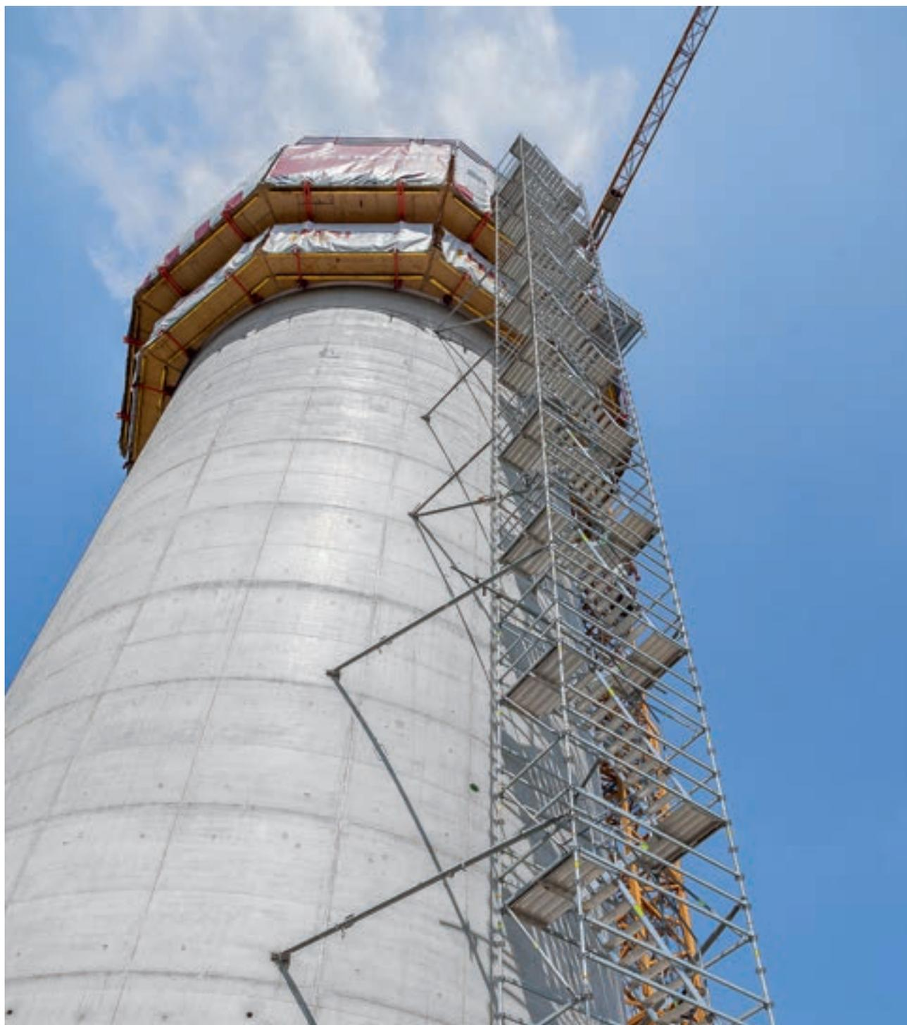
Der Wasserturm Gasperich erscheint mit 73 m Höhe, knapp 15 m Durchmesser und seiner markanten Aluminiumfassade wie ein in die Landschaft gesetztes Kunstwerk. Die Betonkonstruktion dahinter entstand mit einer PERI Kletterschalungslösung.
