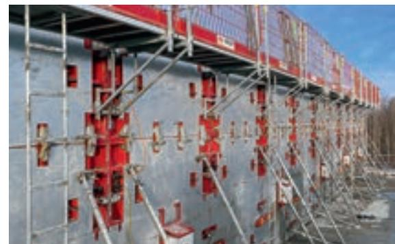
Durchdachte Sicherheitsmerkmale: Sichere Arbeits- und Betonierplattformen gehören zur MAXIMO Rahmenschalung.
