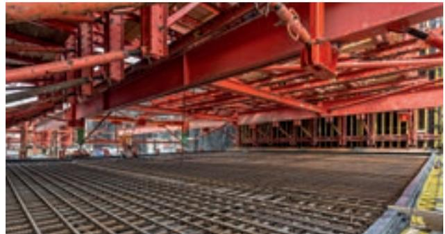
Der neue, innerstädtische Hafentunnel Bremerhaven sorgt für eine verbesserte Anbindung des Seehafens und entlastet gleichzeitig die Anwohner im Norden der Stadt. Beim Bau des 1.800 m langen Tunnels in 15 m Tiefe wurden 200.000 m<sup>3</sup> Beton und 24.000 t Stahl mithilfe der PERI Lösung verarbeitet. So auch bei der teilmonolithischen Herstellung der jeweils 10 m langen Tunnelabschnitte.
