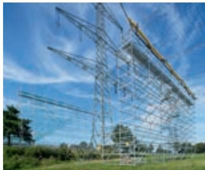
Bei Arbeiten an Freileitungen sichern PERI UP Schutzgerüste aus leichten Systemteilen die Querungsbereiche mit öffentlichen Straßen.
