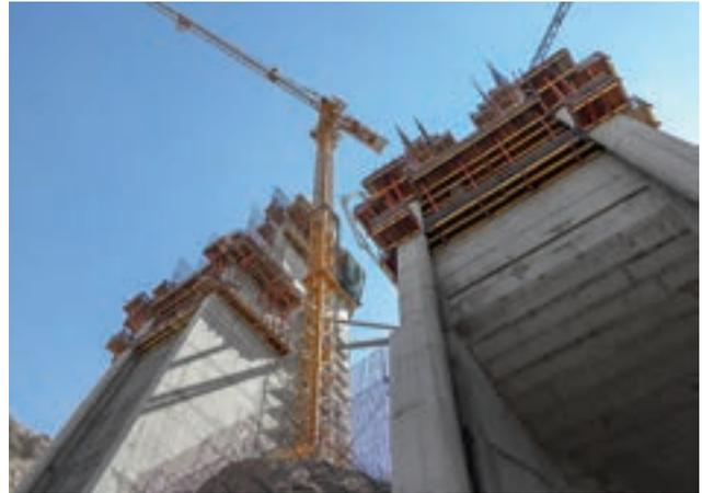
Der Laúca-Staudamm am Cuanza ist mit 1.242 m Länge und 156 m Höhe auf eine Jahresleistung von 8,6 Mrd. kWh ausgelegt. Für das imposante Wasserbauprojekt mit einer Bausumme von 4,3 Mrd. USD wurden etwa 2,6 Mio. m<sup>3</sup> Beton in Form gebracht. PERI Ingenieure unterstützten die Bauausführung mit projektspezifisch konzipierten Systemlösungen.
