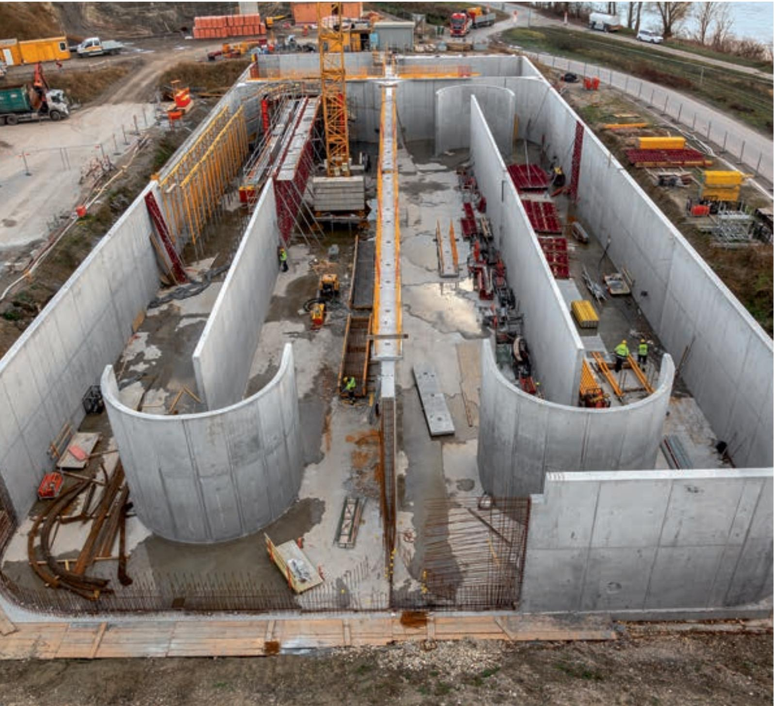
Mit der MAXIMO konnten die hohen, massiven Stahlbetonwände auf engstem Raum und in kurzer Zeit hergestellt werden. Das System war sicher und erlaubte hohen Qualitätsanspruch.
