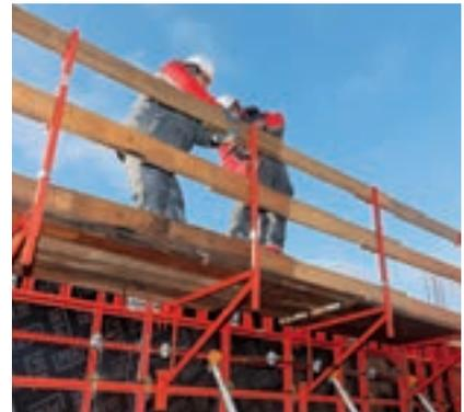
Mit Gerüstkonsolen und Geländerpfosten lassen sich 80 cm breite Arbeits- und Betoniergerüste an den LIWA Elementen montieren.
