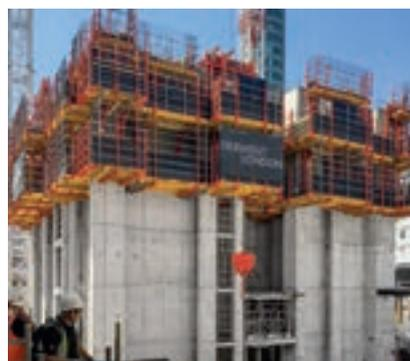
RCS CL erfordert geringen Montageaufwand und ist daher bei mittelhohen Bauwerken die passende Lösung.
