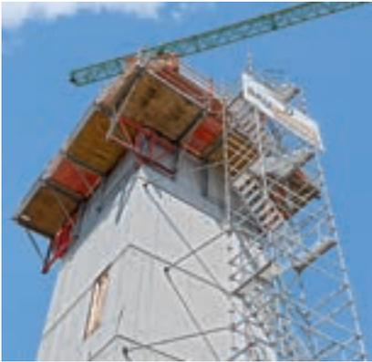
Die Falteckbühne ist sowohl links als auch rechts einsetzbar. Sie wird als Einheit mit dem Eckbühnenrahmen geliefert.
