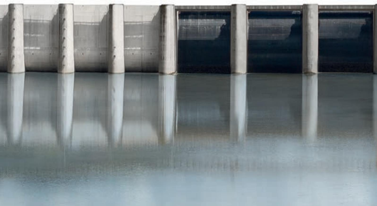
Der Laúca-Staudamm am Cuanza-Fluss in Angola, eines der größten Bauvorhaben Afrikas, wurde 2018 fertiggestellt. Mithilfe von PERI Kletterschalungslösungen wurden Bauwerke mit massiven Bauteilabmessungen betoniert.
