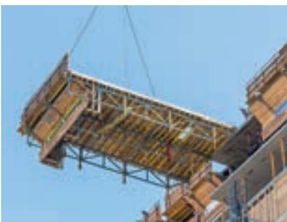
Projektbezogen geplanter Deckentisch mit bis zu 150 m<sup>2</sup> Fläche; bis zu 24,40 m Länge oder bis zu 9,00 m Breite
