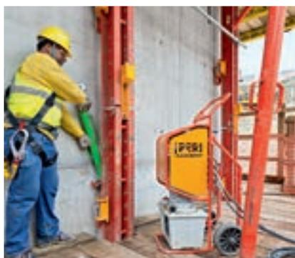
Die mobile Klettereinheit ermöglicht Klettern ohne Kran. Die Hydraulikzylinder werden zwischen Wand und Kletterschiene auf dem Kletterschuh montiert.
