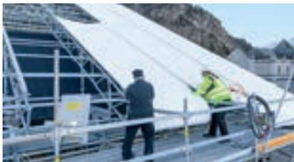
Die Plane lässt sich optional mit elektrischem Einzug schließen. Ein Rohr erleichtert das Einziehen in die Kederschiene.
