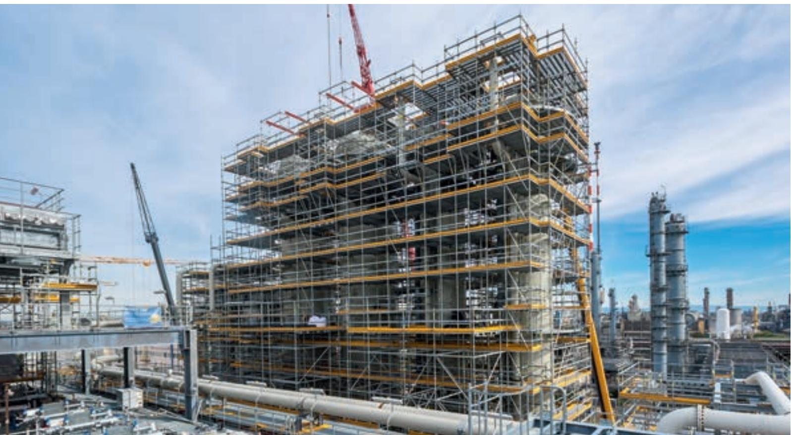
Bei einem der größten Investitionsprojekte der BASF sorgte ein innovatives Gerüstkonzept auf Basis des PERI UP Flex Gerüstsystems in Kombination mit BIM für Zeit- und Kostenersparnisse – und setzte zusätzlich hohe Maßstäbe bei der Arbeitssicherheit.
