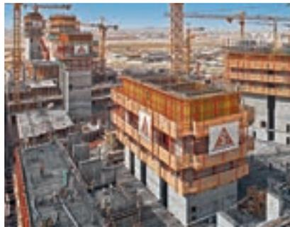
Kombiniert z. B. mit dem RCS Schienenklettersystem lässt sich das System auch für Aufzug- und Treppenhäusschächte von Hochhäusern einsetzen.
