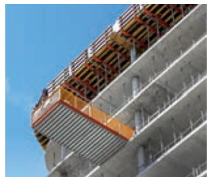
Standardmäßig als vormontierte Ausfahrbühne mit Längen von 3,75 m und 5,50 m verfügbar
