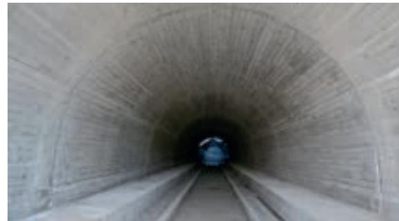
VARIOKIT, SLS Schwerlastspindeln, GRV Riegel und GT 24 Gitterträger, von PERI als Einheit genau auf das Bauwerk abgestimmt, sicherten eine termingerechte Übergabe des Fußgängertunnels unter dem geplanten Abschnitt der Autobahn 3, noch dazu in hervorragender Sichtbetonqualität.
