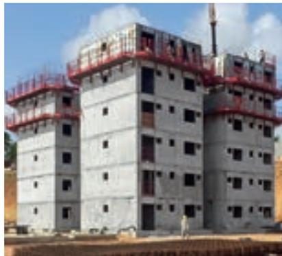
Konsolen und Geländerpfosten sorgen für die Sicherheit der Anwender bei mehrgeschossigen Einsätzen der UNO+.
