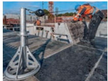
Der SKY-Anker dient beim Einschalen von oben als Anschlagpunkt für eine Person mit persönlicher Schutzausrüstung gegen Absturz.
