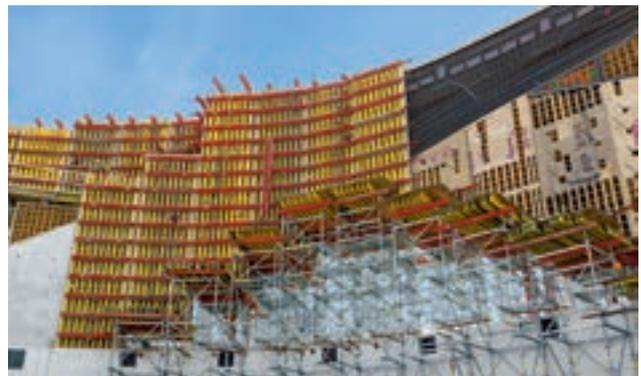
Die Bauwerkskonstruktion des skulpturalen Museumsbaus besteht aus mehreren konzentrischen, aus dem Boden wachsenden Bögen. Die Bögen kreuzen sich und bilden auf diese Weise miteinander verflochtene Betonringe, die sowohl die Museumswände bilden als auch eine höher gelegene Freifläche unterstützen. Das anspruchsvolle Gebäude musste im Wesentlichen auf Basis eines 3D-Modells errichtet werden, da aufgrund der komplizierten Struktur keine Maßangaben in den Plänen enthalten waren.
