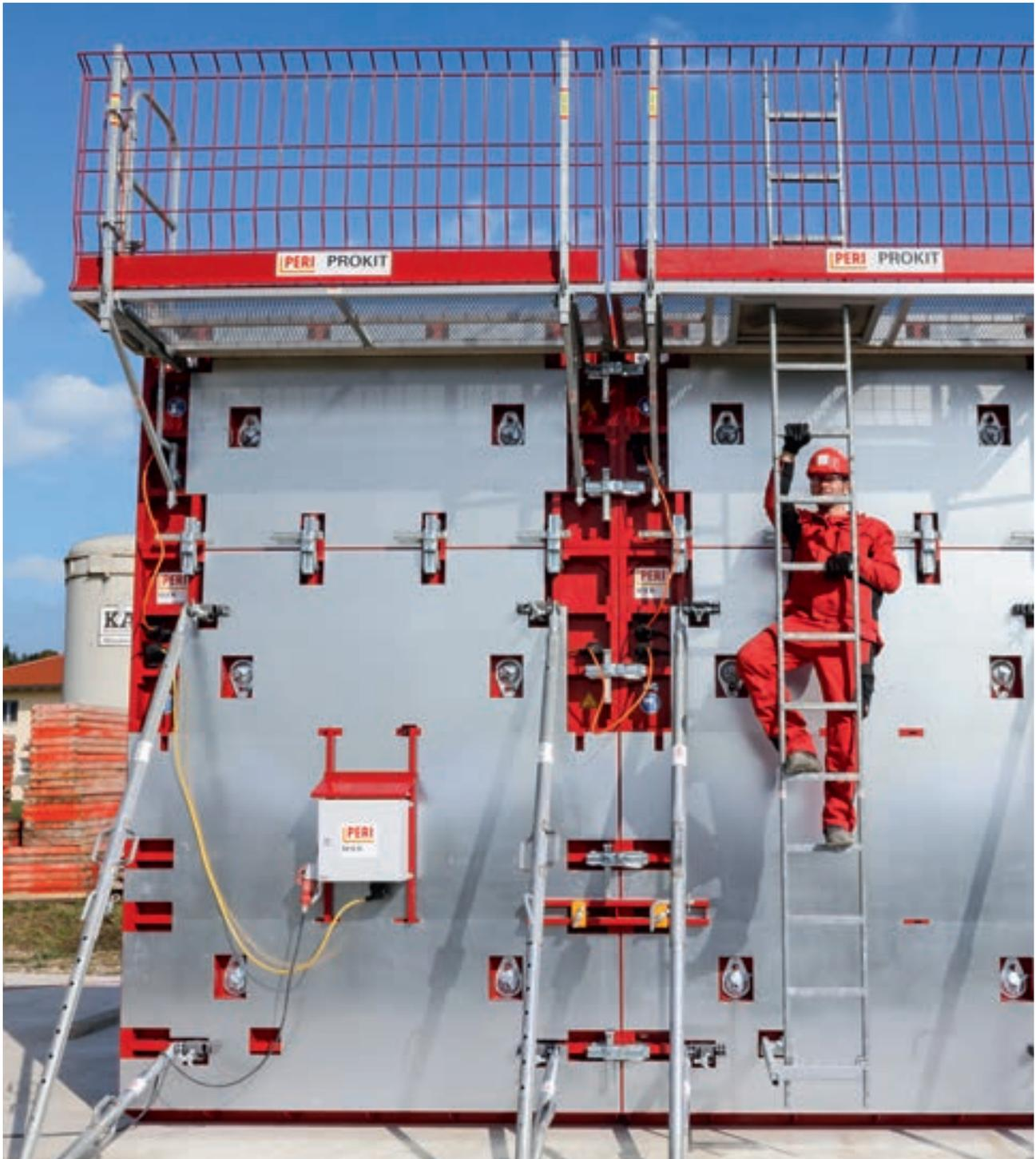
Wenn auch im Winter gebaut werden muss, setzen die Temperaturen nicht nur den Menschen zu. In Finnland bewährte sich bei Temperaturen um und unter dem Gefrierpunkt die beheizbare Schalung MAXIMO MXH beim Betonieren der über 5 m hohen Wände eines Gemeindezentrums.
