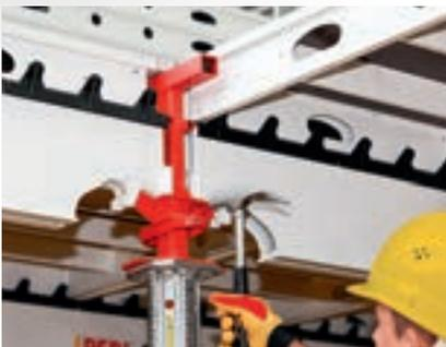
Ein Hammerschlag entriegelt den Fallkopf, dabei senkt sich die Schalung um 6 cm ab. Längsträger und Paneele können dann ausgeschalt werden.
