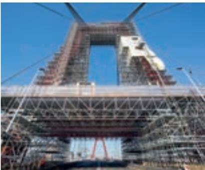
Mit dem PERI UP Flex Gitterträger ULS lassen sich weitgespannte Arbeits- und Schutzgerüste realisieren. Darunter befindliche Personen oder laufender Verkehr können vor herabfallenden Gegenständen geschützt werden.
