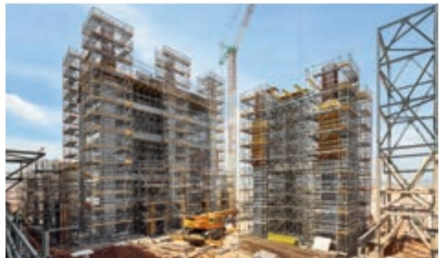
Das Megaprojekt im Süden Malaysias wächst außerordentlich schnell – ebenso, wie das Trag- und Arbeitsgerüst der Cracking-Anlage für schwere Reststoffe aus den ersten Erdöl-Verarbeitungsschritten. Der 30 m hohe Reaktorturm ist der höchste Teil des Anlagensegments. Das gesamte Gerüstsystem mit Stütztürmen, Zugängen und Arbeitsebenen wurde mit PERI UP Flex realisiert. Als Träger-Wandschalung kam VARIO GT 24 zum Einsatz.
