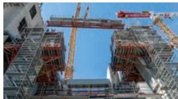
PERI UP gewährleistete den kontinuierlich mitwachsenden Treppenzugang zu den Bühnenebenen der Stützen-Kletterschalung. Kombiniert mit VARIOKIT Systembauteilen, ermöglichten bis zu 17 m frei spannende, kranversetzbare PERI UP Montagegerüste die sichere Unterzugmontage in knapp 30 m Höhe.
