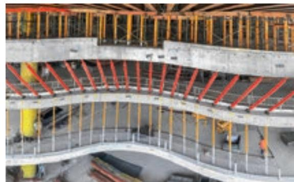
Zur Abstützung weit auskragender Bereiche in den unteren Stockwerken kamen MULTIPROP Deckenstützen und Schwerlastspindeln des VARIOKIT Ingenieurbaustens zum Einsatz.
