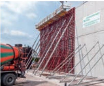
MAXIMO wird schwerpunktmäßig im Hoch- und Industriebau eingesetzt. Das System folgt einem klar gegliederten Elementraster von 30 cm.
