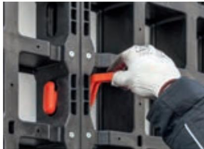
Ein Beispiel für einfachstes Bedienen: Die Form des DUO Verbinders und der Paneelöffnungen erlauben nur eine einzige Einbaumöglichkeit.
