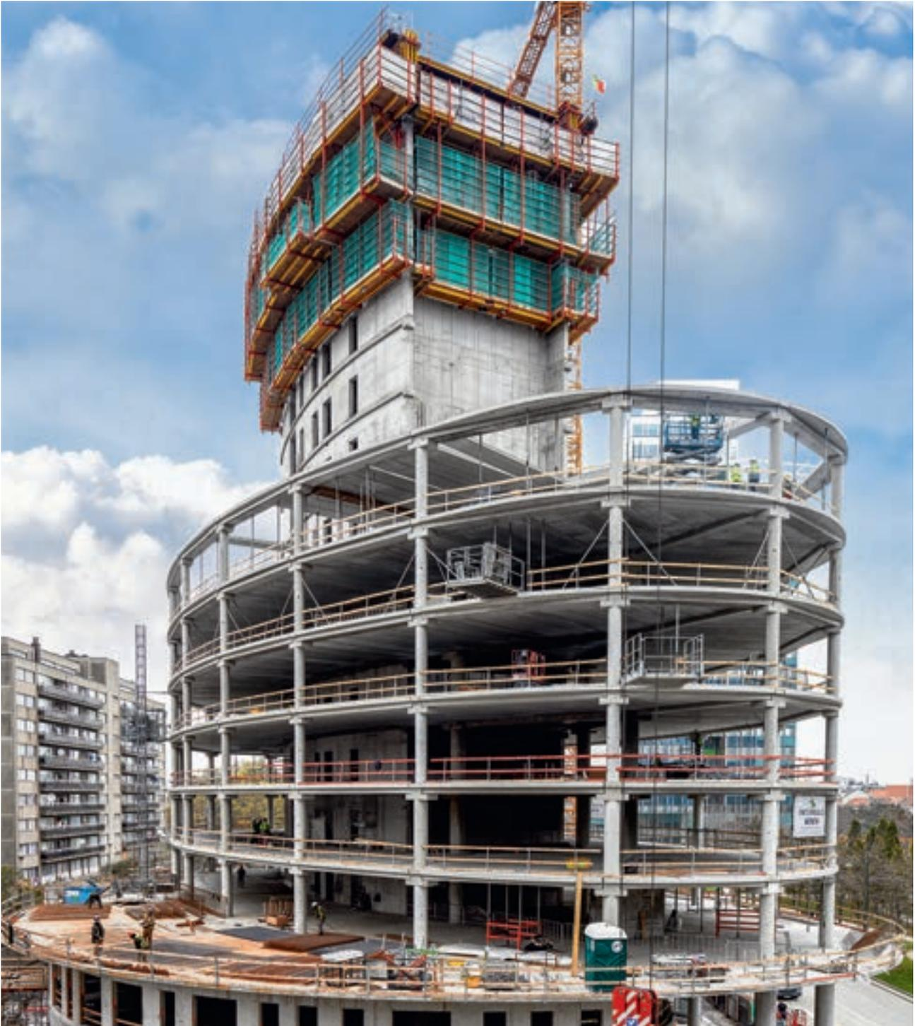
Bei den in zwei Bauphasen entstehenden elliptischen Möbius Towers in Brüssel ermöglichte die PERI Kletterschalungslösung schnelle Ausführungszeiten. Wertvolle Kranzeit wurde reduziert, der enge Bauzeitenplan konnte eingehalten werden.
