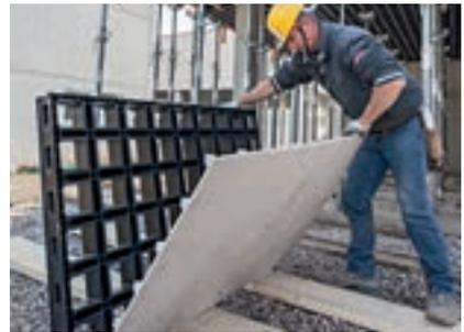
Die Ersatzschalhaut lässt sich mit einigen Schrauben von Hand montieren – auch auf der Baustelle und ohne besonderes Werkzeug.
