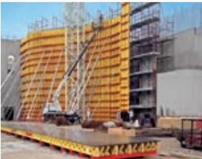
Großformatige FinPly Maxi Schalungsplatten eignen sich hervorragend für hochwertige Sichtbetonoberflächen.
