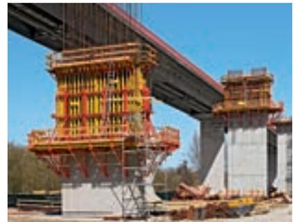
Beim Schalen von Brückenpfeilern wird die VARIO GT 24 Wandschalung häufig auf Kletterkonsolen eingesetzt.
