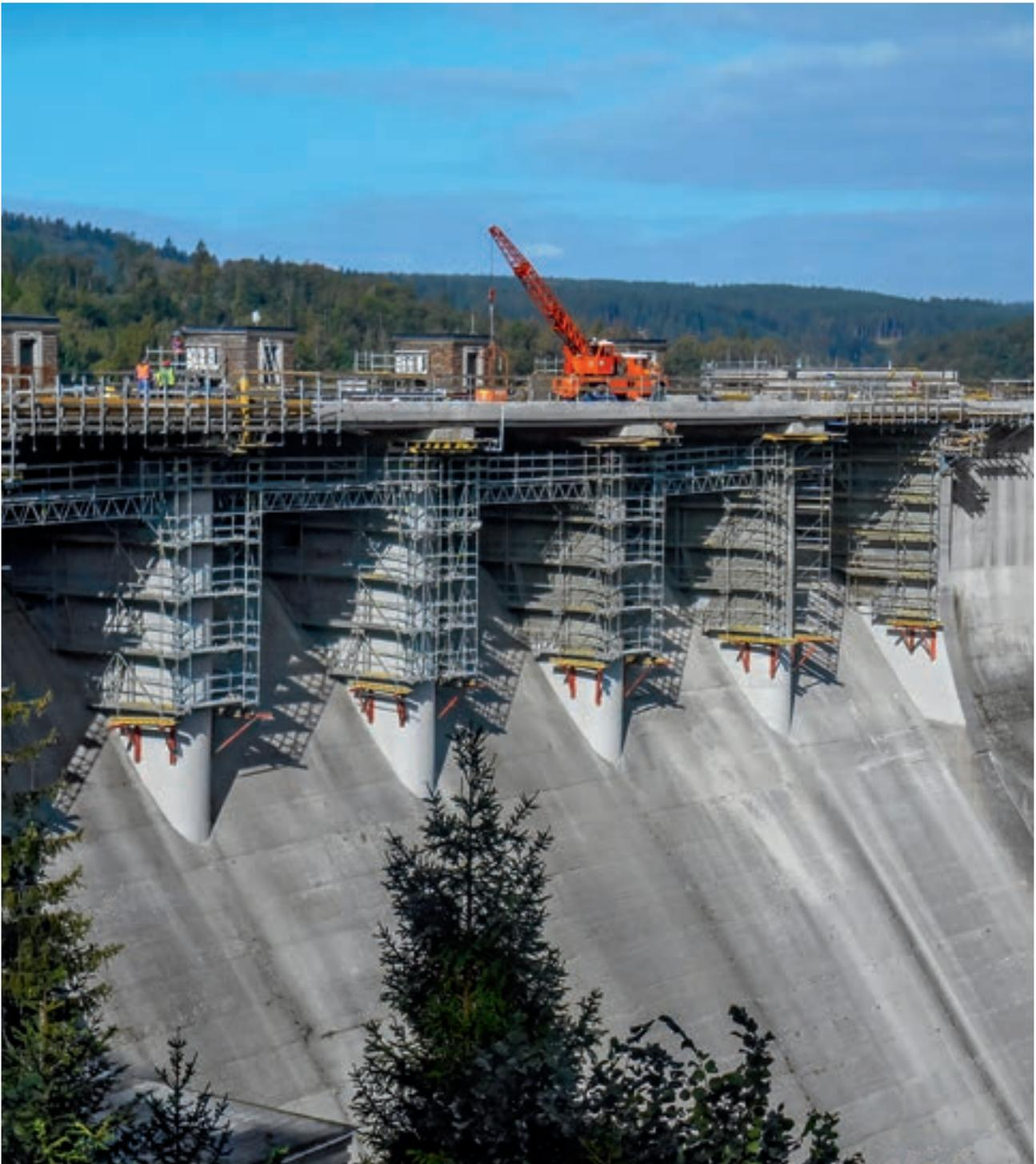
Der Einsatz flexibler Schalungs- und Gerüstlösungen rationalisierte die Sanierung am tschechischen Wasserkraftwerk und bot Montage- und Arbeitssicherheit in allen Bereichen.
