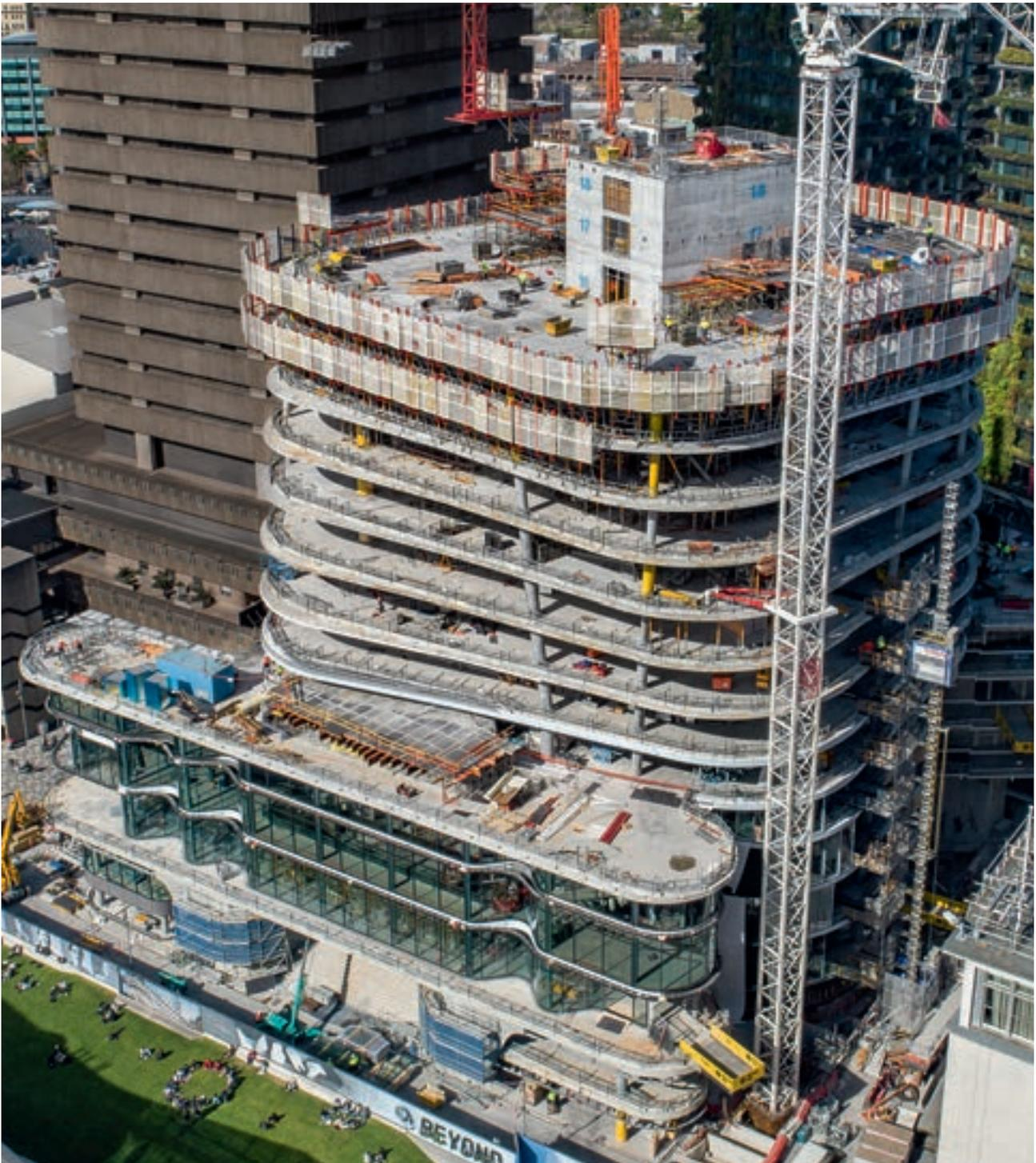
Die Arbeiten am neuen Gebäude der UTS wurden mit einer projektspezifisch angepassten Schalungslösung deutlich beschleunigt. Speziell angebrachte LPS Gittereinhausungen sorgten zudem für höchstmögliche Sicherheit während des Bauprozesses.
