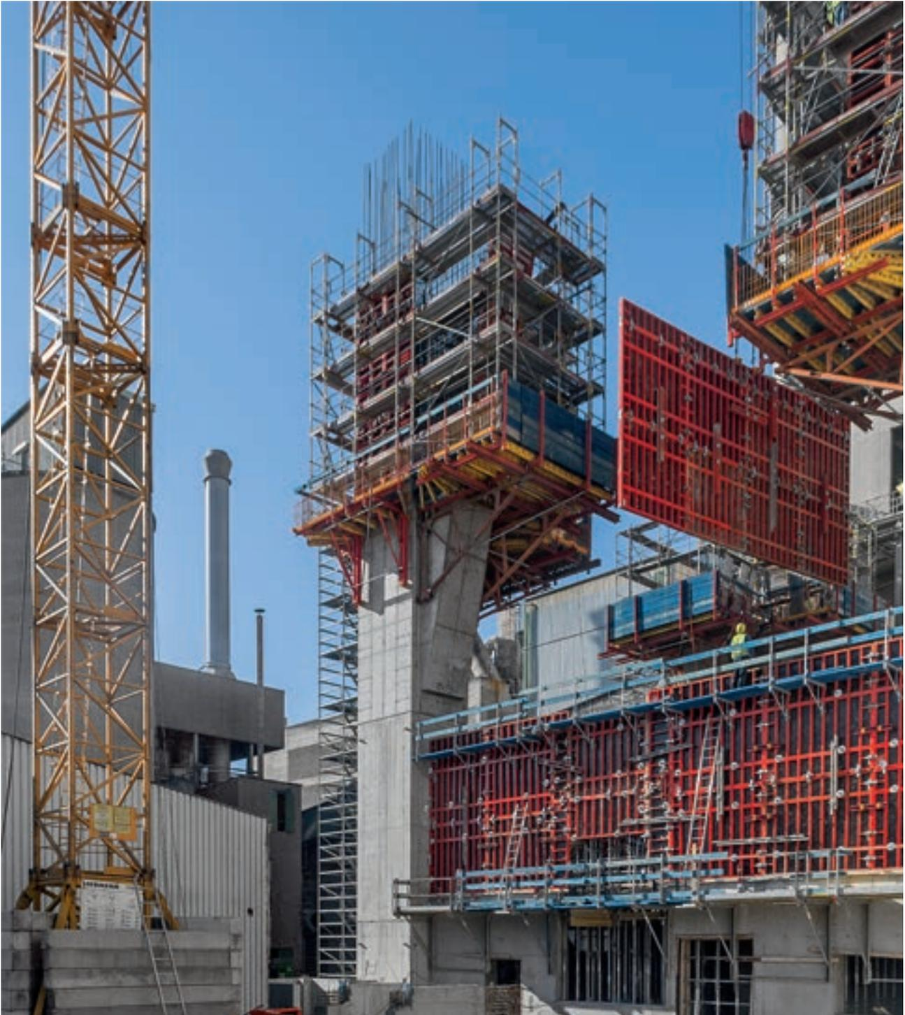
Die exakte Koordination der Arbeitsschritte, die Bereitstellung großer Materialmengen in kurzer Zeit und das Arbeiten mit großflächigen Kletter- und Umsetzeinheiten erleichterten die Herstellung des komplexen Rohbaus in nur 8 Monaten Bauzeit.
