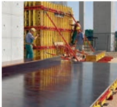
Für Sichtbetonoberflächen bietet das PERI Plattenprogramm hochwertige, filmbeschichtete Sperrhölzer.
