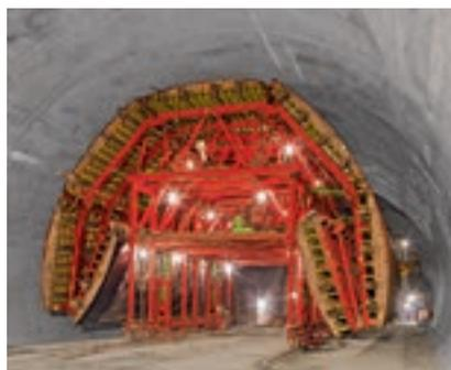
Dieser Tunnelschalwagen auf Basis des VARIOKIT Baukastens dient zur Herstellung des befahrbaren Querschlags zwischen zwei Tunnelröhren.
