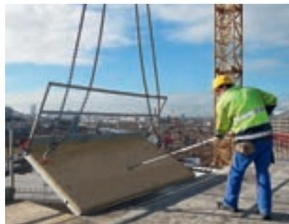
Die SKYDECK Bühne ermöglicht sicheres Arbeiten am Deckenrand.
