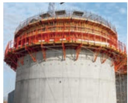
RUNDFLEX lässt sich auch auf Kletterkonsolen, wie beispielsweise bei der Herstellung von Silos, einsetzen.
