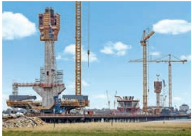
Drei Pylone tragen den etwa 1.000 m langen Brückenüberbau über den Mersey River. Als Unterstützung des Überbaus weitet sich der höchste Pylon in etwa 20 m Höhe von 6 m auf insgesamt 17,5 m aus. An dieser Stelle wurden Hammerkopf- und Pfeilerkopfschalungen eingesetzt.
