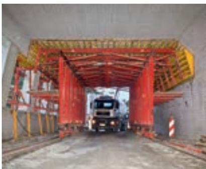
Für das Verfahren des Schalwagens durch einen engeren Querschnitt lassen sich die Schalungsegmente hydraulisch einklappen.
