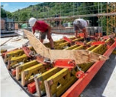
Mit einem Ratschenschlüssel werden die selbstreinigenden Stellspindeln auf die gewünschte Krümmung eingestellt.
