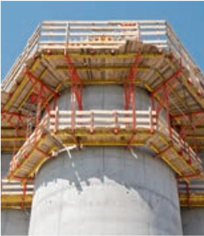
Tragkonstruktion zur Unterstützung einer geankerten Wandschalung; alternativ reines Arbeitsgerüst
