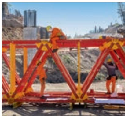
ALPHAKIT lässt sich ohne Kran von Hand am Boden vormontieren und eignet sich somit auch für den Einsatz auf Baustellen mit beengten Montageplatzverhältnissen.
