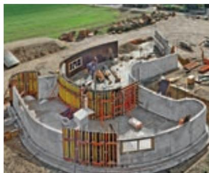
Die Radien der RUNDFLEX Elemente werden mit Spindeln angepasst. Der Umbau bei wechselnden Radien ist also äußerst schnell gemacht.
