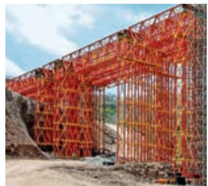
Bei dem modularen System lassen sich Türme und Binder mit wenigen Bauteilen realisieren. Die Türme sind in der Höhe stufenlos anpassbar.
