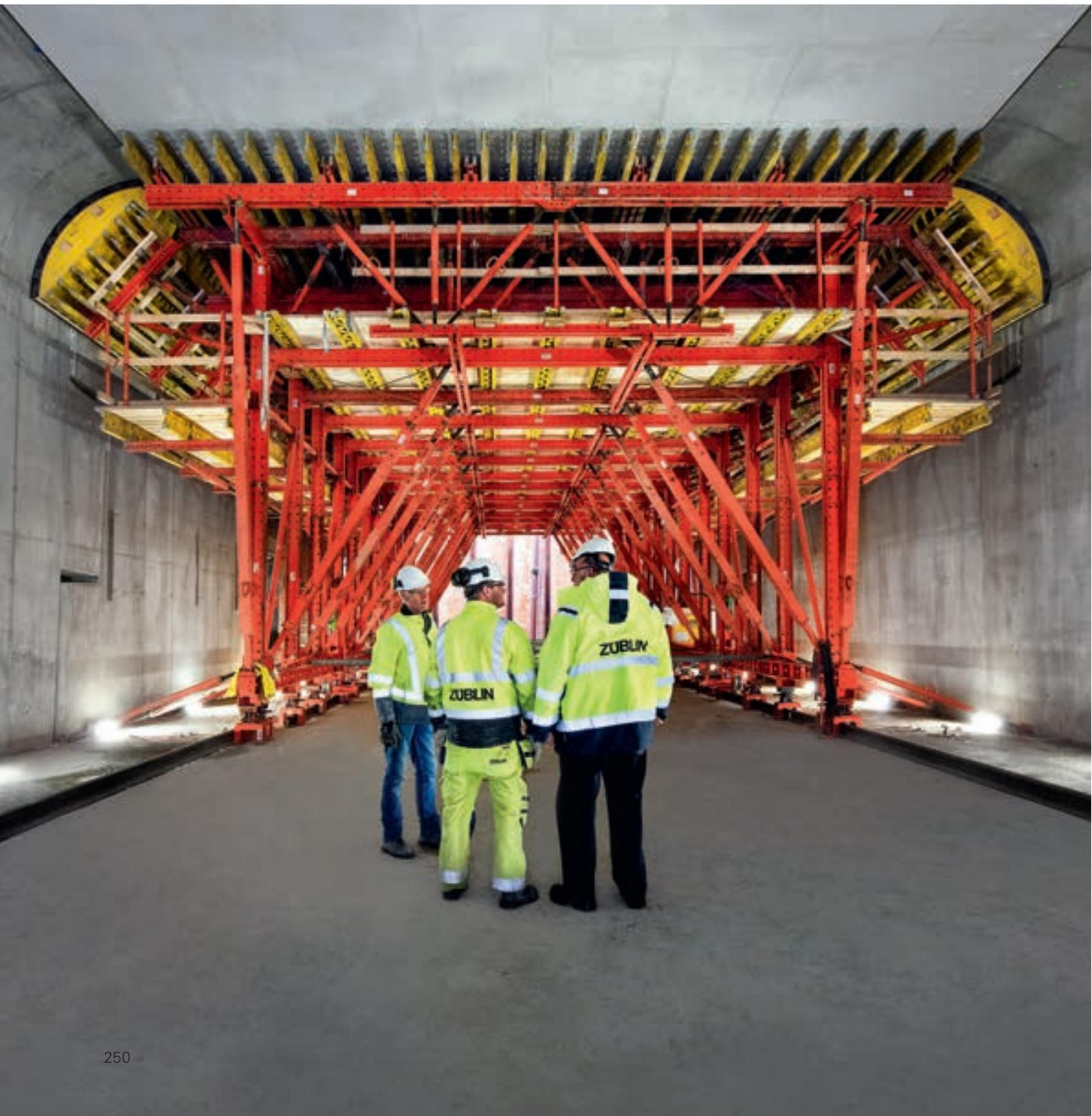
Beim Fertigen der drei 100 m langen Segmente für den Göteborger Absenktunnel stellte der Ingenieurbaukasten VARIOKIT effizientes Arbeiten im Trockendock sicher. Projektspezifische Lösungen im Mix mit standardisierten Systemteilen optimierten die Kosten.
