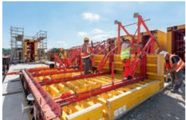
Parallel zur bisherigen Moselschleuse Trier entstand eine neue 216 m lange, 12,60 m breite und 12,70 m hohe Schleusenkammer. Da das 15 m tiefe Bauwerk einen sehr hohen Bewehrungsrad erforderte, lieferte PERI werksseitig vorgefertigte Schalungen auf Basis der VARIO GT 24 Träger-Wandschalung just in time auf die Großbaustelle, projektspezifisch angepasst, mengenmäßig und zeitlich genau auf die Technologie der Baustellen abgestimmt.
