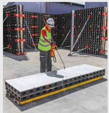
Mithilfe des Trennmittelsprühgerätes können Sie das Trennmittel PERI Plasto Clean einfach auftragen.
