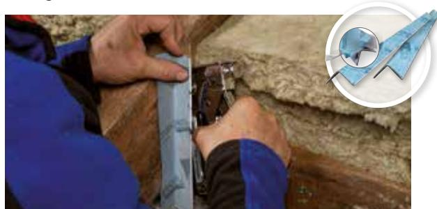
Schafft eine definierte Ebene für den einfachen und sicheren luftdichten Anschluss an eckige und leicht abgerundete Durchdringungen, z. B. bei der traufseitigen Sparrendurchführung bei Dachsanierungen von außen mit dem DASAPLANO-System, an sichtbare Zangenlagen im Steildachbereich oder an Deckenbalken geschossübergreifender Innendämmungen von Wänden.
