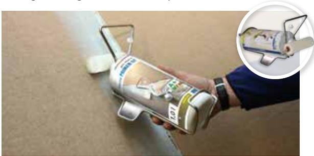
Auftragswerkzeug für besonders schnelles und einfaches Auftragen der lösemittelfreien Haftgrundierung TESCON PRIMER RP in der 1 l Spenderflasche.
