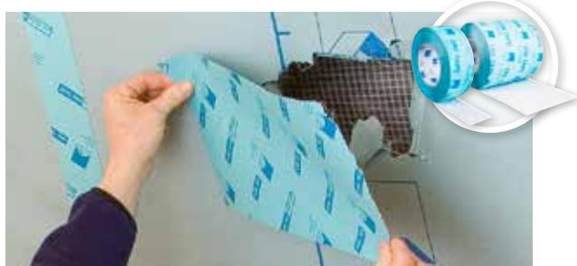
UNI TAPE: Für dauerhaft luftdichte und sichere Verklebung der Überlappungen von Dampfbrems- und Luftdichtungsbahnen und deren Anschlüsse im Innenbereich. Auch für die Verklebung der Stoßfugen von Holzwerkstoffplatten geeignet.
