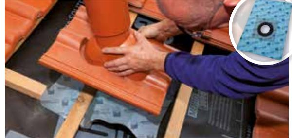
Für den schnellen, dauerhaft winddichten und wasserführenden Anschluss der Unterdeckung bzw. Unterspannung unter dem Durchgangsziegel. Bei Bedarf kann die Manschette flexibel angepasst werden. Das Klebepatch ist diffusionsfähig.
