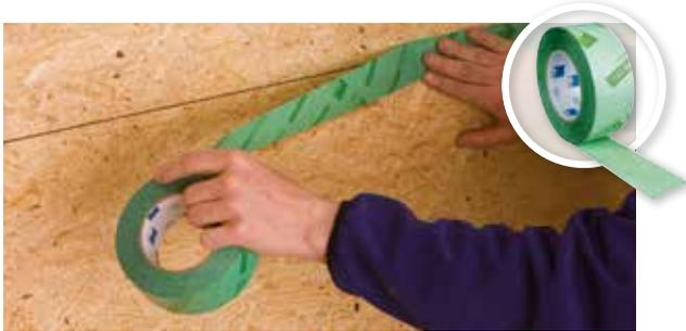
Für wirtschaftliche und dauerhaft luftdichte Verklebung der Stöße von Holzwerkstoffplatten. Auch für die Verklebung der Bahnenüberlappungen von Dampfbremsen geeignet.
