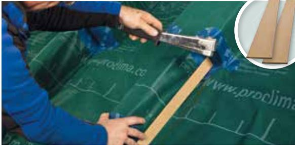
Für den einfachen sicheren, eng an den Sparrenflanken anliegenden Einbau einer Sub-and-Top-Sanierungs-Dampfbremse, z. B. DASATOP.
