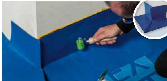
Sichere Ausführung von Inneneckanschlüssen im SOLITEX WELDANO-Unterdachsystem. Das werkseitig vorverschweißte, diffusionsoffene Formteil kann mit dem System-Quellschweißmittel oder Heißluft materialhomogen mit der Unterdachbahn SOLITEX WELDANO verbunden werden.
