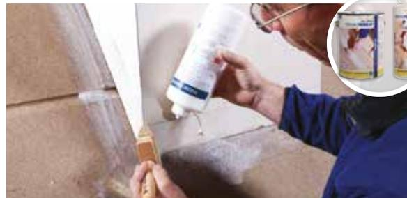
Zur Vorbereitung bzw. Ertüchtigung des Untergrundes für die anschließende Verklebung mit pro clima Klebebändern, wie z. B. TESCON VANA, TESCON PROTECT und Klebebänder der EXTOSEAL-Familie. Für Holz, Holzfaserplatten, Mauerwerk, Dach, Wand und Bodenplatten geeignet.
