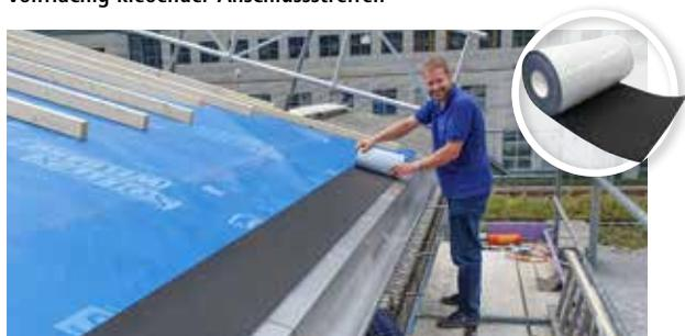
Traubahn zur Verlegung auf SOLITEX WELDANO für den offenen Traufabschluss mit Lochblech. Ermöglicht das Entwässern des Unterdachs in die Dachrinne.
