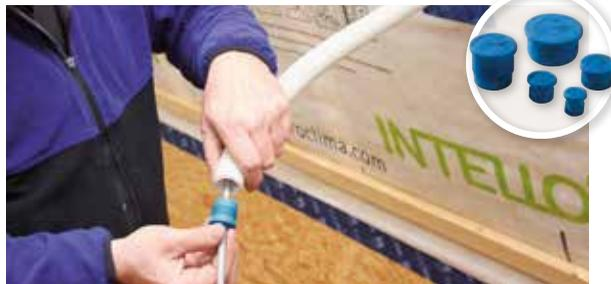
Für die schnelle und dauerhaft sichere luftdichte Einbindung von Kabeln in Leerrohre. Für den luftdichten Anschluss von Leerrohren an die Dampfbremse- und Luftdichtungsebene stehen Leerrohrmanschetten (z. B. ROFLEX 20 oder ROFLEX 20 multi) zur Verfügung.
