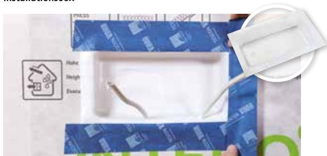
Bei Konstruktionen ohne Installationsebene kann die INSTAABOX Raum für Gerätedosen o.ä. schaffen. Dazu wird sie auf der vorhandenen Dampfbrems- und Luftdichtungsebene angebracht und mit dieser luftdicht verbunden. Die INSTAABOX kann sowohl bei Innen- als auch bei Außenwänden eingesetzt werden.
