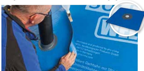
Sichere Ausführung von Rohrdurchdringungen im SOLITEX WELDANO-Unterdachsystem. Mit der vorgefertigten Manschette werden Rohrdurchführungen einfach, schnell und dauerhaft dicht hergestellt. Geeignet für Dachneigungen von 5° bis 50°. Um eine dauerhafte Dichtheit auch bei Rückstauwasser zu erreichen, muss an den entstehenden Flansch ein SOLITEX WELDANO-S Streifen angeschweißt werden (siehe Verarbeitungshinweise).
