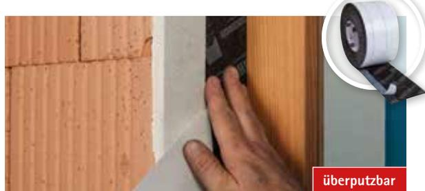
Für den außenseitig winddichten und schlagregensicheren Anschluss von Fenstern und Türen an flankierende Bauteile aus Holz und mineralische Untergründe, wie z. B. Beton und Mauerwerk, vollflächig klebend. Die Klebezone auf der Vliesseite ermöglicht einfachere Verklebung an Fenster und Türen bei Verarbeitung vor deren Montage.
