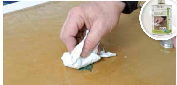
pro clima GLUMEX mit einem weichen Lappen auf der zu reinigenden Oberfläche verteilen und leicht einreiben. Bereits nach wenigen Minuten sind Ablöseerscheinungen erkennbar. Mit einem rauen Material (z. B. Putzwolle oder eine Bürste) kann jetzt die Verunreinigung abgerieben werden. Sollten Rückstände zurückbleiben kann der Vorgang wiederholt werden. Es ist empfehlenswert die Verträglichkeit von GLUMEX mit der vorhandenen Oberfläche vorab an einer nicht sichtbaren Stelle zu testen.
