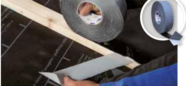
Einseitig klebendes Nageldichtungsband unter der Konterlattung bei geneigten Dachkonstruktionen. TESCO NAIDECK mono ist für die Erstellung von Behelfdeckungen für Unterdeck- und Unterspannbahnen geeignet.
