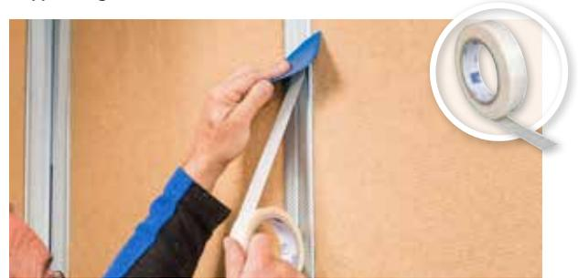
Für die feuchtgeschützte Verklebung von Unterdeck-, Unterspann- und Wandschalungsbahnen. Auch für die Befestigung von Dampfbremsen auf Metallprofilen geeignet.
