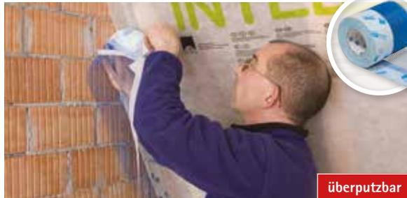
Für definierte gewerkeübergreifende Anschlüsse von Bahnen bzw. Holzwerkstoffplatten an zu verputzende Bauteile (Mauerwerk bzw. Beton).
