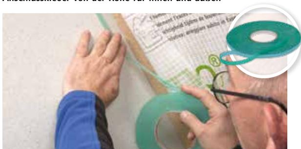
Lösemittelfreier, dauerhafter, elastischer, frostsicherer Luftdichtungskleber von der Rolle für den Anschluss von Dampfbremsen und Dampfsperren.
