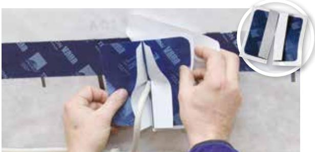
Für die schnelle und dauerhaft sichere Einbindung von bereits eingebauten Kabeln und Leerrohren bis 20 mm.
