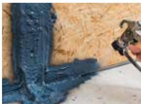
Anschluss Holzbauwände an Betonboden
