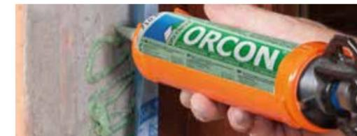
Band mit Klebestreifen auf dem Blendrahmen ansetzen und verkleben. Auf der Leibung Kleberaube vom Anschlusskleber ORCON F im engen Zickzack auftragen und Band in den Kleber legen. Fertig zum Überputzen.
