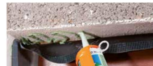
Band mit Klebestreifen auf dem Blendrahmen ansetzen und verkleben. Auf der Leibung Kleberaue vom Anschlusskleber ORCON F im engen Zickzack auftragen und Band in den Kleber legen. Fertig zum Überputzen.
