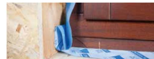
Trennfolie entfernen, Band im Eckbereich falten und untereinander verkleben. Anschließend Band umlaufend luftdicht auf der Leibung verkleben. Band fest anreiben.
