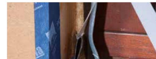
Trennfolie entfernen, Band im Eckbereich falten und untereinander verkleben. Anschließend Band umlaufend schlagregensicher und winddicht auf der Leibung verkleben. Band fest anreiben.
