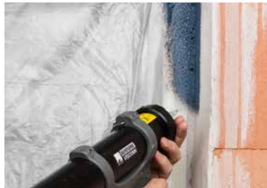
AEROFIXX Auftragswerkzeug für Schlauchbeutel im AEROSANA-System
