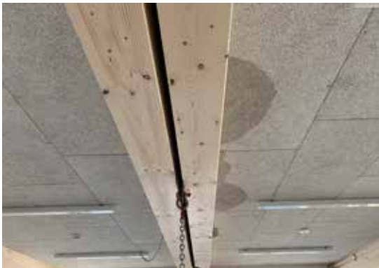
Undichter Modulstoß
