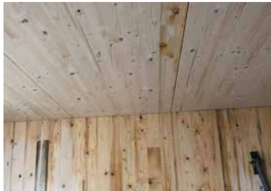
Unschöne Wasserflecken an einer Brettsperrholzdecke
