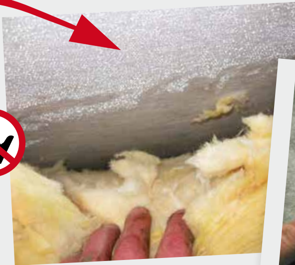
Mikroporöse Bahn: Kein aktiver Feuchtetransport > nasse Konstruktion
