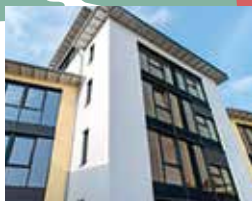
② Norddeutsches Zentrum für Nachhaltiges Bauen GmbH Artilleriestr. 6a 27283 Verden
