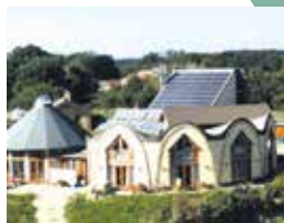
① artefact gMBH Bremsbergallee 35 24960 Glücksburg
