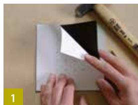
1 Unterlage, EPDM und Schablone ausrichten
