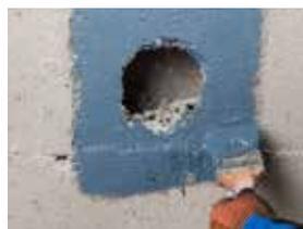
Verschließen von Löchern bis max. 70 mm Durchmesser
