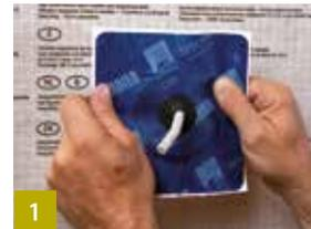
1 Kabel durchziehen und ausrichten
