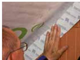
Giebelwand Mauerwerkswand, luftdichten Anschluss herstellen
