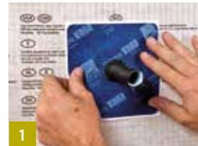
1 Rohr / Kabel durchziehen
