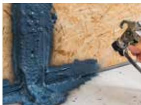
Anschluss Holzrahmenbau-Wände an Betonboden
