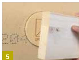
5 CLOX bündig setzen, z.B. mit Zulage
