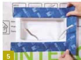
5 Luftdicht anschließen mit
