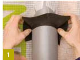
1 Manschette über Rohr ziehen und ausrichten
