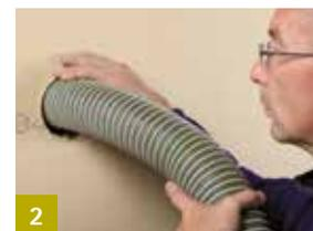
2 Dämmstoff einblasen
