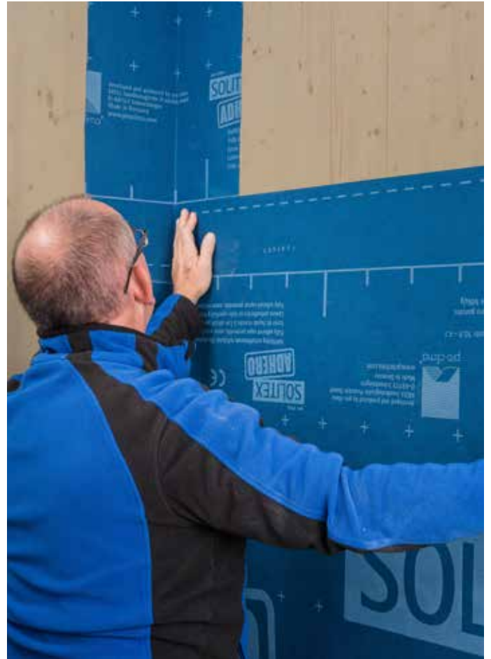
Luftdichtung und Witterungsschutz Wand
