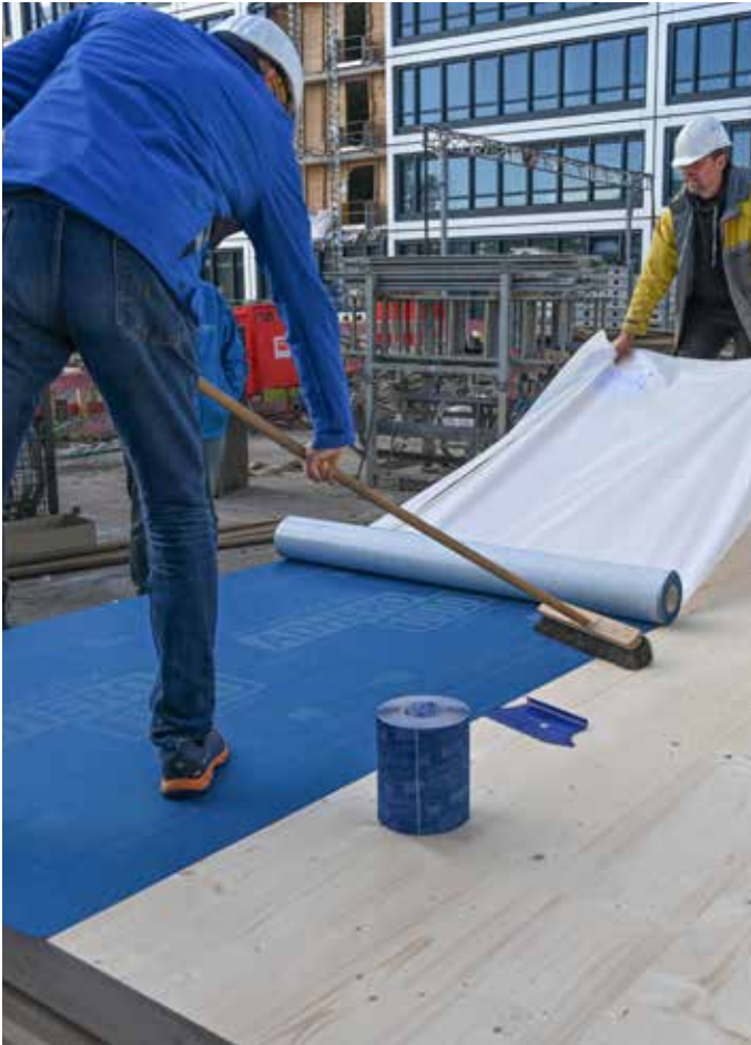
Bauzeitabdichtung Decke
