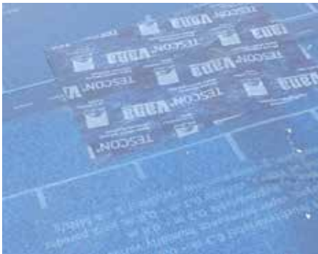
Zum Abdichten v. beschädigten Stellen i. d. Bahn.
