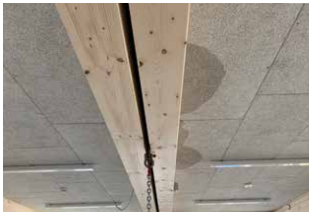
Undichter Modulstoß
