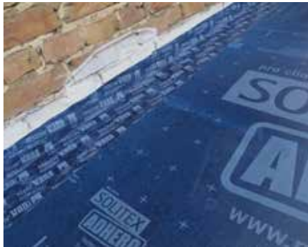
Für Anschlüsse an angrenzende Bauteile, wie aufgehende Wände aus Mauerwerk, Beton, Holz und Holzwerkstoffplatten.
