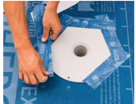
Zum Anschluss von Gullys zur Flächenentwässerung an SOLITEX ADHERO.
