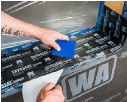
Unterfensterbank oder auch Feuchteschutz während der Bauphase
