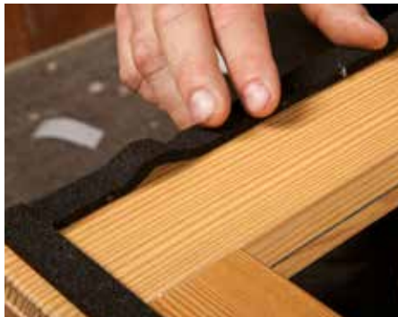
Band umlaufend verlegen. Stumpfe, gestauchte Stöße an den Ecken
