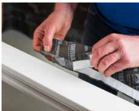
Oben am Blendrahmen verkleben
