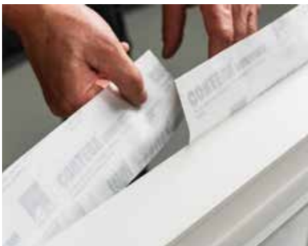
Umlaufend und überlappend verkleben
