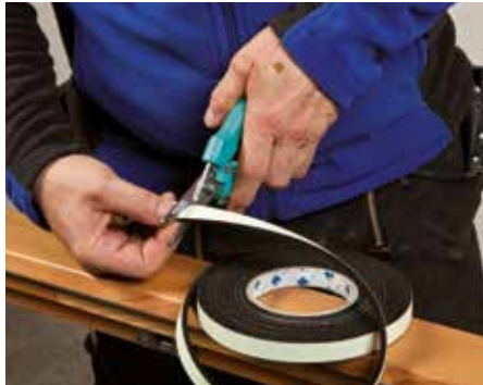
Überkomprimierten Anfang abschneiden
