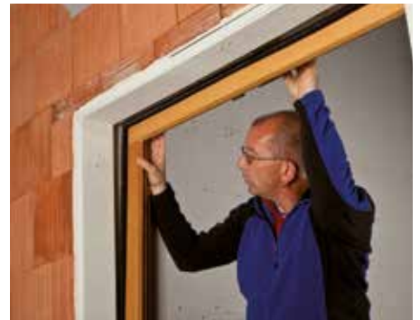
Fenster fachgerecht einsetzen und mit einem geeigneten Befestigungssystem fixieren
