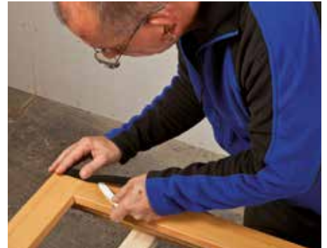
Band auf dem Blendrahmen anbringen
