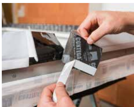
Umlaufend und überlappend verkleben
