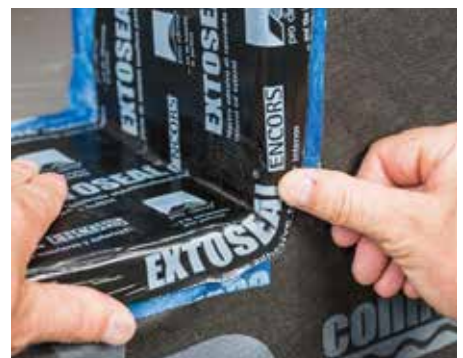
In Eckbereichen extrem dehnfähig
