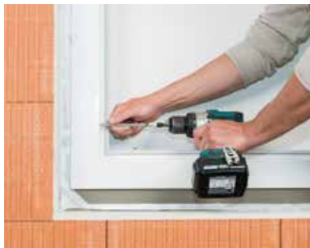
Fenster einsetzen und Fuge dämmen
