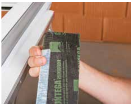
Trennfolienstreifen abziehen
