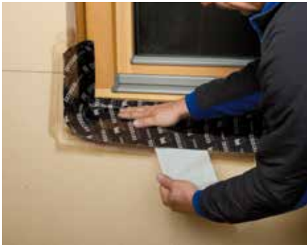
Nachträglicher Einbau der Unterfensterbank
