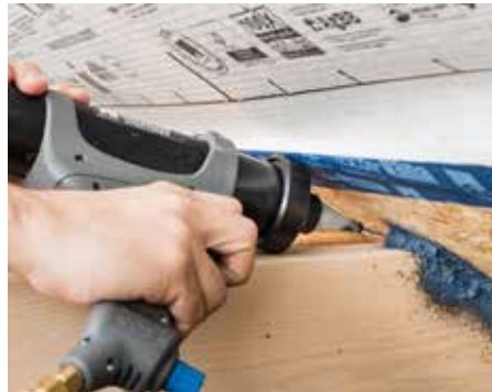
Schwer erreichbare Zangenanschlüsse
