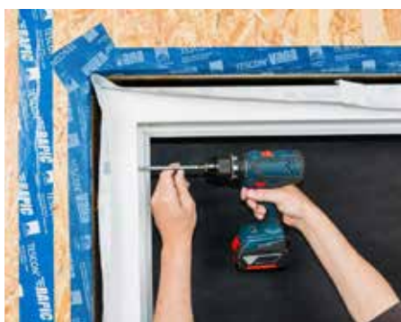
Fenster einsetzen und Fuge dämmen
