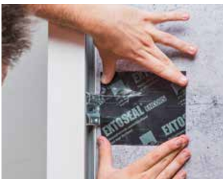
Wasserführende Verklebung von Befestigungswinkeln
