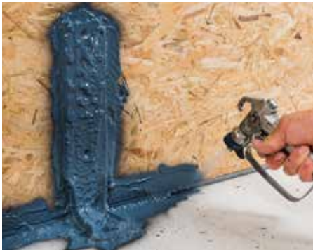
Luftdichtes Übersprühen von Befestigungswinkeln
