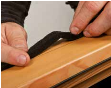
Band gestaucht verlegen
