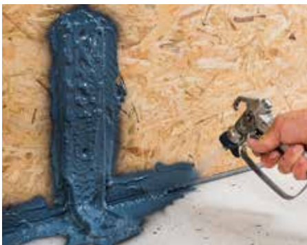
Luftdichtes Übersprühen von Befestigungswinkeln,
