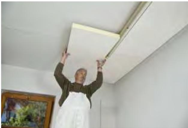
*Leicht im Gewicht und hoch in der Dämmleistung: puren MV-KD für die Dämmung der Kellerdecke bietet sicheren Schutz vor Kälte von unten und kann mit Dispersionsfarben einfach gestrichen werden.*
