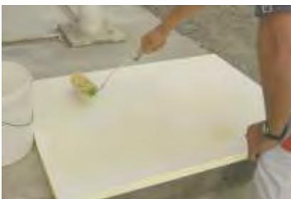
*Versehen mit einer geeigneten Haftbrücke wie beispielsweise epasit pk, die flächig aufgetragen wird, lässt sich die puren Kellerdeckendämmung problemlos mit Plattenklebern wie epatherm etk auch auf mineralischen Untergründen (Massivdecke) verkleben.*
