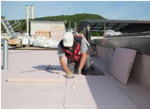
puren PIR Class C Dämmplatten sind besonders formstabil und brandsicher (C-s3, d0 nach DIN EN 13501-1).
