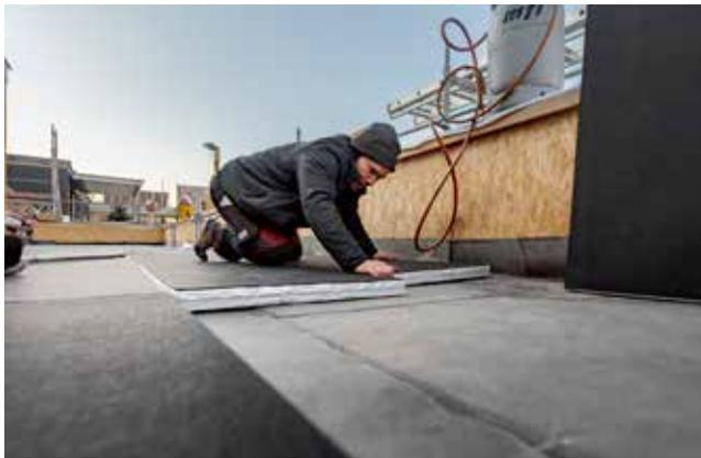
puren VIP Gum-2 eignet sich hervorragend für die besonders dünne Dimensionierung von Flachdachaufbauten.
