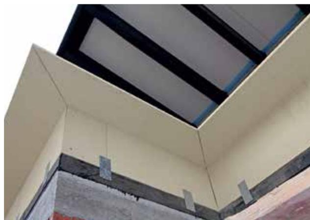
Die Befestigung zur Deckenstirnseite erfolgt mit handelsüblichen Flachverbindern 180x90x2mm. Pro Attikaelement sind 3 Flachverbinder erforderlich. Die Verlegung im Versatz zu den deckenseitigen Winkelverbindern vermeidet Berührungen der Verbindungsmittel.
