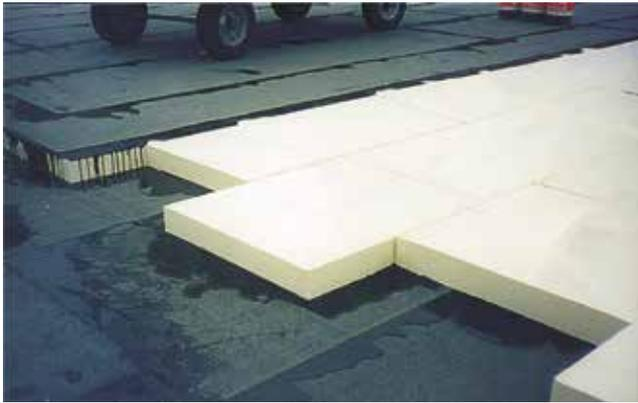
puren NE-B2 druckfest ohne Deckschicht besitzt eine besonders hohe Druckstabilität.
