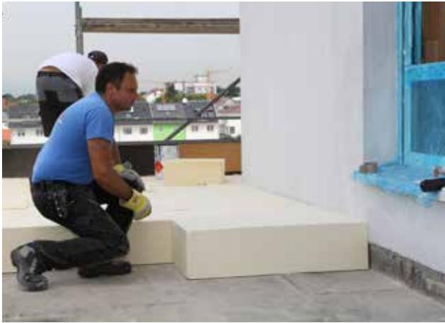
puren NE-B2 druckfest ohne Deckschicht besitzt eine besonders hohe Druckstabilität.
