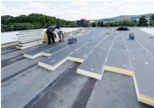
Verlegebeispiel unter Verwendung einer speziellen kaltselbstklebenden Unterlagsbahn.
