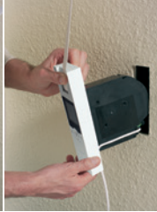
3. RolloTron einbauen
