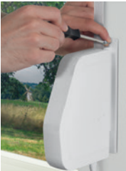
1. Manuellen Gurtwickler demontieren
