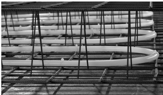
Abb. 73 Das PexPenta-Heizrohr wird mit Kabelbindern auf der unteren Bewehrung fixiert
