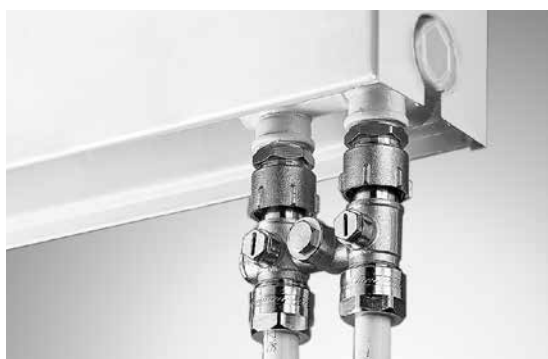
Abb. 78 1-Rohr-Anschluss
