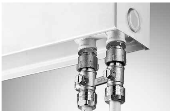
Abb. 53 2-Rohr-Anschluss
