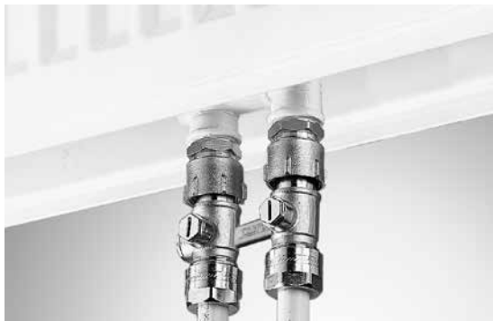
Abb. 31 2-Rohr-Anschluss
