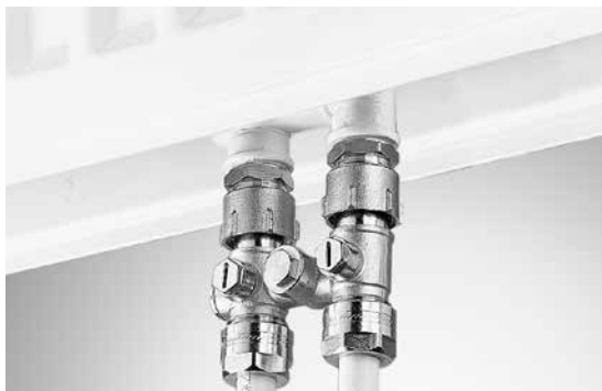
Abb. 32 1-Rohr-Anschluss
