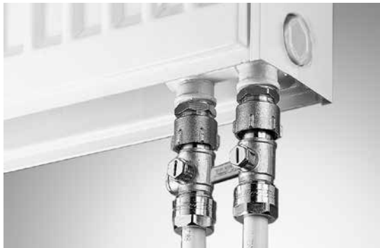
Abb. 23 2-Rohr-Anschluss
