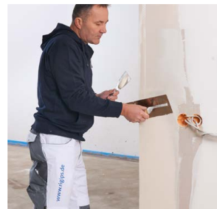
Das Finish erfolgt mit Rigips ProMix Plus.
