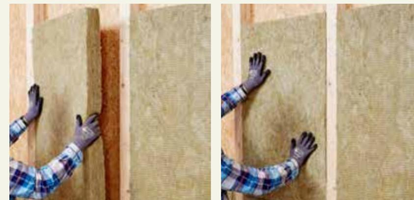
Flexirock 035 wird mit der langen Seite bündig am Holzstiel angesetzt.
