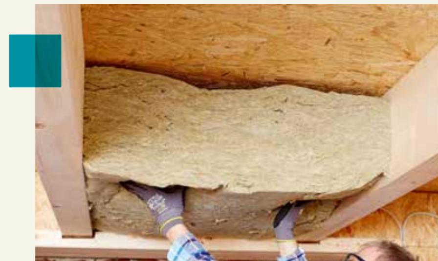
Die federnde Wirkung verschafft der Flexirock 035 einen festen und sicheren Halt zwischen den Stielen. Sie füllt das Gefach vollständig aus. Wärme- und Schallbrücken werden so vermieden.
