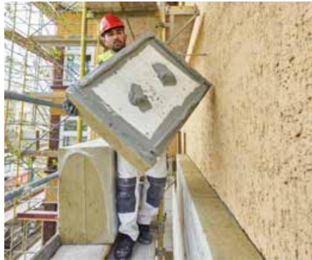
Coverrock X-2 – eine konsequente Weiterentwicklung der seit Jahren bewährten Dämmplatten der Coverrock-Familie für die Außenwanddämmung mit WDV-Systemen.
