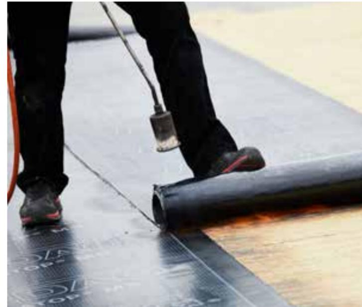
Die planebene Oberfläche von Bitrock ermöglicht ein direktes Aufschweißen der Unterlagsbahn
