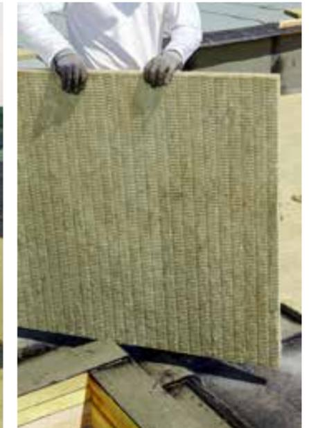
Verlegung der RP-TF auf ausgebessertem altem Dachaufbau
