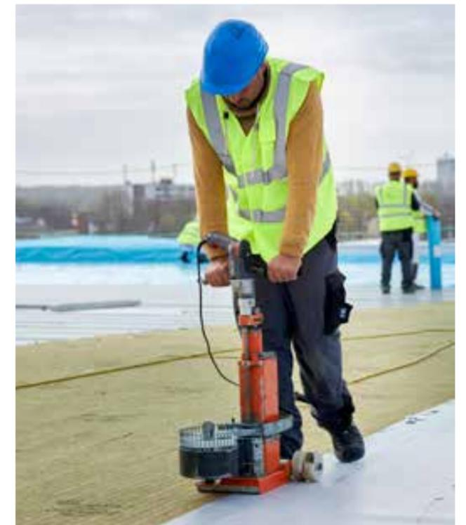
Dachaufbau mechanisch befestigt
