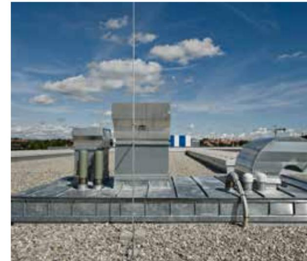
Dachaufbau lose verlegt mit Auflast
