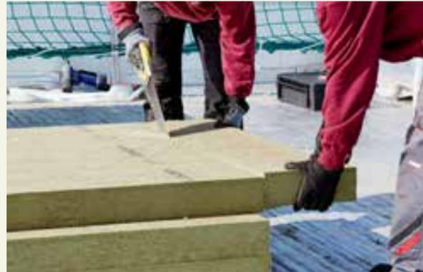
Die Dämmplatten lassen sich leicht zuschneiden.
