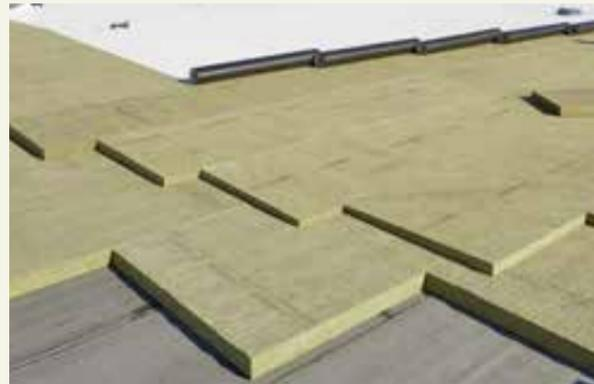
Die Verlegung der Dämmplatten erfolgt im Verband.
