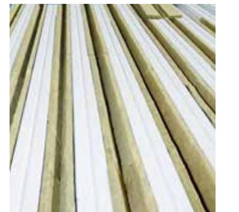
Einlegen von Akustik-Profilfüllern in Trapezprofile
