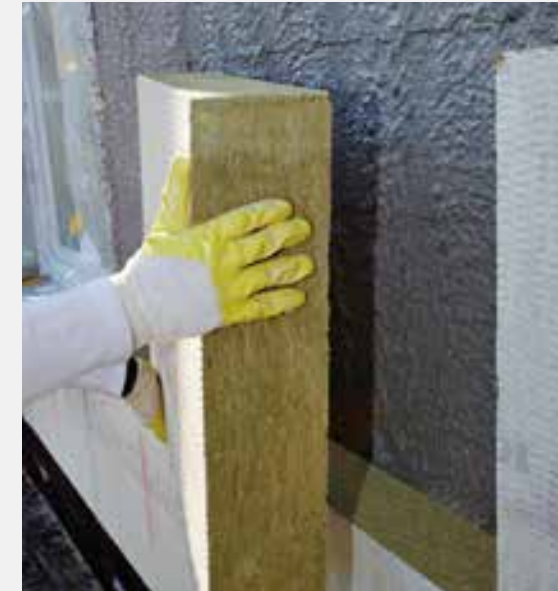
Die klebeseitige Beschichtung der Coverrock II erlaubt den zeitsparenden Auftrag des Klebemörtels auf den Untergrund.
