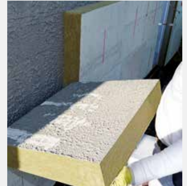
Eine Verklebung der Coverrock II von 40 % ist mindestens zu erreichen.
