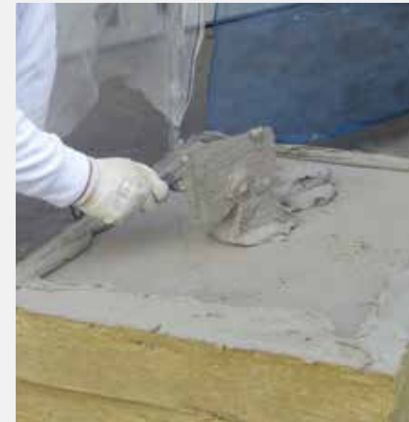
Aufbringen des Klebemörtels im Wulst-Punkt-Verfahren auf die mittels Pressspachtelung vorbereitete, unbeschichtete Coverrock.
