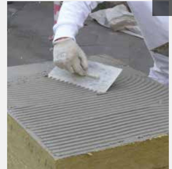
Vollflächig aufgetragener Klebemörtel für die Verklebung an einer planebenen Wand. Auch hier wird die unbeschichtete Coverrock per Pressspachtelung vorbereitet.
