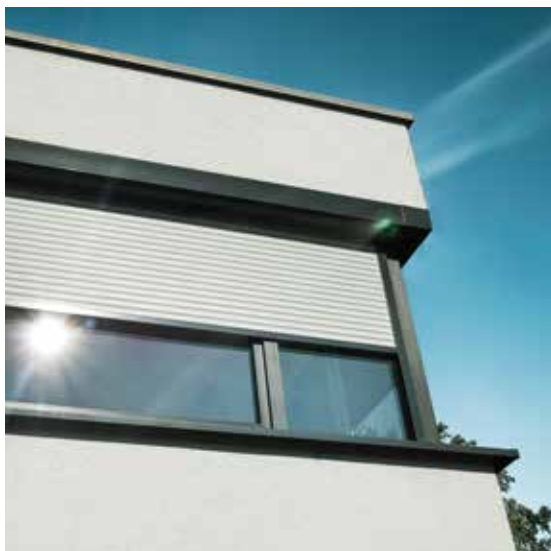
Vorbaurollladen QUADRO flächenbündig mit der Fassade montiert.
