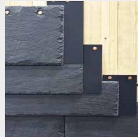
Die Metallspließe werden mit 2 Nägeln befestigt und müssen mit der Gebindelinie abschließen.
