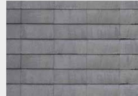
Die Variable Deckung wird mit rechteckigen und /oder quadratischen Schiefen mit verschiedenen Formaten gedeckt. Die Besonderheit sind zwei diagonal gegenüberliegende abgeschrägte Ecken.
