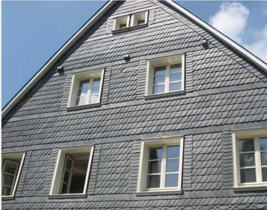
Die Schuppendeckung wird als Wandeindeckung analog zur Dacheindeckung ausgeführt. Im Gegensatz zur Dacheindeckung können die Deckgebilde auch ohne Gebindesteigung ausgeführt werden und müssen mind. 40 mm in der Steinhöhe überdeckt werden. Schuppengrößen s. Tabelle Seite 23.
