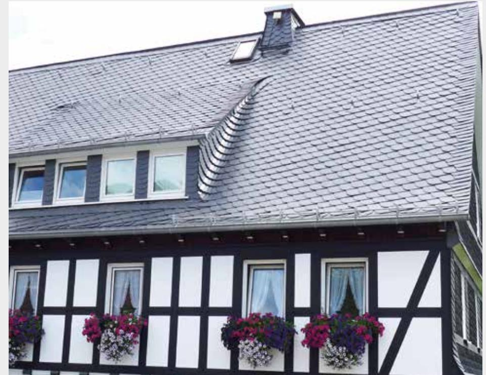
Die Bogenschnitt- und Universaldeckung wird mit quadratischen Schiefen mit Bogen ausgeführt. Die Deckung erfolgt mit Gebindesteigung, wobei diese abhängig von der Dachneigung ist und zwischen der Mindest- und Höchstgebindesteigung liegen muss.
