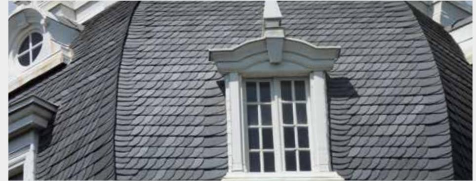
Befestigt werden die Steine am Ort mit mindestens 3 Schiefernägeln oder -stiften. Eine versetzte Befestigung ist anzuordnen. An der äußeren oberen Ecke müssen die Steine am Ort gestutzt oder abgerundet werden (wasserabweisender Schnitt).
