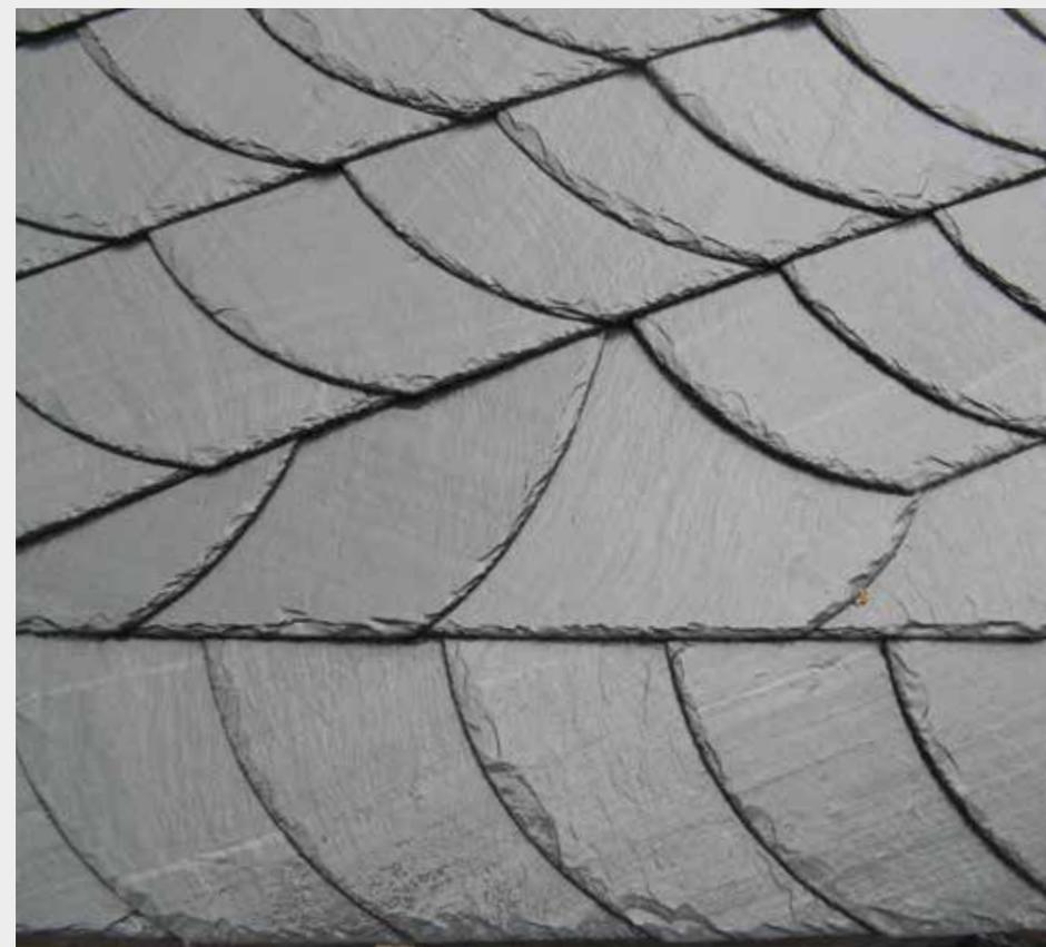
Ein Traufgebinde (Reparaturgebinde) kann außer bei der Altdeutschen Doppeldeckung und der Rechteckdoppeldeckung bei der Altdeutschen Deckung an der Traufe gedeckt werden. Dieses ist jedoch nur in Verbindung mit dem Einbau von Schneefangschutzsystemen etc. erlaubt. Die Seitenüberdeckung ist in diesem Fall um mindestens 1/3 gegenüber der Flächendeckung zu erhöhen.
