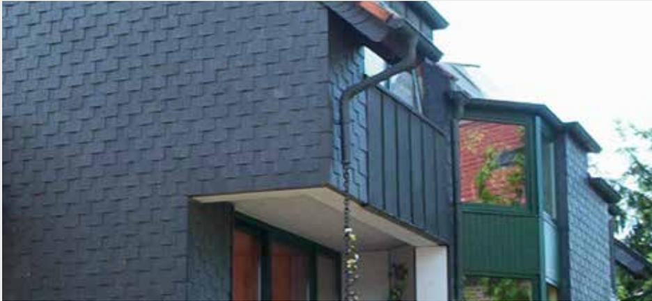
Die Gezogene Deckung erfolgt mit rechteckigen oder quadratischen Schiefen, wobei vollkantige oder eckengestutzte Steine möglich sind. Die Schiefer werden mit Höhen- und Seitenüberdeckung auf Vollschalung, Lattung oder Metallprofilen verlegt.
