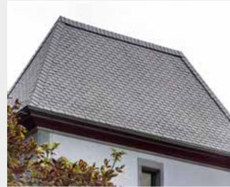
Die Befestigung erfolgt mit einem Einschlaghaken oder mindestens zwei Schiefernägeln oder -stiften. Bei Deckung auf Lattung kann die Befestigung mit einem Klammerhaken erfolgen.
