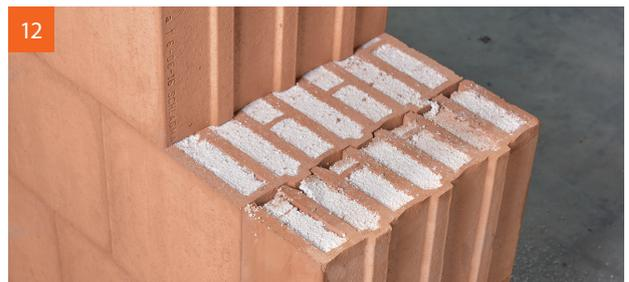
Der Ausgleichsziegel ist wärmebrückenfrei versetzt.
