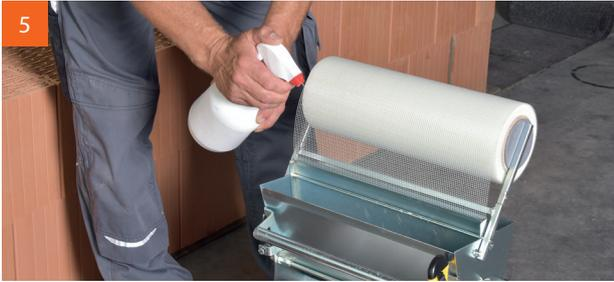
Die V.Plus®-Walze vor dem Befüllen mit Trennmittel (Schalöl) einsprühen. Das erleichtert die spätere Reinigung.
