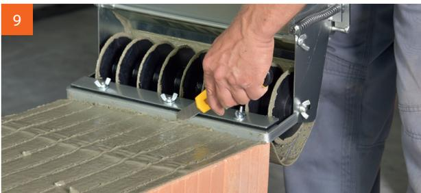
Abschneiden des V.Plus®-Glasfilamentgewebes mit Hilfe der Abschnittleiste und einem Teppichmesser.
