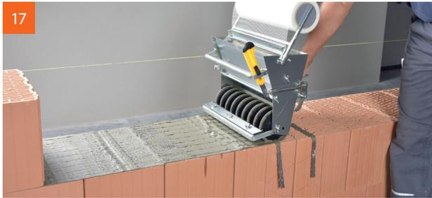
17 Anschließend wird der Mörtel über die Flachstahlanker gerollt.
