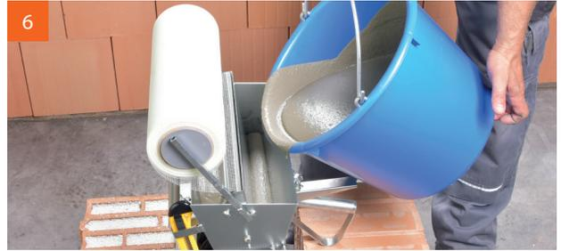
Befüllen der V.Plus®-Walze mit Dünnbettmörtel.
