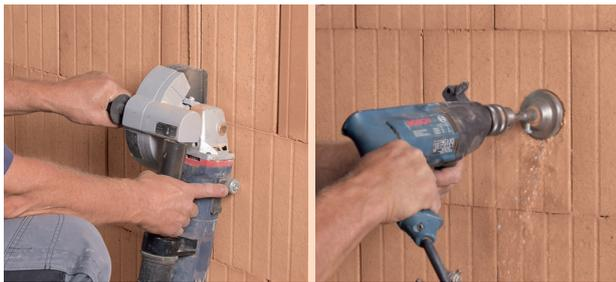
Schlitz und Kronenbohrung für Elektroboxen
